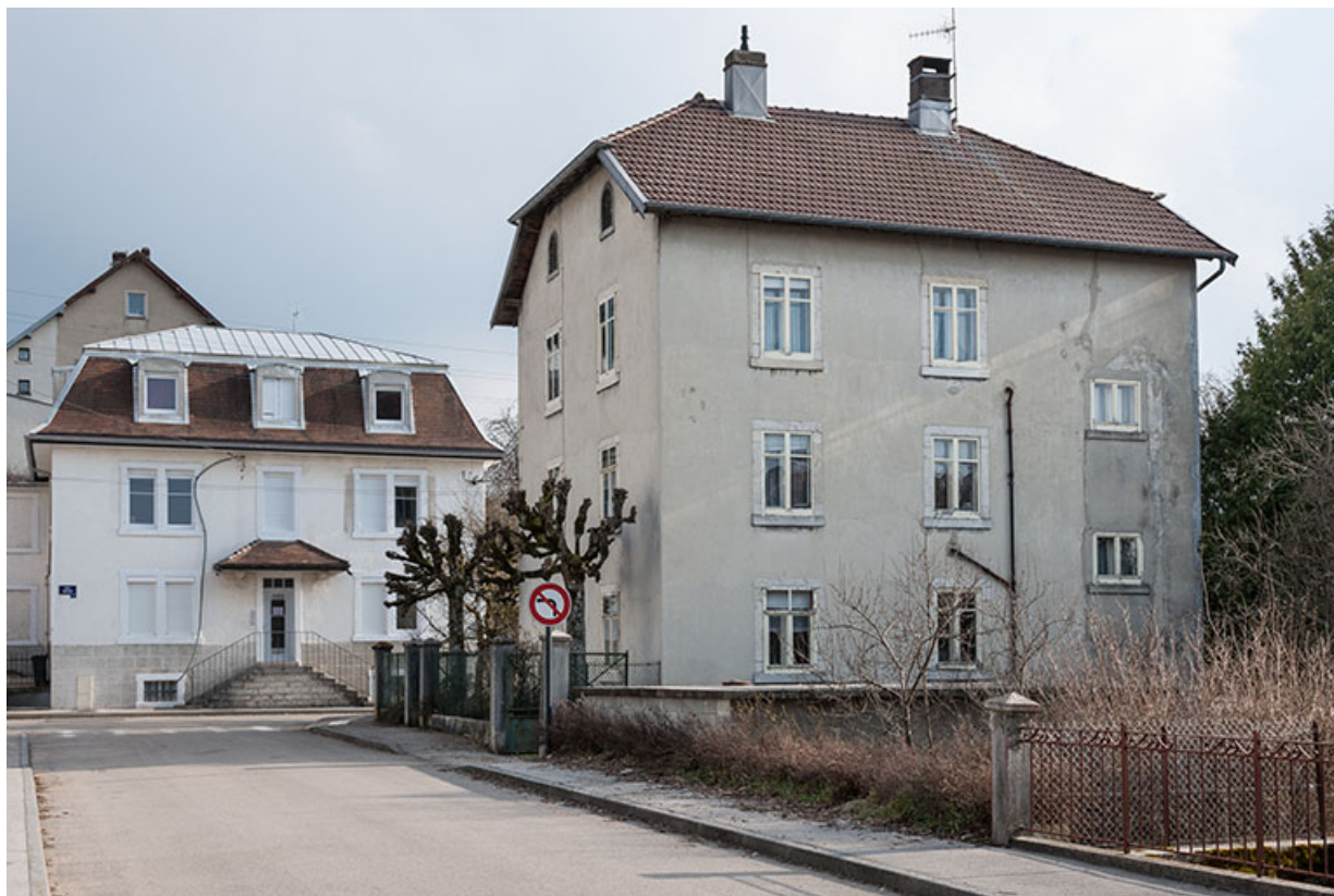
Vue d'ensemble depuis le nord (façade postérieure). A gauche, l'ancienne usine Wasner-Ruffier. 25, Charquemont, 12 Rue Neuve
