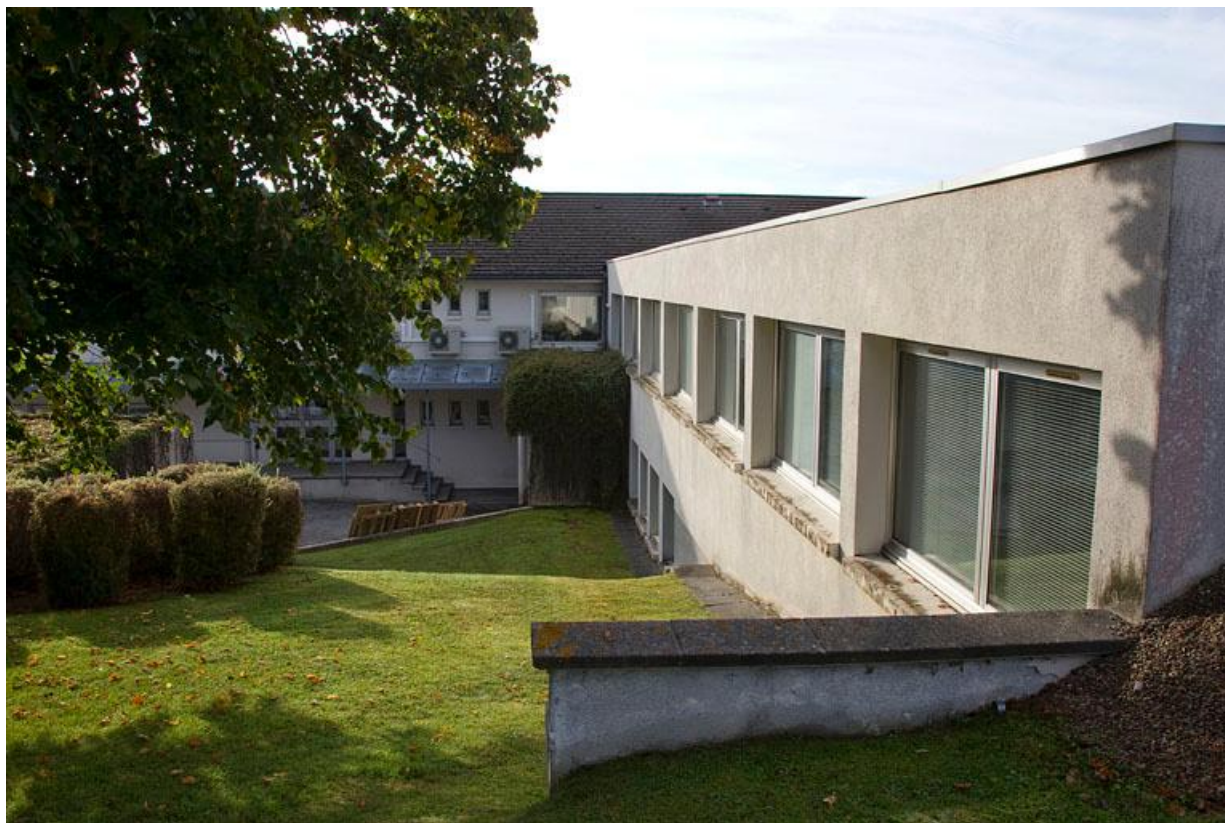
Extension au nord et façade postérieure du bâtiment d'origine.
