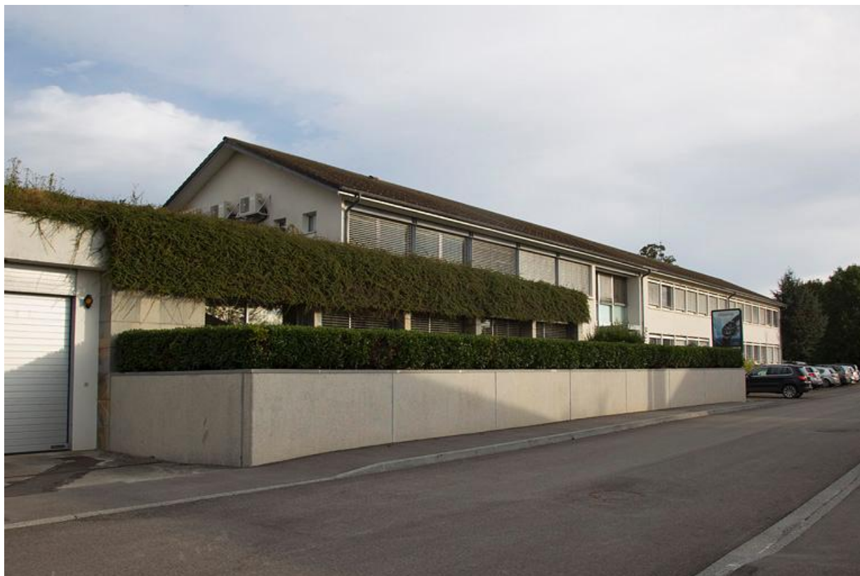
Une usine des années 1970 à 1990 : usine de montres Herbelin (9 rue de la 1ère Armée). 25, Charquemont, 9 rue de la 1ère Armée
