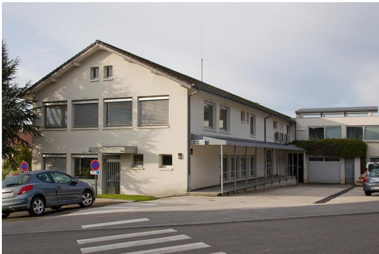
Bâtiment d'origine : façades latérale droite et postérieure.
