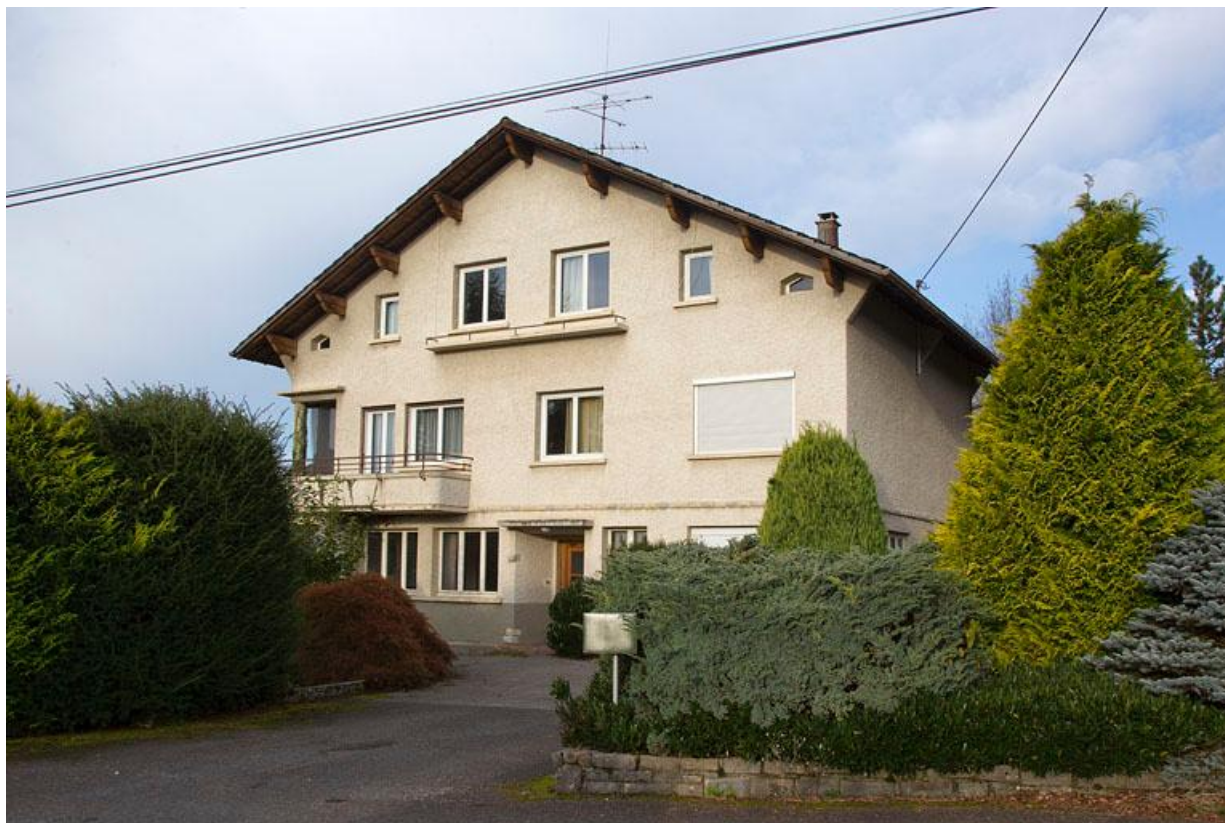
Une maison de 1956-1957 : atelier d'horlogerie de Michel Herbelin (13 rue des Villas). 25, Charquemont
