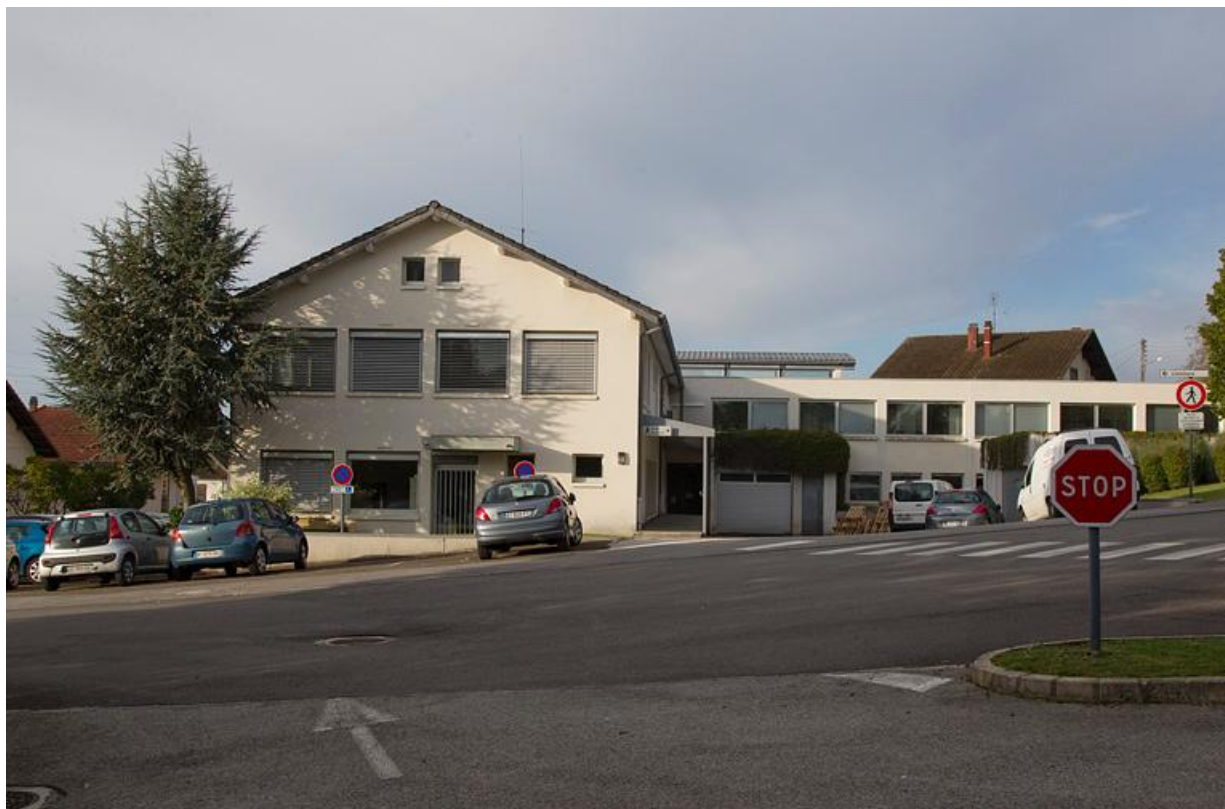
Vue d'ensemble, depuis le nord-est. 25, Charquemont, 9 rue de la 1ère Armée
