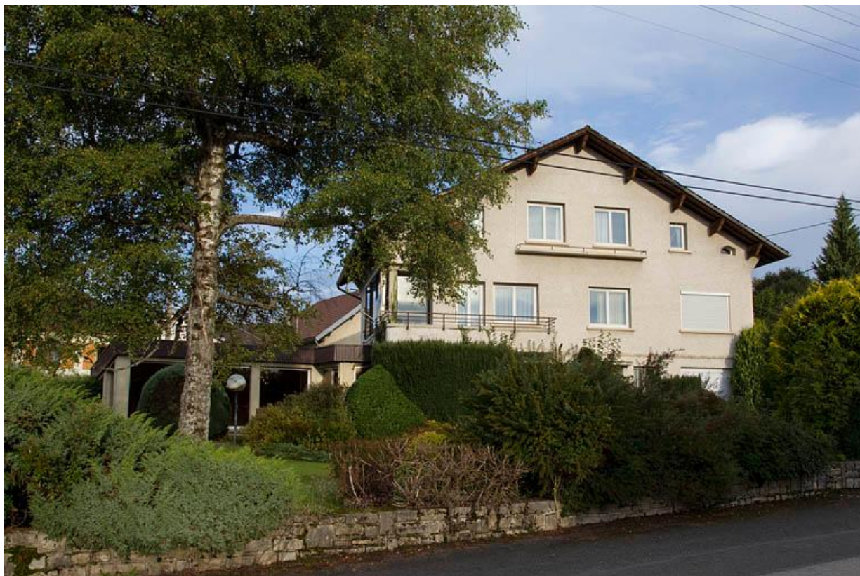
Logement patronal au 13 rue des Villas (l'ancien atelier de fabrication est visible à gauche). 25, Charquemont, 9 rue de la 1ère Armée
