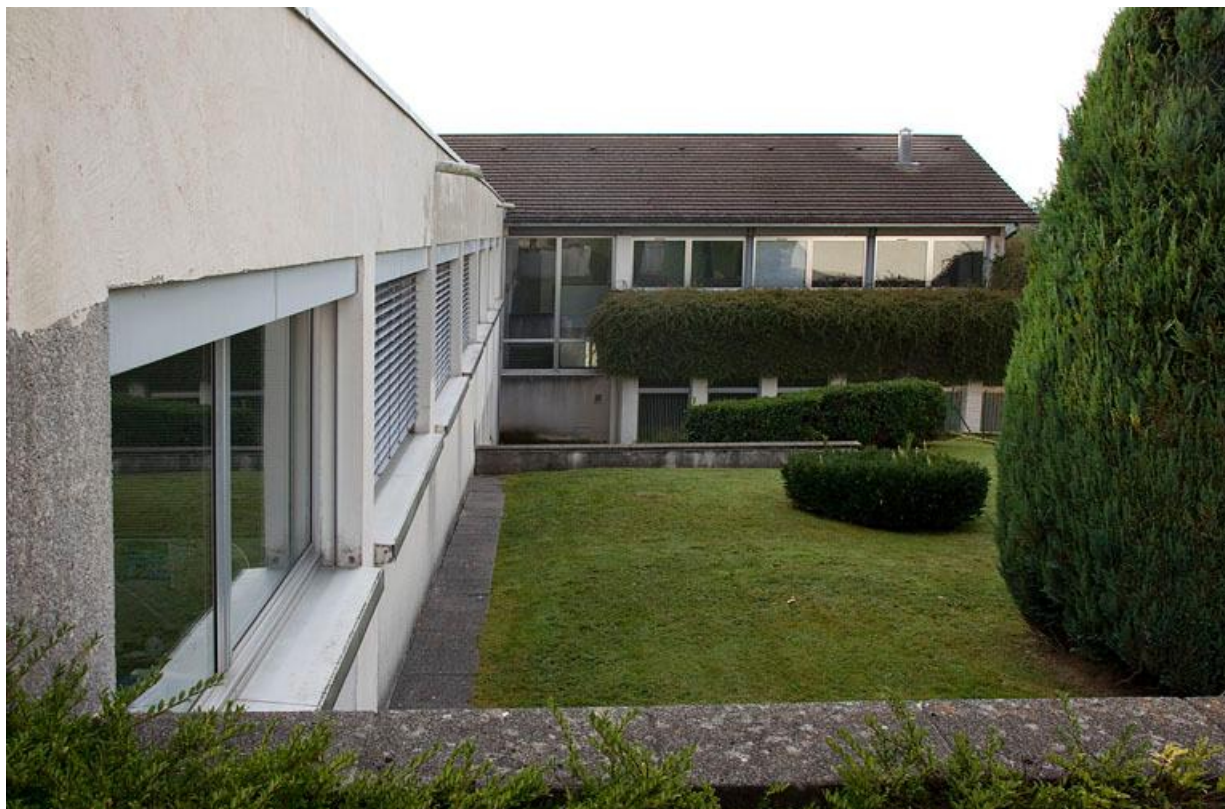
Extension au nord et façade postérieure de l'extension ouest.
