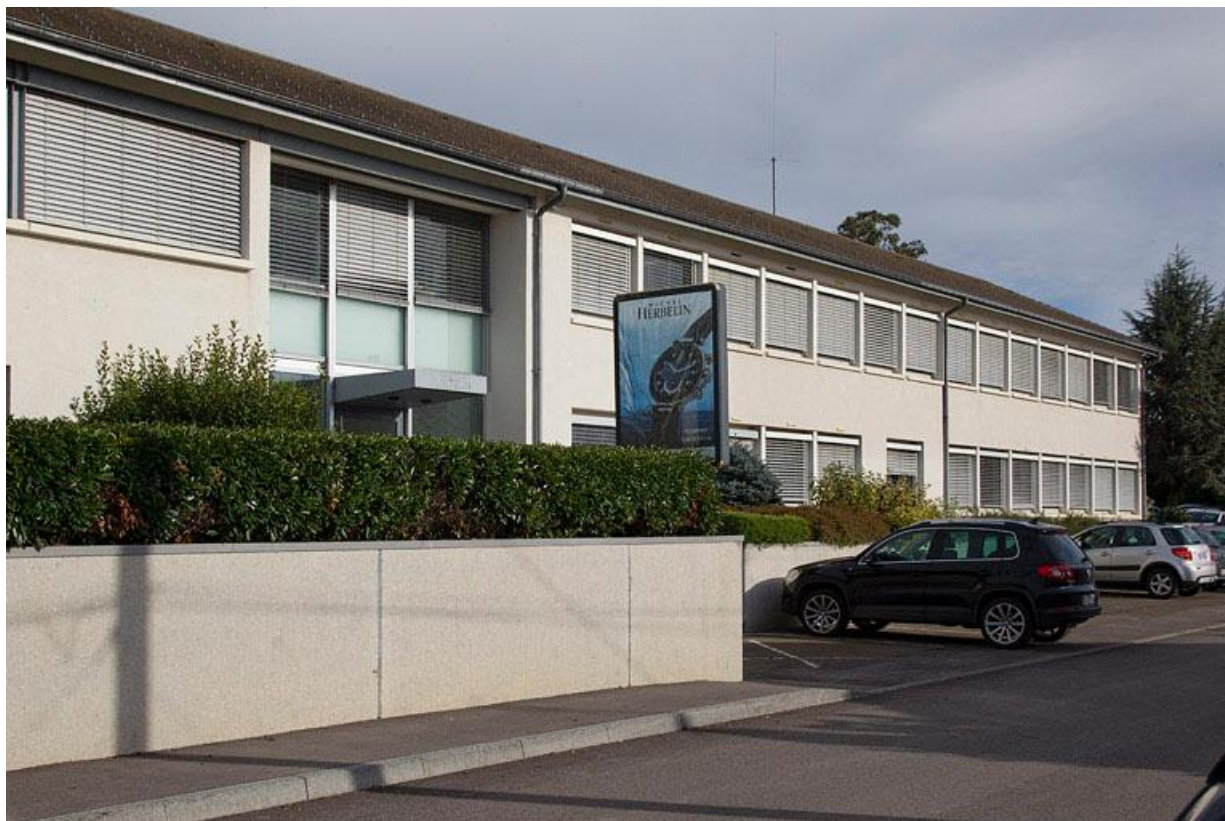
Extension ouest et bâtiment d'origine : façade sur la rue de la 1ère Armée. 25, Charquemont, 9 rue de la 1ère Armée
