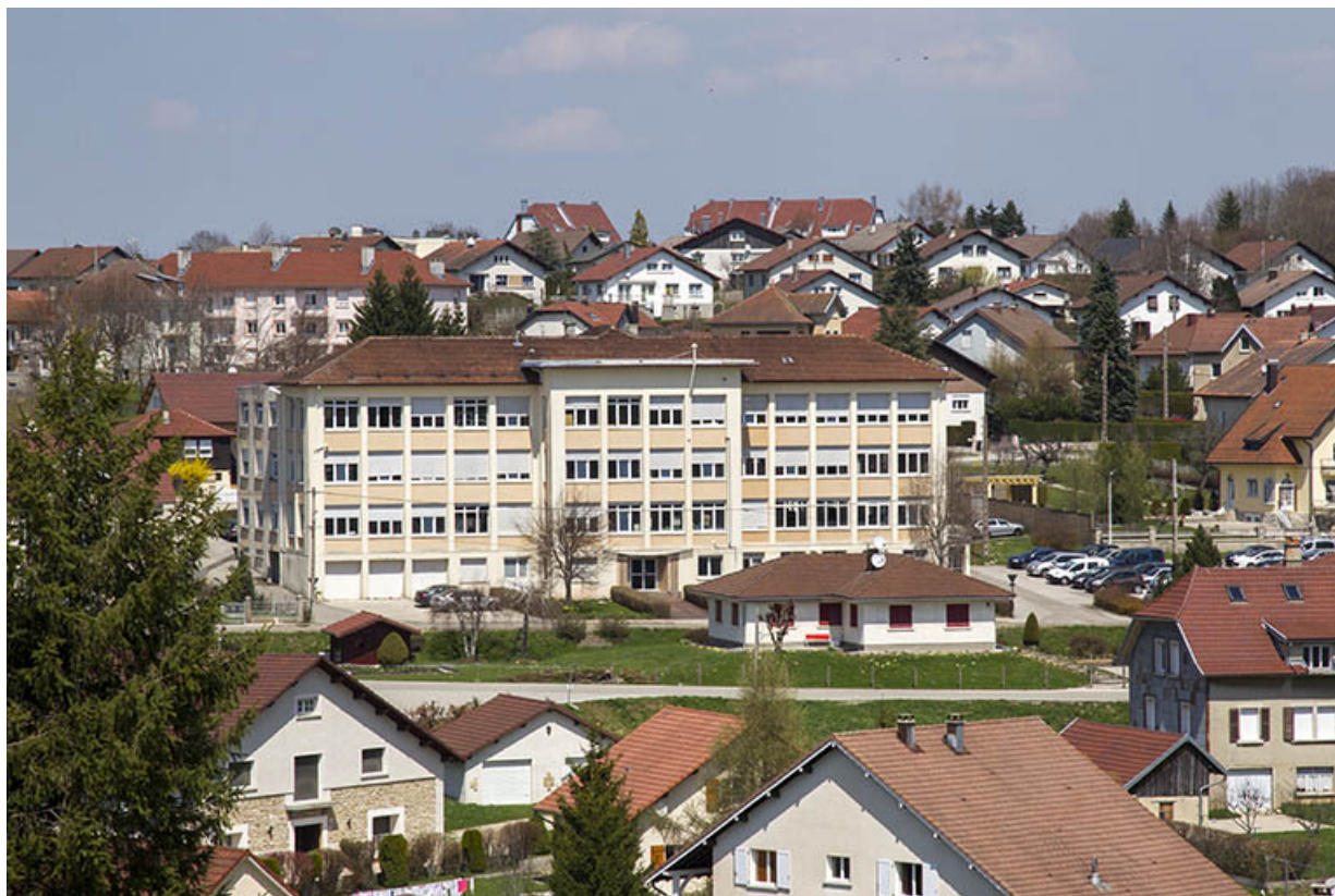
Une usine des années 1950 (architectes Oesch et Rossier) aux années 2000 : usine de taille de pierres pour l'horlogerie, de décolletage et de polissage Rubis-Précis (18 rue de Besançon).
