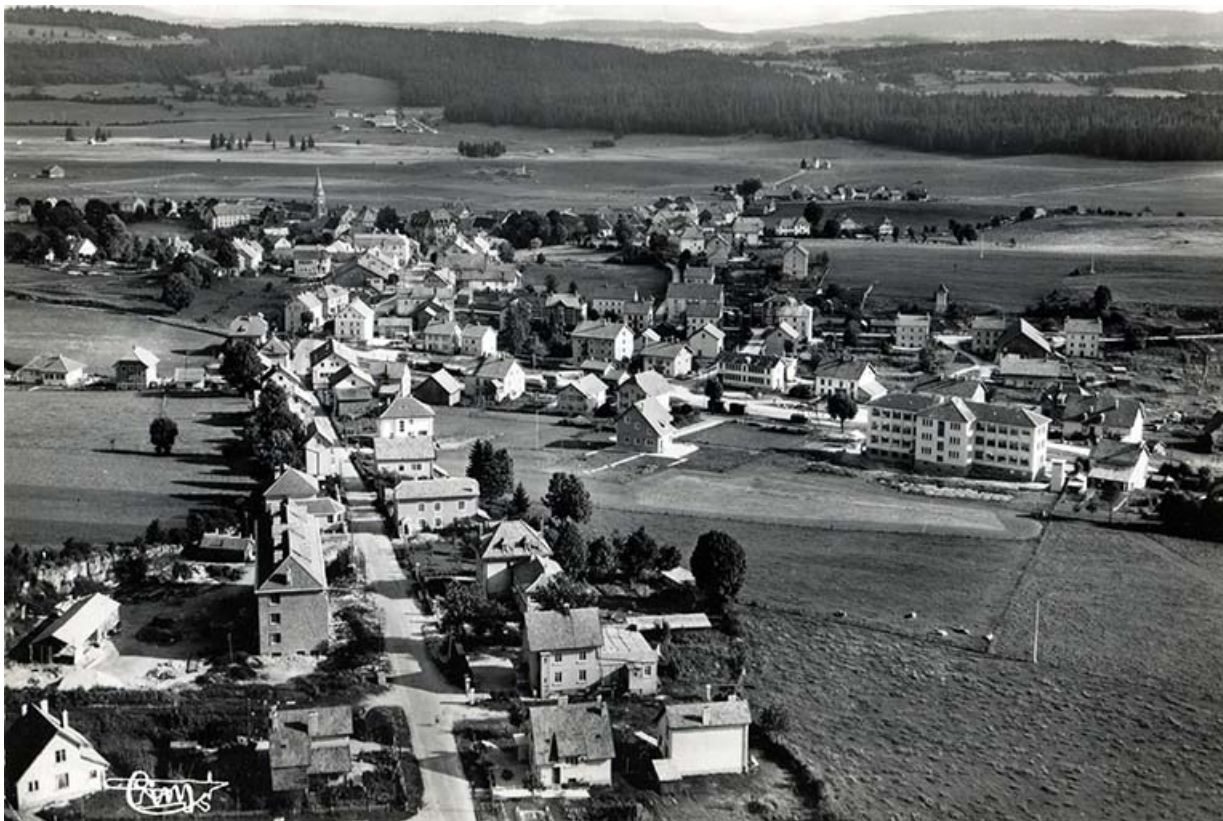
Charquemont (Doubs). 11058 - Vue générale aérienne, entre 1951 et 1958. La maison se trouve entre l'usine Rubis-Précis et le transformateur, à gauche de la scierie.
