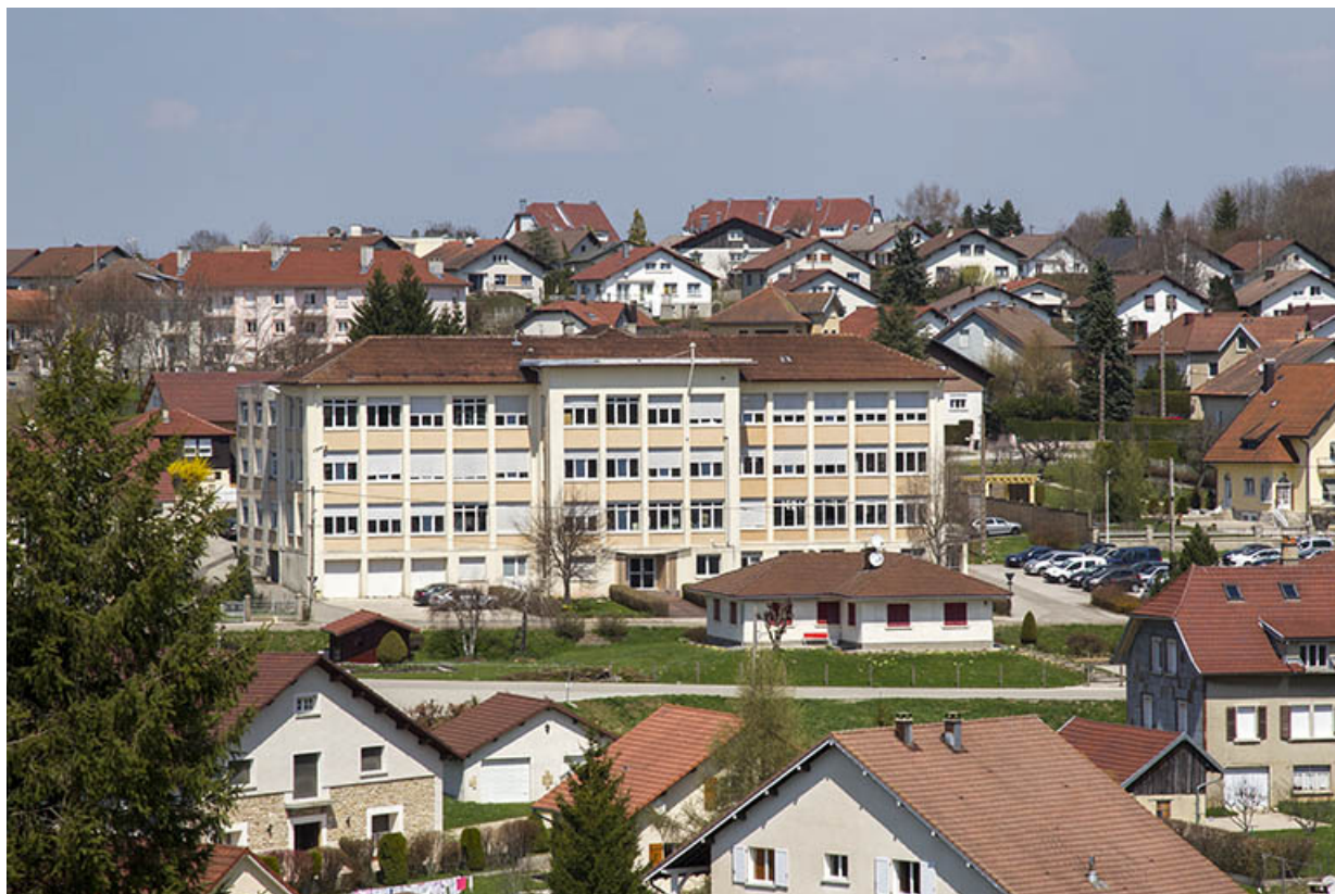
Une usine des années 1950 (architectes Oesch et Rossier) aux années 2000 : usine de taille de pierres pour l'horlogerie, de décolletage et de polissage Rubis-Précis (18 rue de Besançon).
