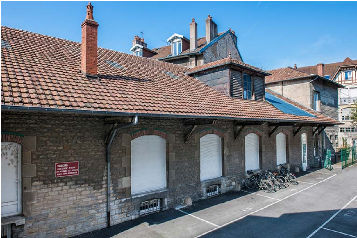
L'entrepôt avant sa surélévation en 2003 : façade antérieure de trois quarts gauche.
