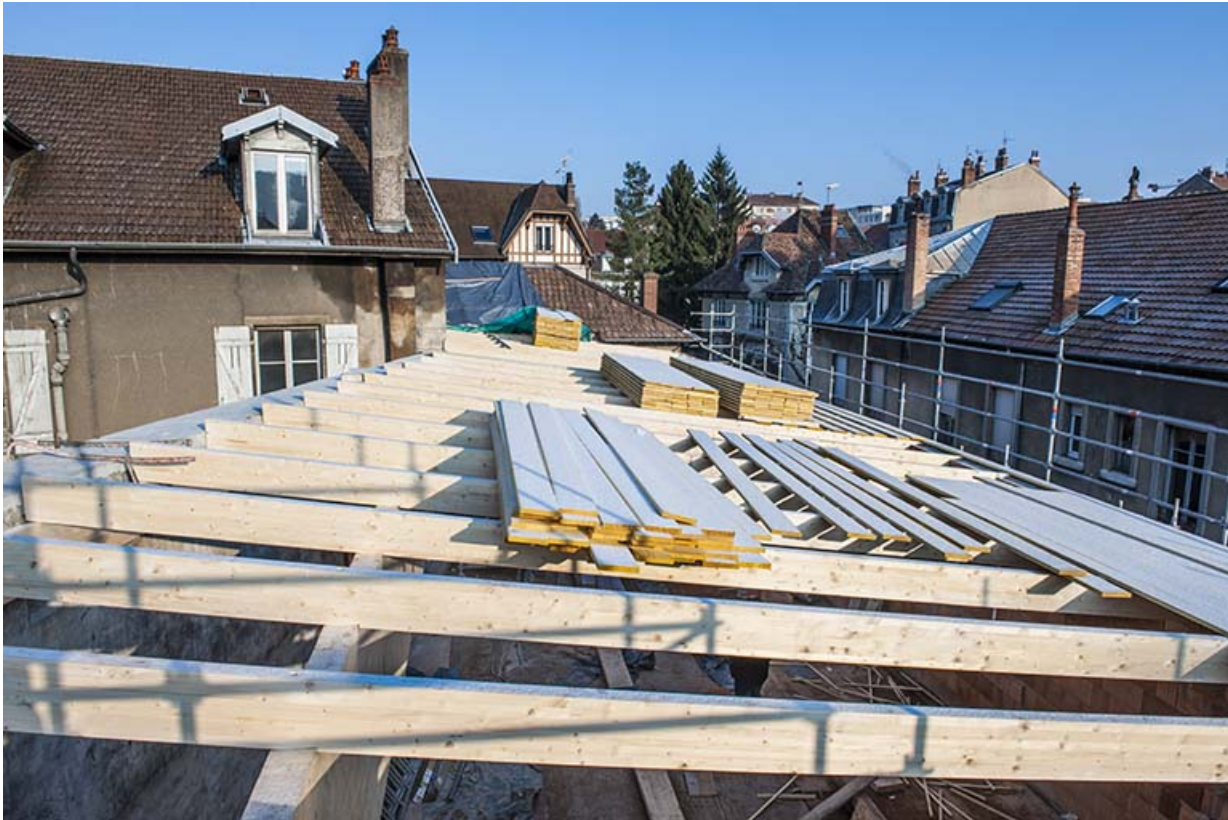
L'entrepôt en cours de surélévation en 2003 : la charpente.
