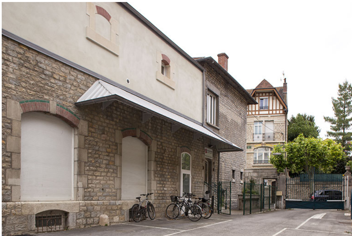
Entrepôt : façade antérieure de trois quarts gauche.
