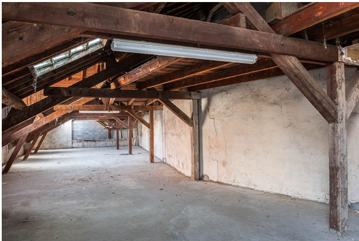
L'entrepôt avant sa surélévation en 2003 : la charpente depuis l'entrée.
