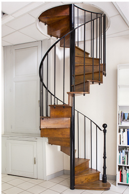
Entrepôt, rez-de-chaussée : escalier en vis pour l'accès à l'étage.
