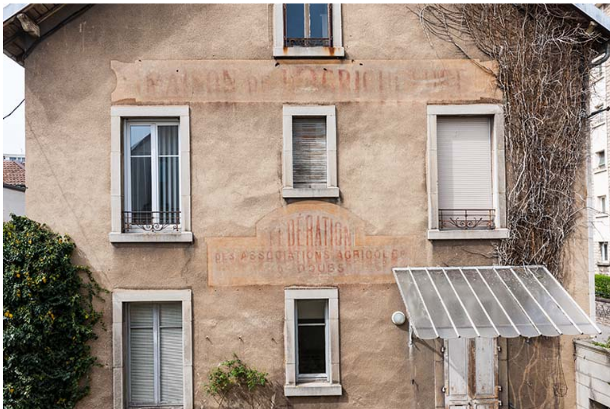
Bâtiment de l'administration : inscriptions sur la façade latérale gauche.
