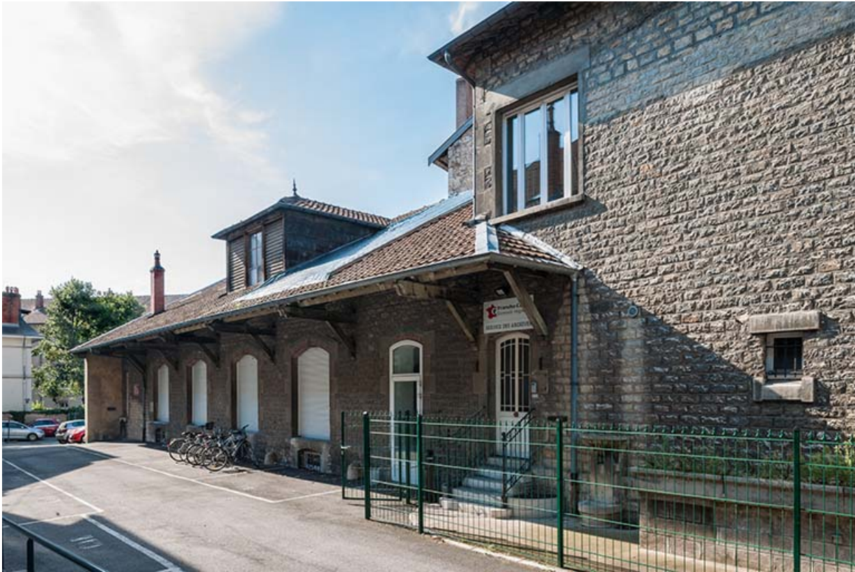
L'entrepôt avant sa surélévation en 2003 : façade antérieure de trois quarts droite. 25, Besançon, 1 ter et 3 rue Victor Delavelle
