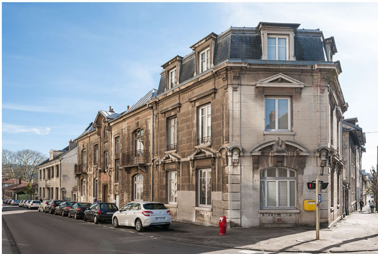
Bâtiment de l'administration : façade sur la rue Delavelle, depuis le nord.
