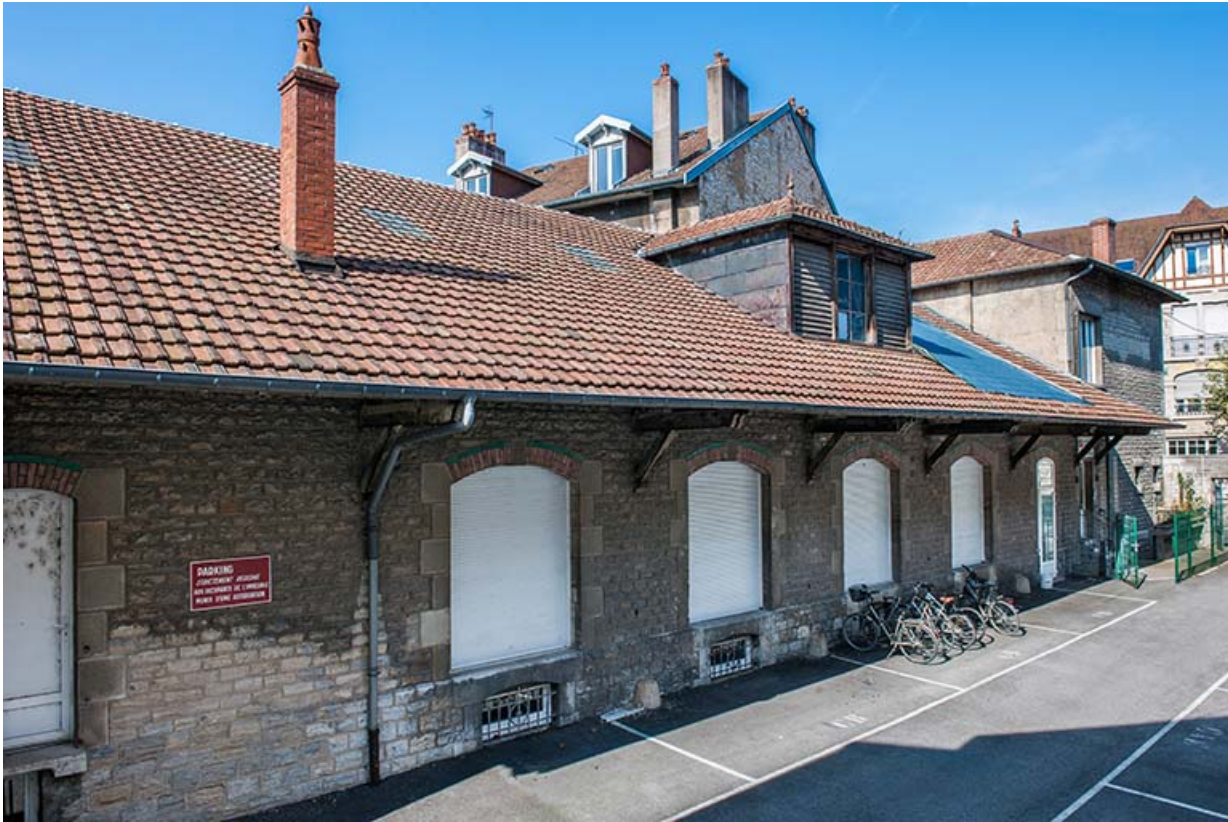
L'entrepôt avant sa surélévation en 2003 : façade antérieure de trois quarts gauche. 25, Besançon, 1 ter et 3 rue Victor Delavelle
