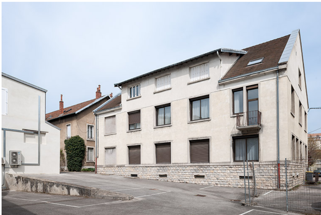
Siège de la Caisse régionale de Crédit agricole : façade postérieure, de trois quarts droite.
