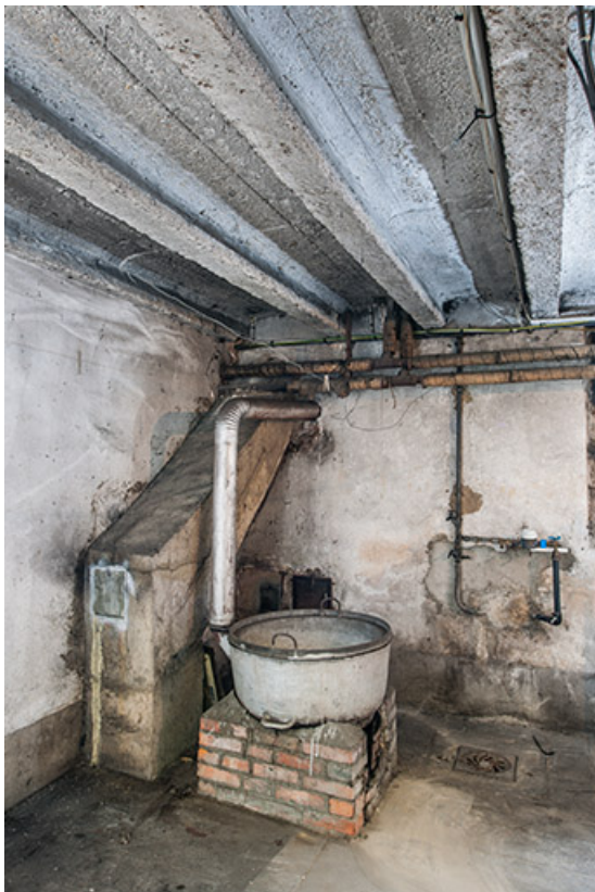
Bâtiment de l'administration, sous-sol : buanderie et son chaudron à lessive. 25, Besançon, 1 ter et 3 rue Victor Delavelle
