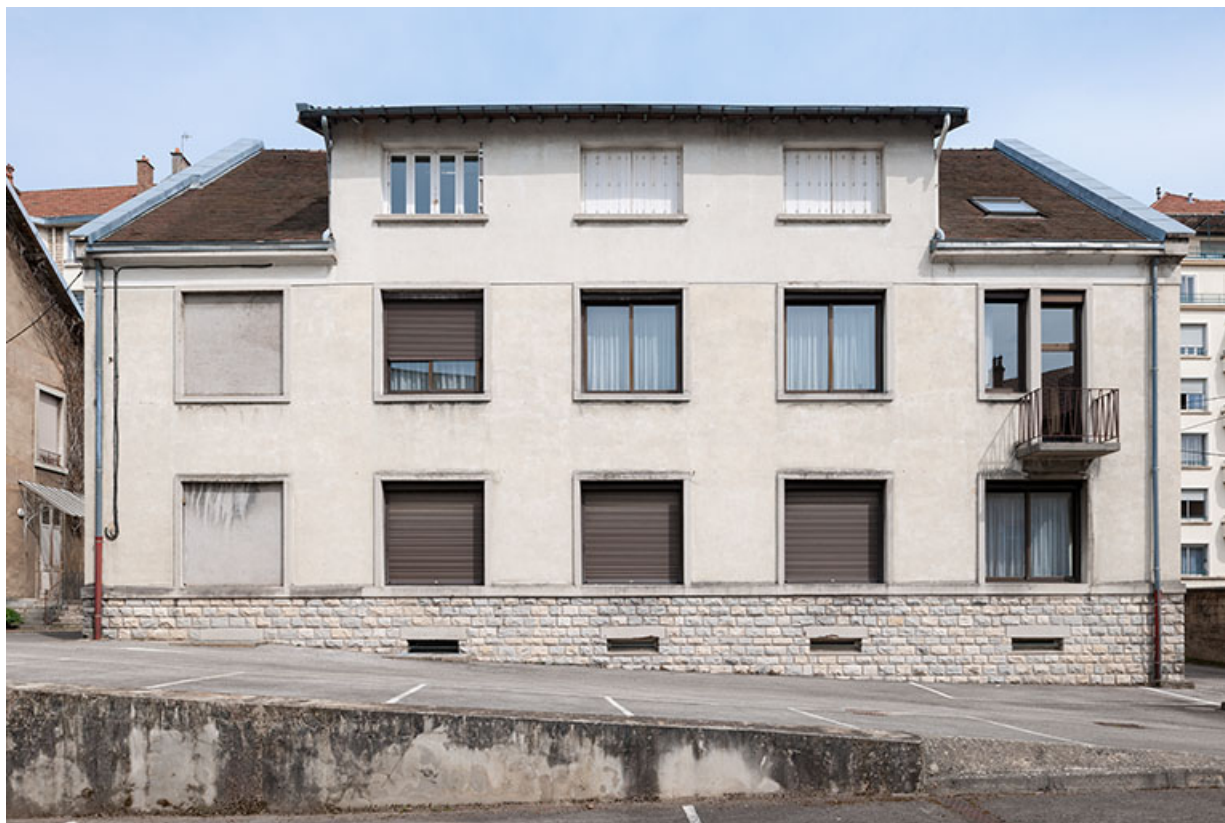
Siège de la Caisse régionale de Crédit agricole : façade postérieure.
