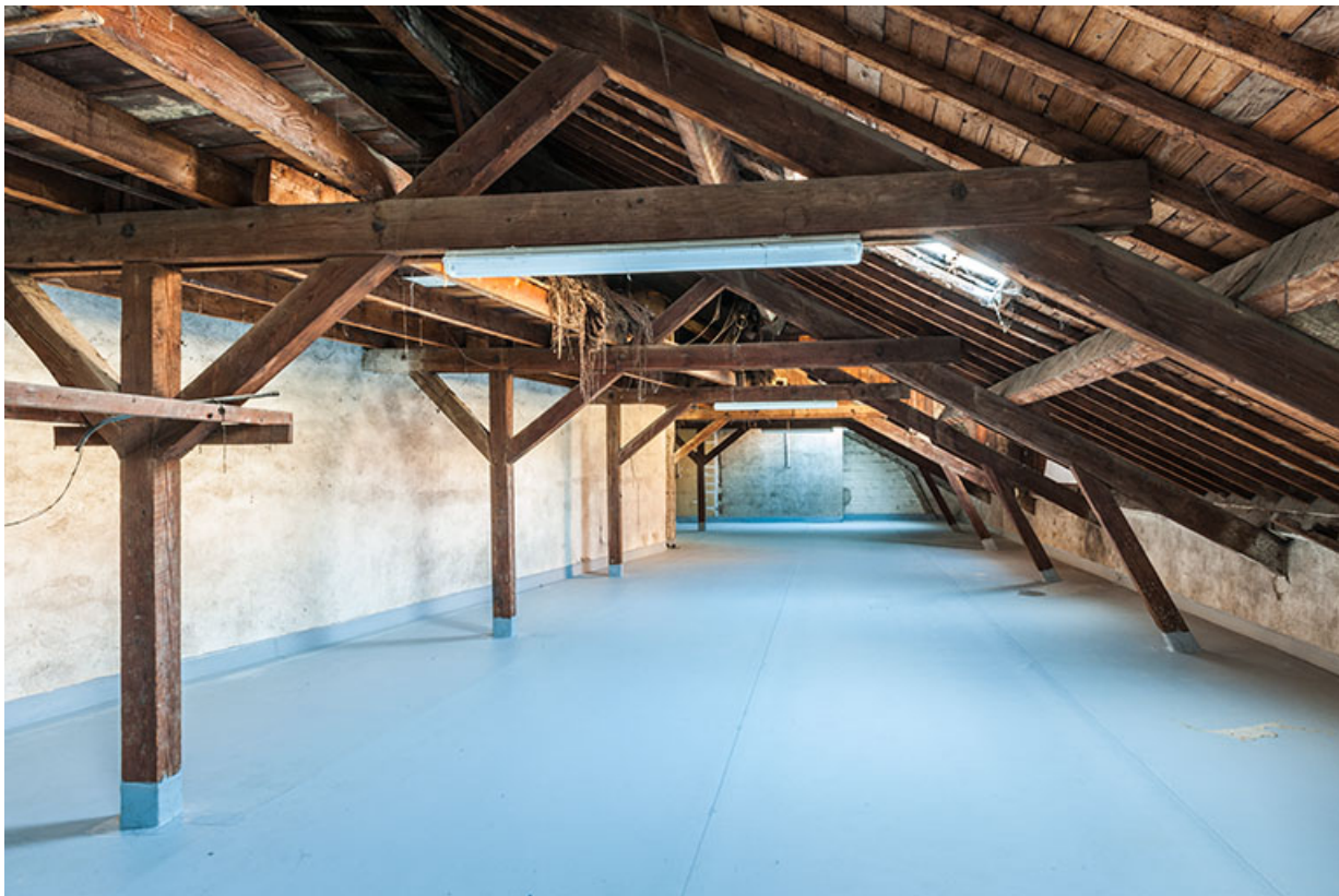
L'entrepôt en cours de surélévation en 2003 : couche d'étanchéité appliquée sur le sol de l'étage en surcroît. 25, Besançon, 1 ter et 3 rue Victor Delavelle
