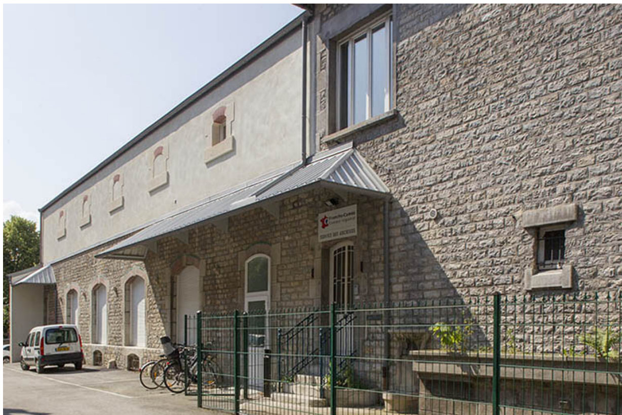
Entrepôt : façade antérieure de trois quarts droite (depuis l'entrée de la cour). 25, Besançon, 1 ter et 3 rue Victor Delavelle
