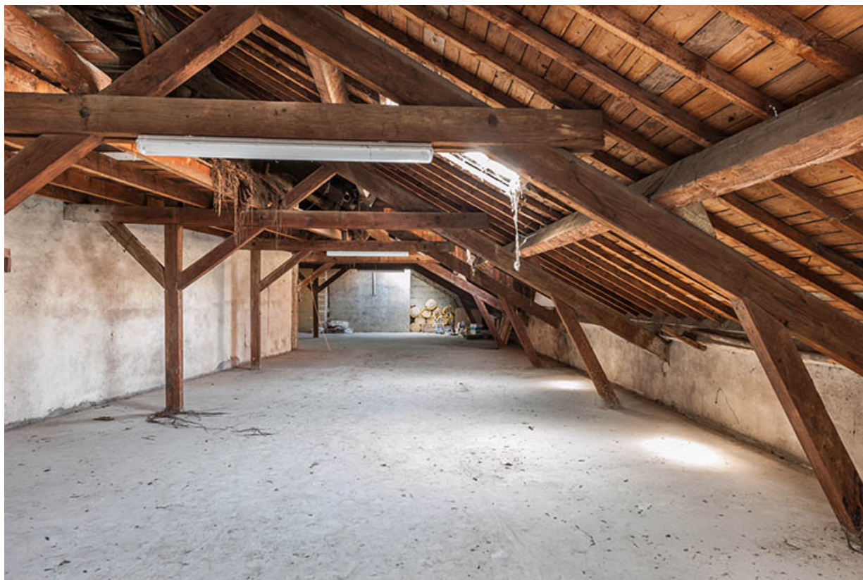
L'entrepôt avant sa surélévation en 2003 : la charpente depuis le fond de l'étage en surcroît.
