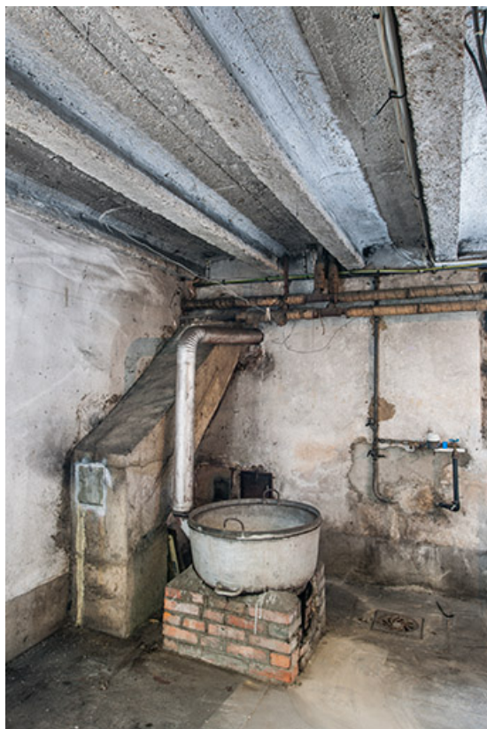
Bâtiment de l'administration, sous-sol : buanderie et son chaudron à lessive.
