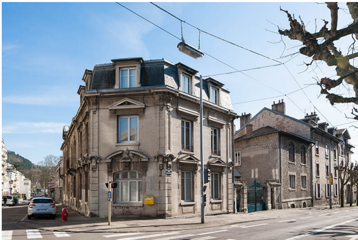
Bâtiment de l'administration : façade sur l'avenue Denfert-Rochereau, depuis le nord. 25, Besançon, 1 ter et 3 rue Victor Delavelle
