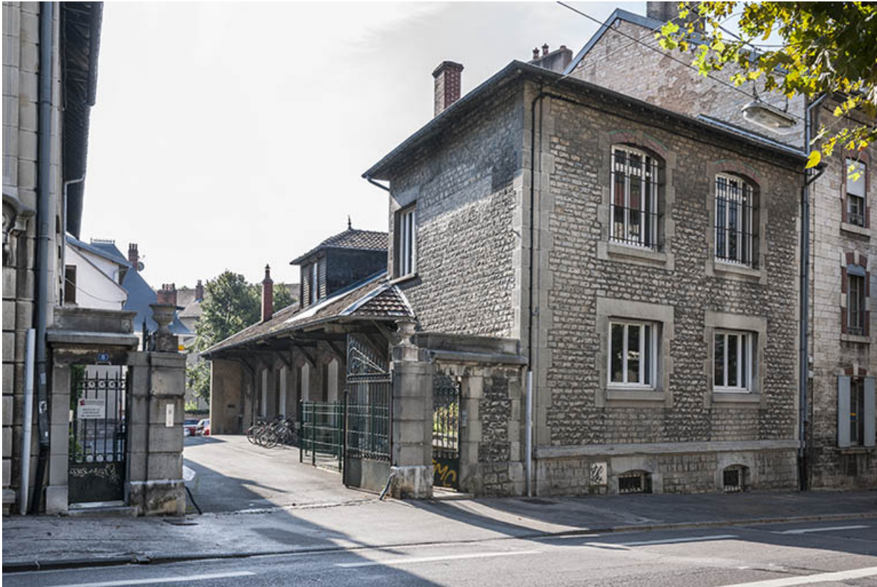
L'entrepôt avant sa surélévation en 2003 : vue d'ensemble depuis l'avenue Denfert-Rochereau. 25, Besançon, 1 ter et 3 rue Victor Delavelle
