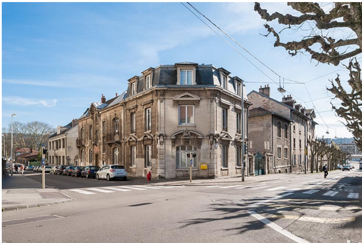
Vue d'ensemble du site, depuis le nord.
