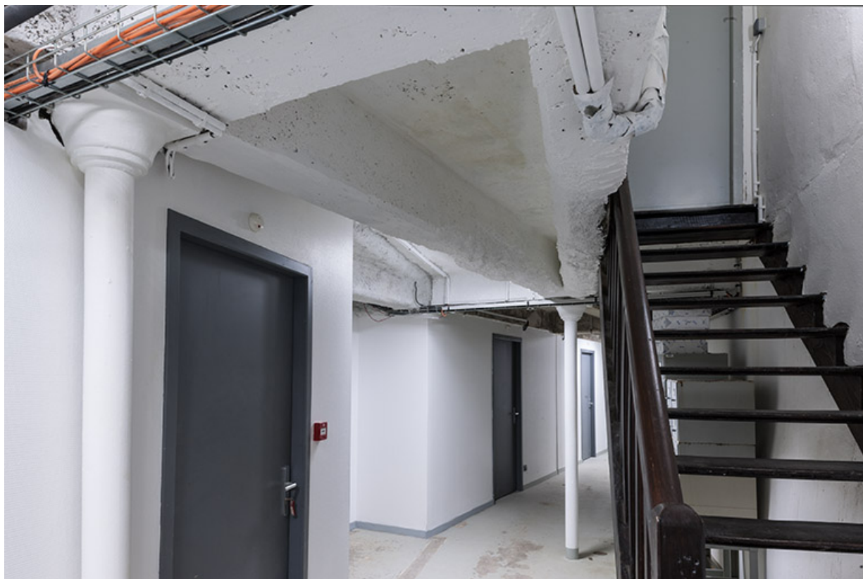
Entrepôt, soubassement : charpente en béton, poteaux en fonte et aménagements récents.
