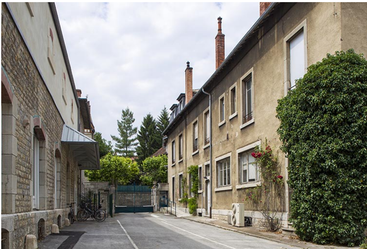
Cour entre le bâtiment de l'administration et l'entrepôt.
