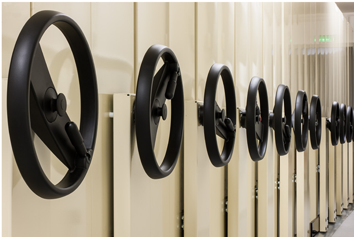
Entrepôt, 1er étage (partie surélevée) : volants des rayonnages mobiles.
