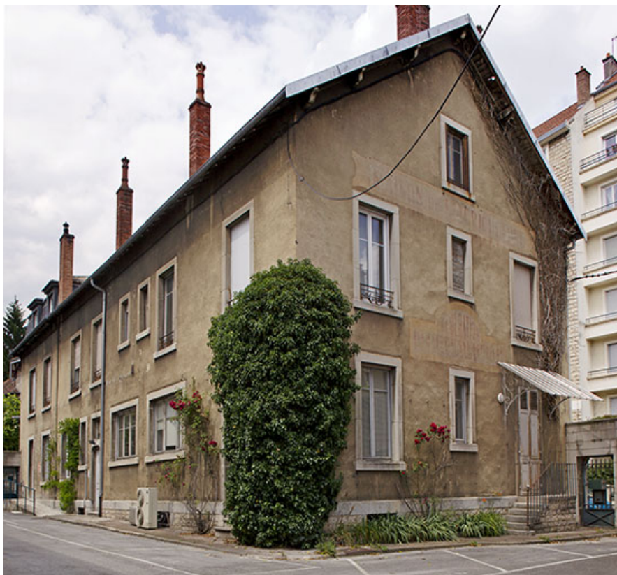
Bâtiment de l'administration : façades postérieure et latérale gauche.
