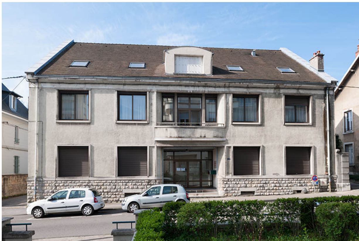
Siège de la Caisse régionale de Crédit agricole : façade antérieure (côté rue Delavelle). 25, Besançon, 1 ter et 3 rue Victor Delavelle
