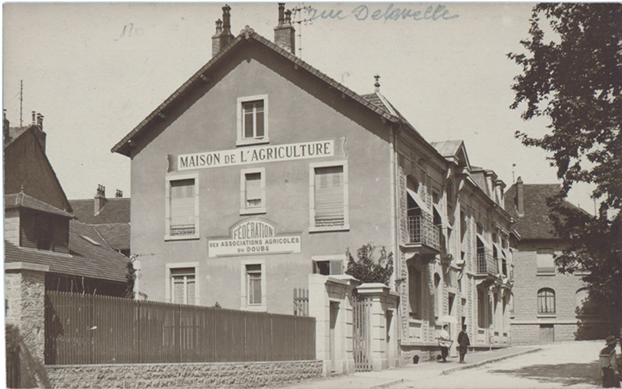
[La Maison de l'Agriculture, rue Delavelle à Besançon], 2e quart 20e siècle. 25, Besançon, 1 ter et 3 rue Victor Delavelle
