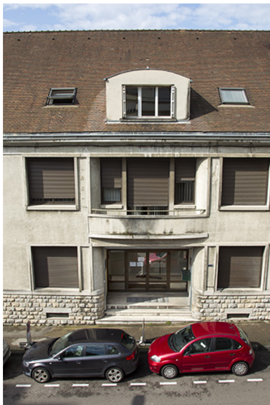
Siège de la Caisse régionale de Crédit agricole : vue plongeante sur l'entrée principale (côté rue Delavelle). 25, Besançon, 1 ter et 3 rue Victor Delavelle
