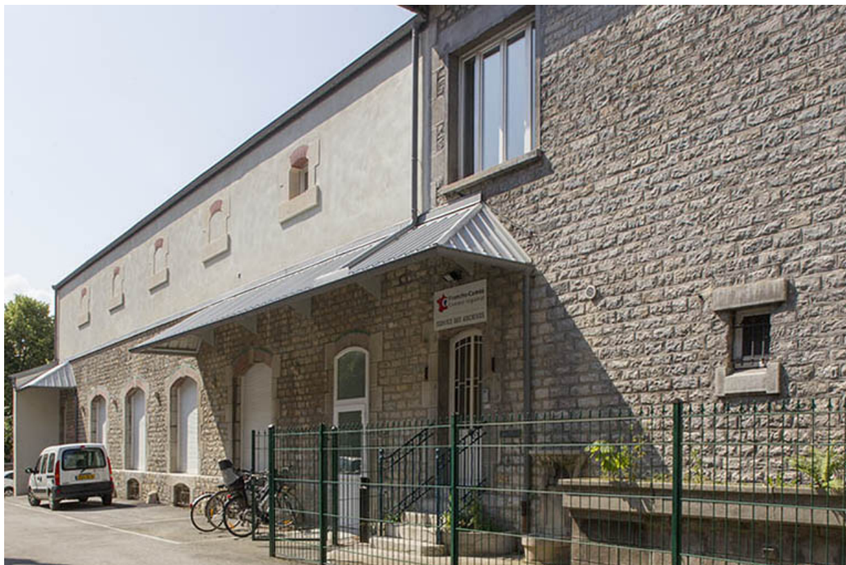
Entrepôt : façade antérieure de trois quarts droite (depuis l'entrée de la cour). 25, Besançon, 1 ter et 3 rue Victor Delavelle
