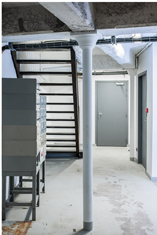
Entrepôt, soubassement : poteau en fonte et charpente en béton.
