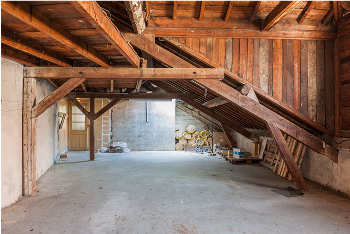
L'entrepôt avant sa surélévation en 2003 : la charpente près de l'entrée.
