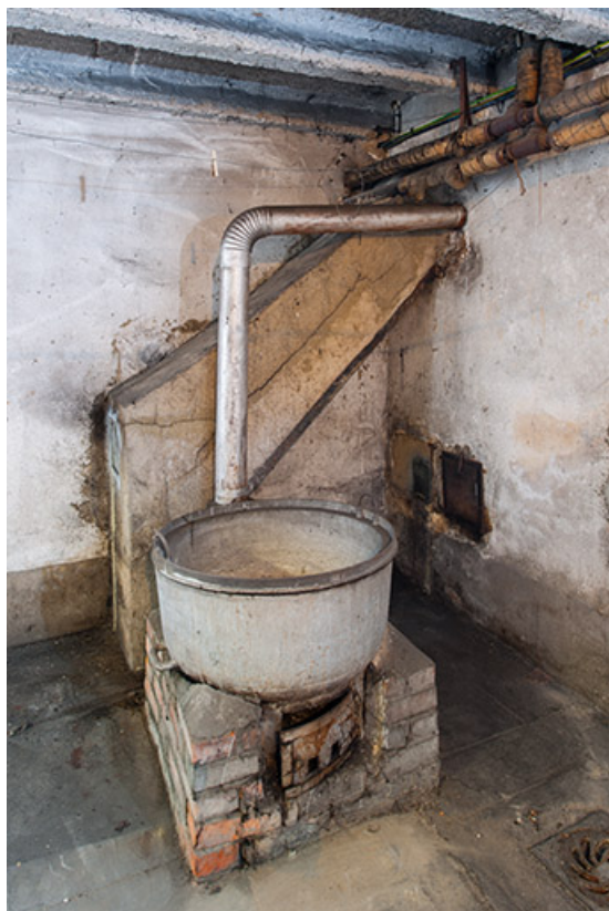
Bâtiment de l'administration, sous-sol : chaudron à lessive.
