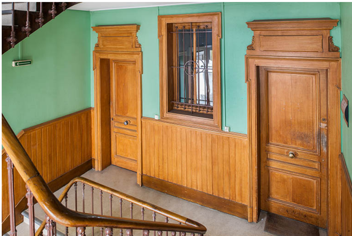
Bâtiment de l'administration, cage d'escalier : palier du 1er étage. 25, Besançon, 1 ter et 3 rue Victor Delavelle
