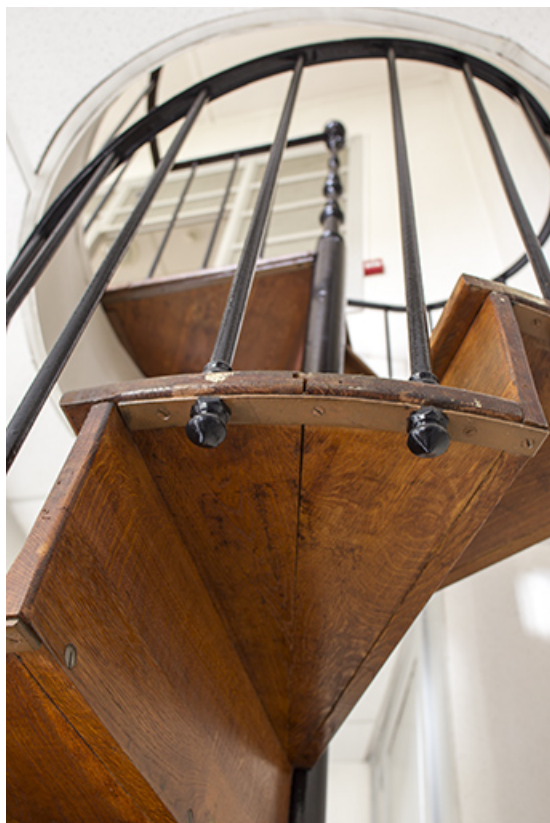
Entrepôt, rez-de-chaussée : escalier en vis, vu en contre-plongée.
