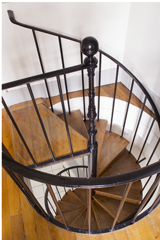
Entrepôt, rez-de-chaussée : escalier en vis, vu en plongée.
