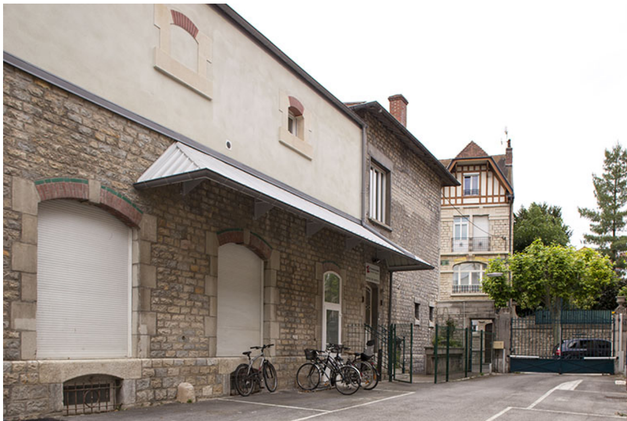
Entrepôt : façade antérieure de trois quarts gauche.
