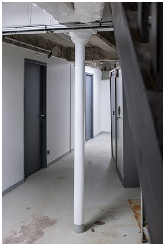
Entrepôt, soubassement : charpente en béton et poteau en fonte.
