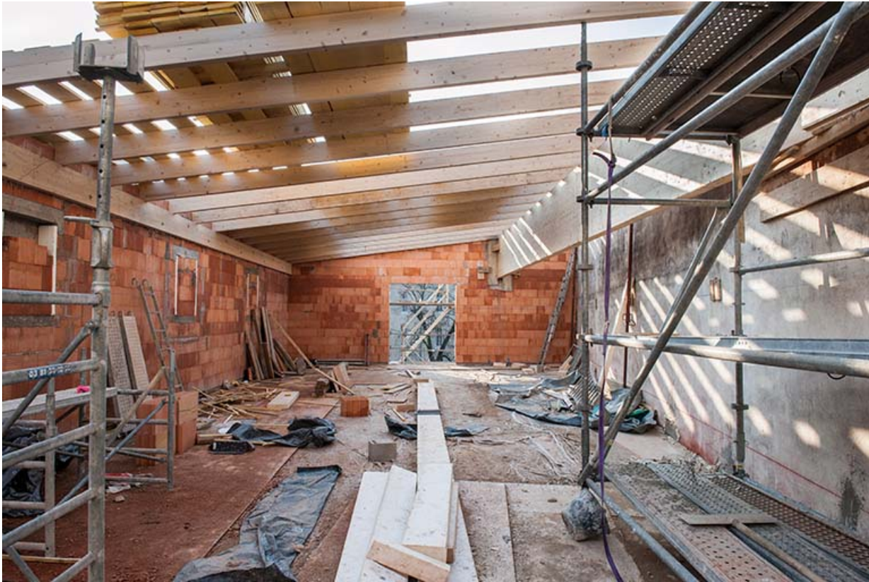
L'entrepôt en cours de surélévation en 2003 : intérieur de l'étage en surcroît depuis l'entrée.
