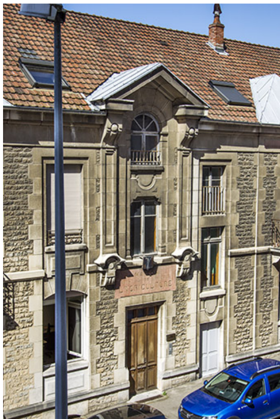
Bâtiment de l'administration : travée principale de la façade antérieure. 25, Besançon, 1 ter et 3 rue Victor Delavelle
