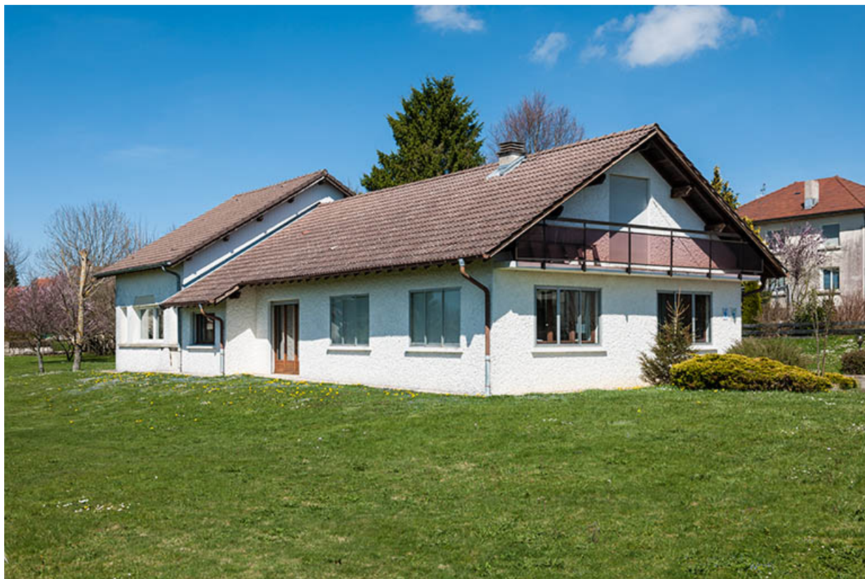
Une petite usine des années 1980 (1982-1990) : usine de montres Jean-Louis Frésard (13 rue Jean Moulin). 25, Charquemont, 13 rue Jean Moulin
