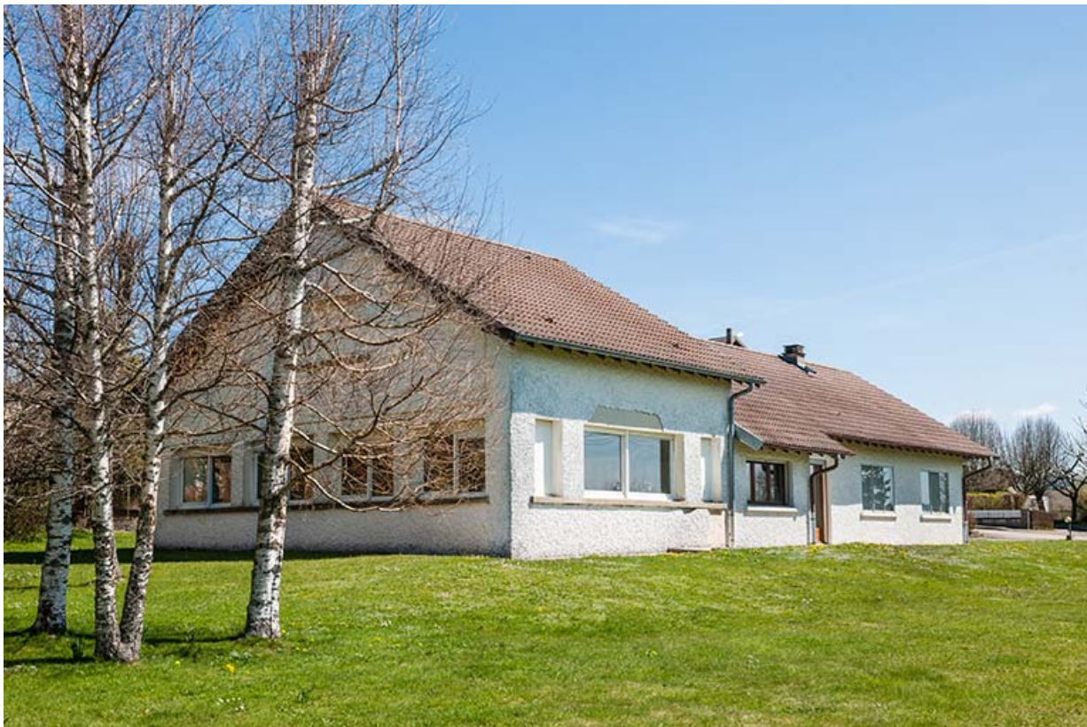
Vue d'ensemble, depuis l'ouest (façades postérieure et latérale gauche). 25, Charquemont, 13 rue Jean Moulin
