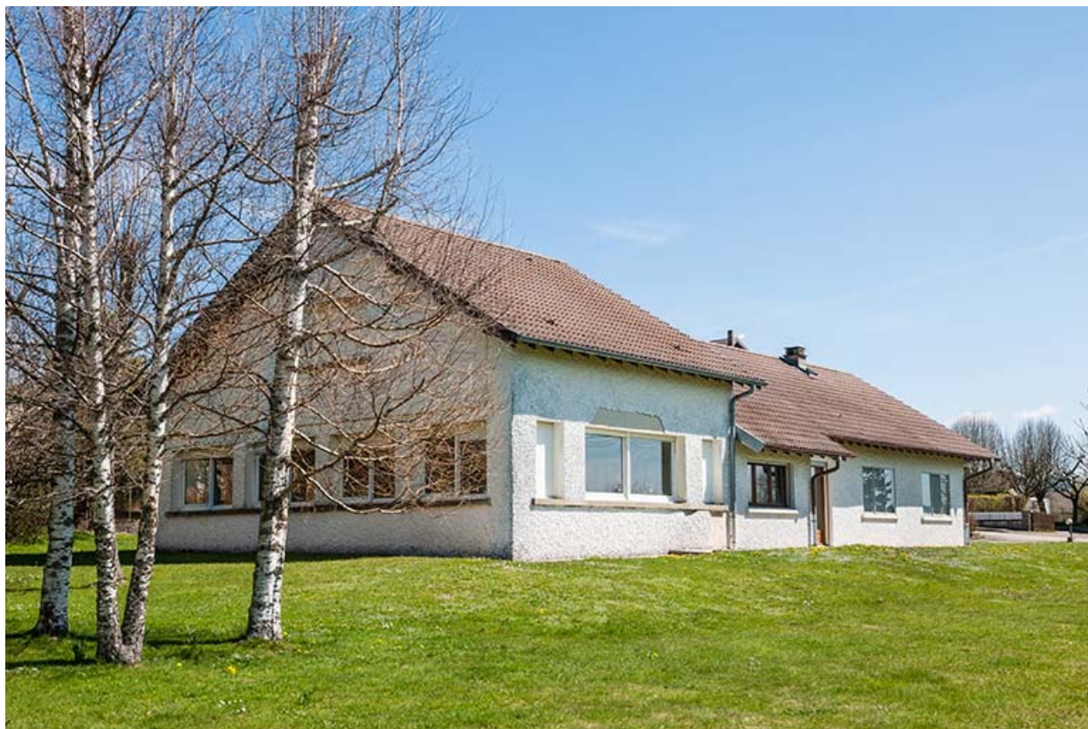
Vue d'ensemble, depuis l'ouest (façades postérieure et latérale gauche). 25, Charquemont, 13 rue Jean Moulin
