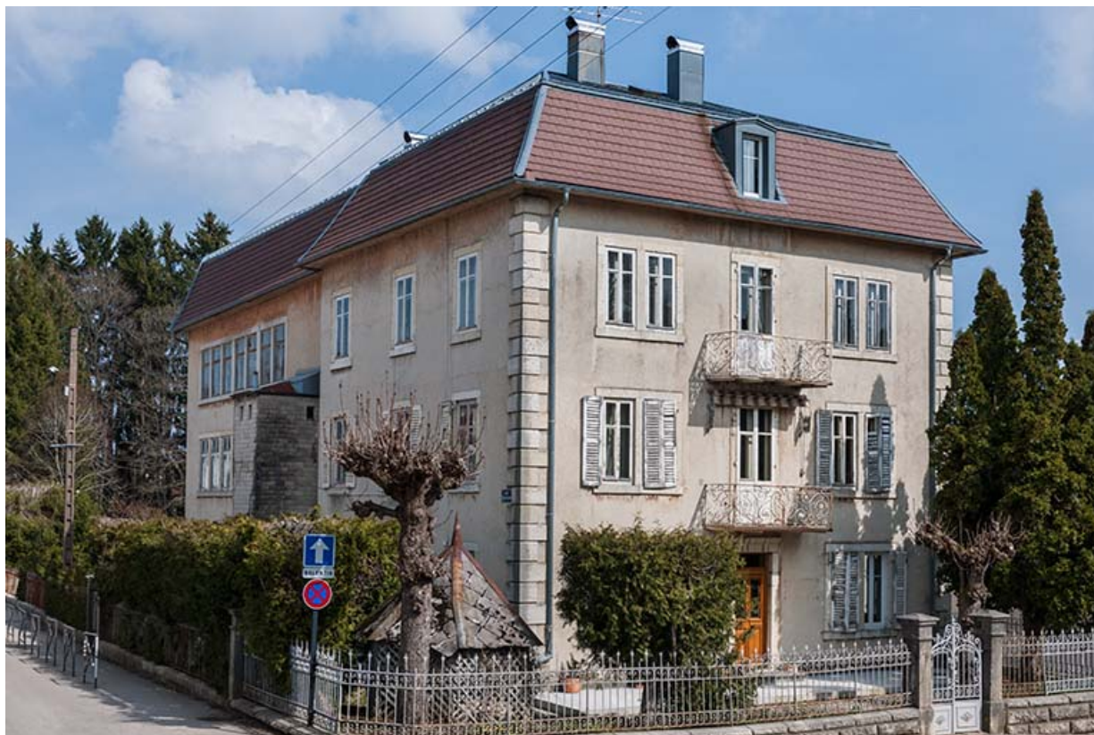
Vue d'ensemble, depuis l'ouest. De gauche à droite : usine et logement patronal, de trois quarts gauche. 25, Charquemont, 13 et 15 Grande Rue
