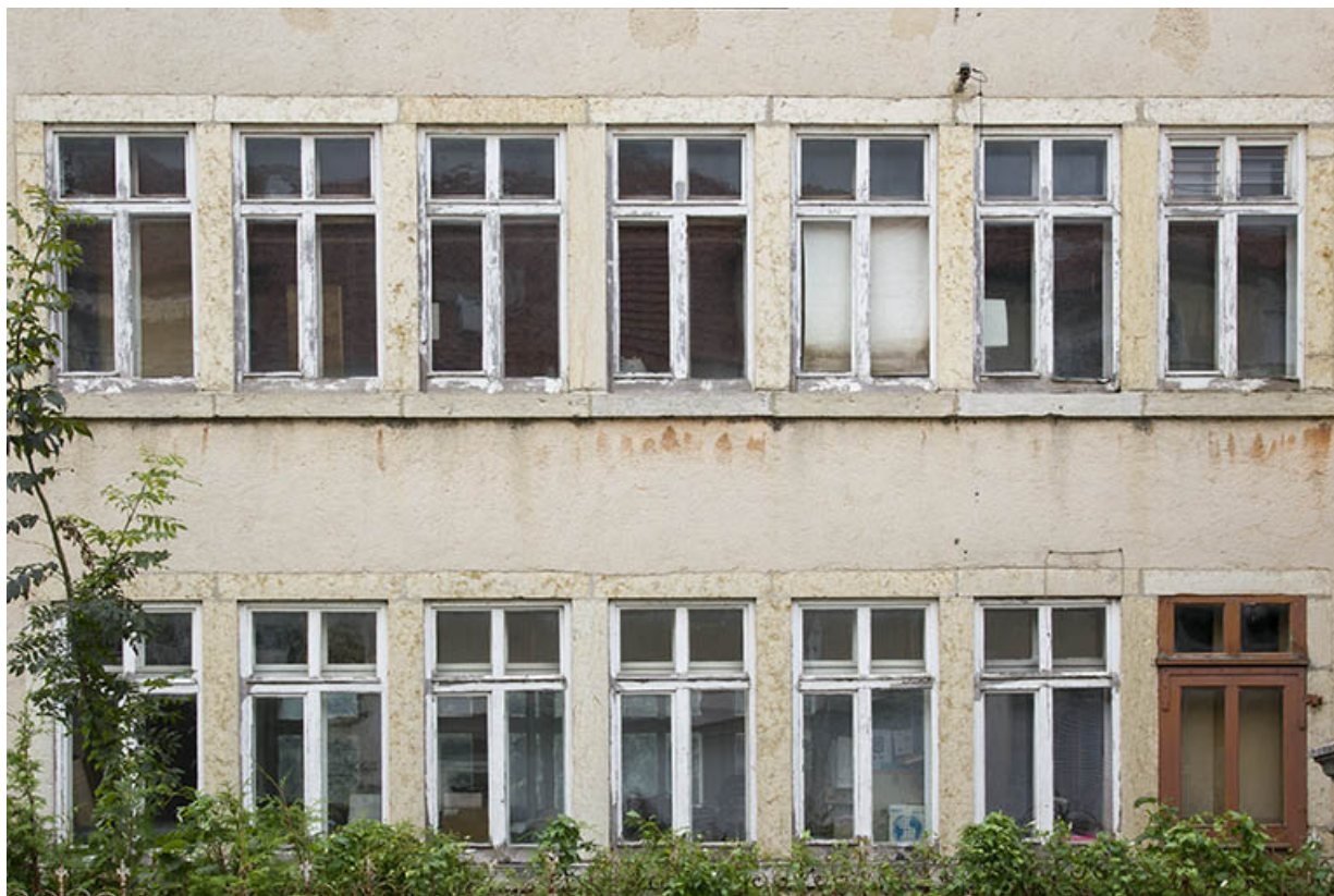
Usine, façade postérieure : fenêtres multiples du rez-de-chaussée surélevé et du 1er étage.
