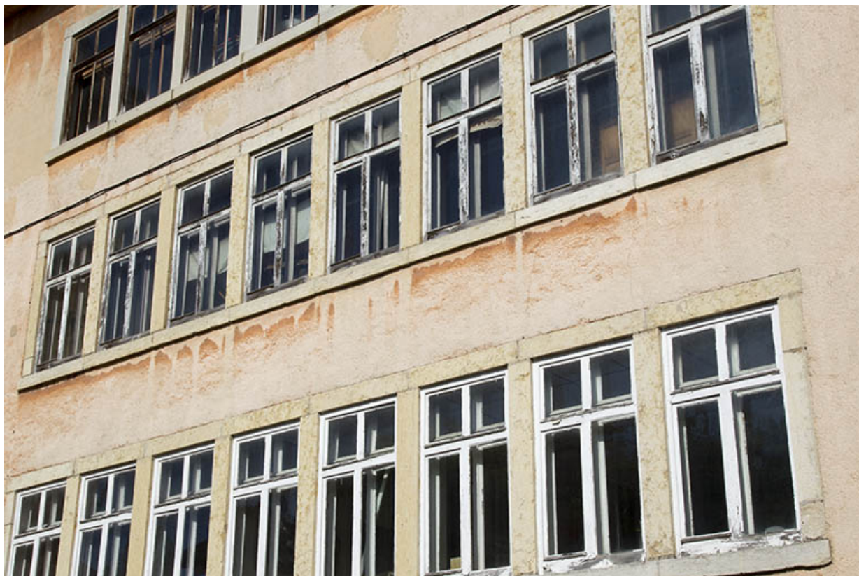
Usine, façade antérieure : fenêtres multiples.
