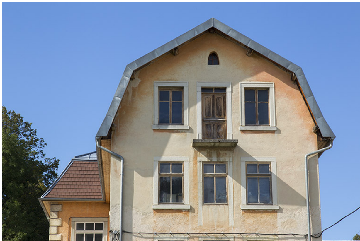
Usine, façade latérale droite : baies du 2e étage carré et de l'étage en surcroît. 25, Charquemont, 13 et 15 Grande Rue
