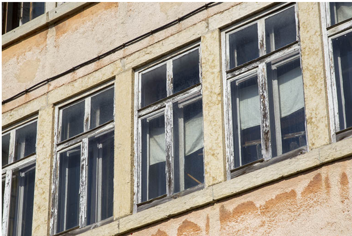
Usine, façade antérieure : détail des fenêtres multiples.
