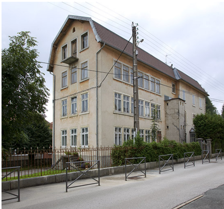
Usine : façades postérieure et latérale droite.
