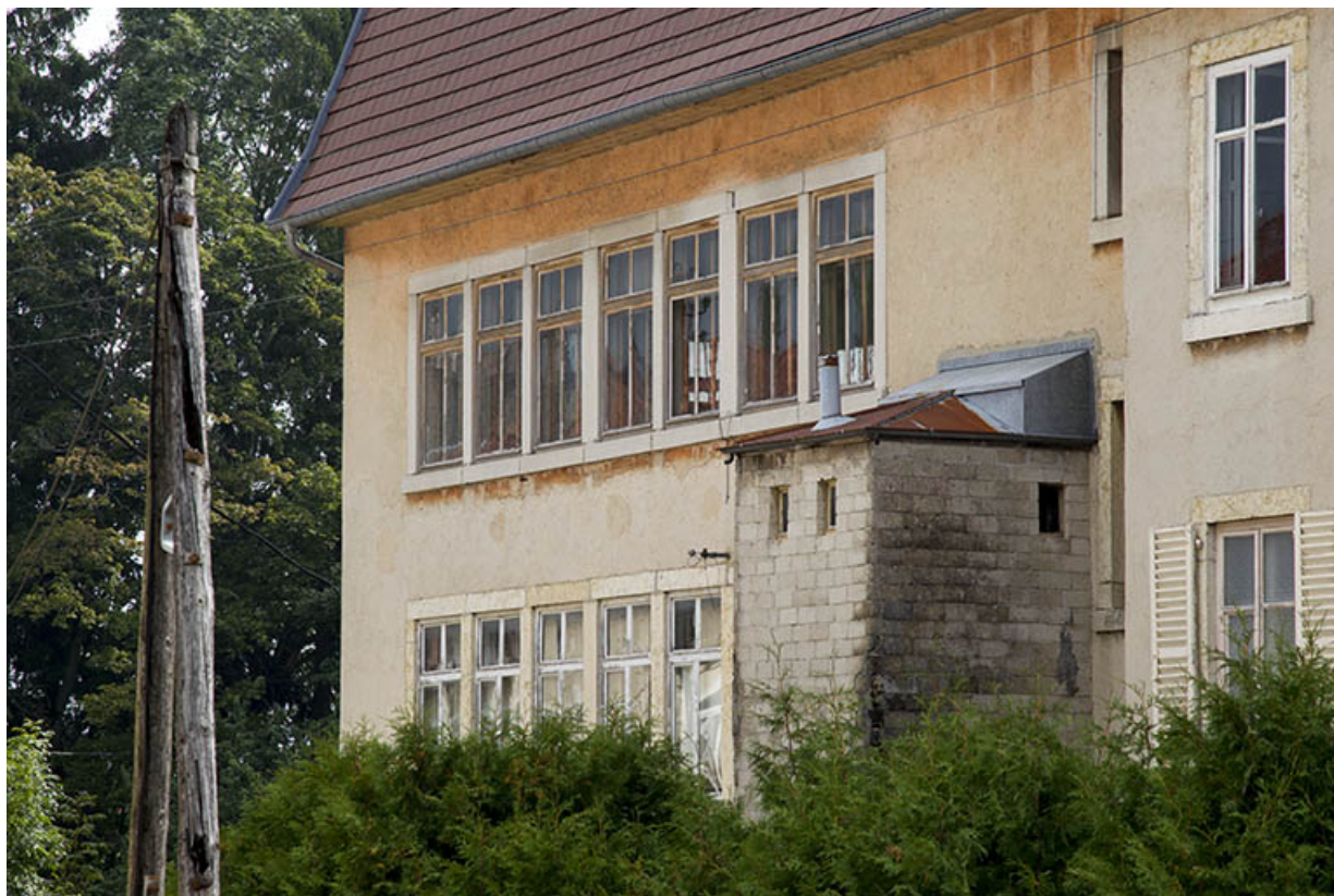
Usine, façade postérieure : fenêtres multiples des 1er et 2e étages, vues de trois quarts droite. 25, Charquemont, 13 et 15 Grande Rue
