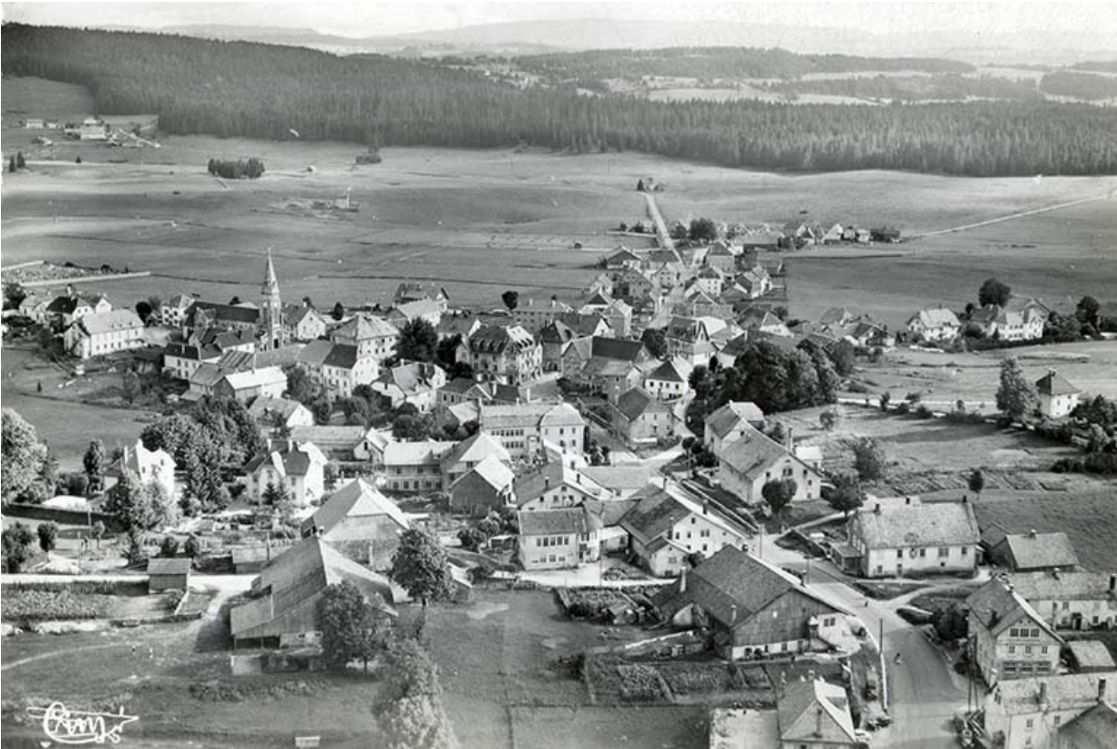
Charquemont (Doubs). 11059 - Vue aérienne [depuis l'ouest], entre 1950 et 1955. La levée de grange est encore visible. 25, Charquemont, 16 Grande Rue
