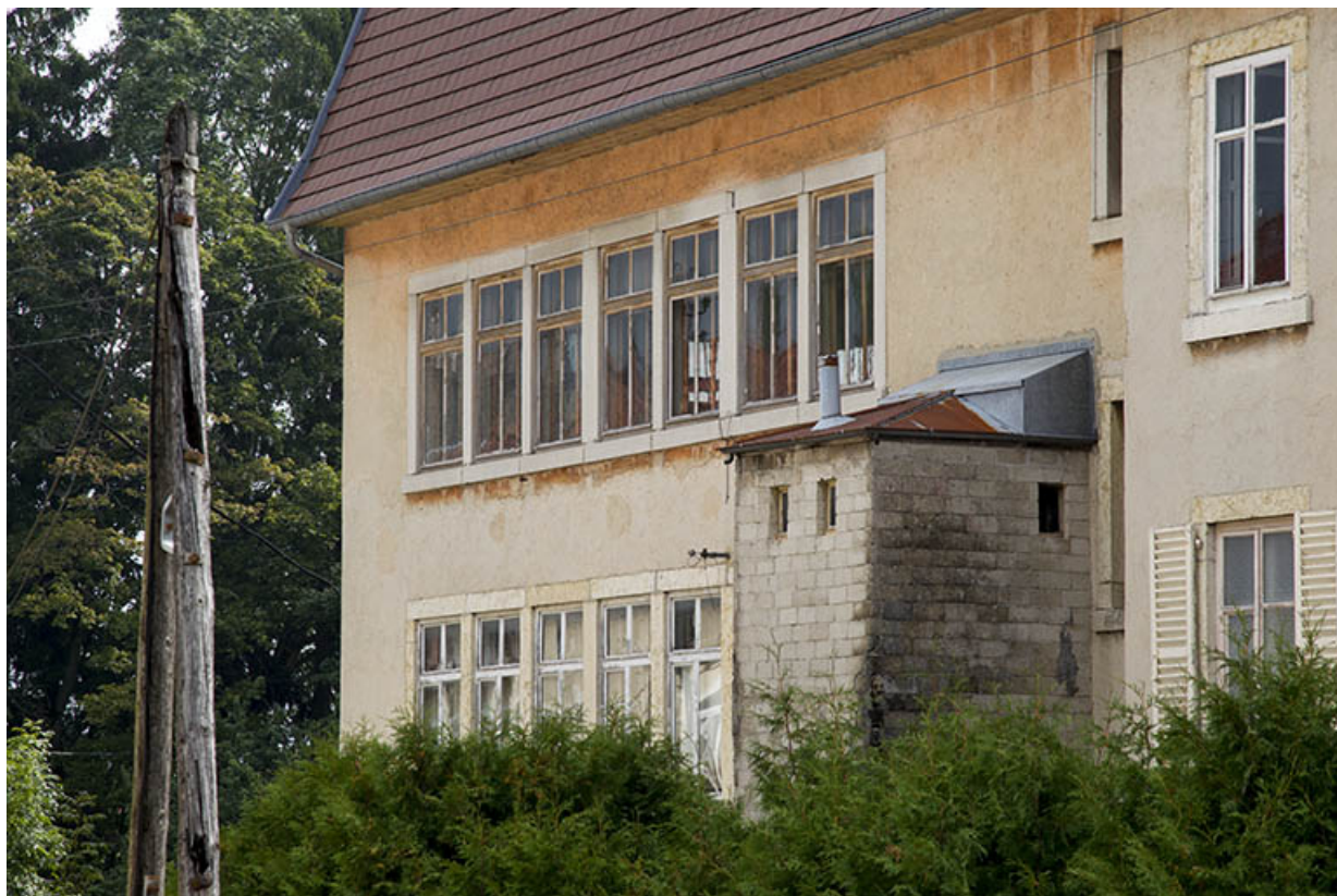
Usine, façade postérieure : fenêtres multiples des 1er et 2e étages, vues de trois quarts droite. 25, Charquemont, 13 et 15 Grande Rue
