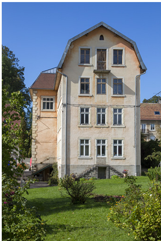
Usine : façade latérale droite.
