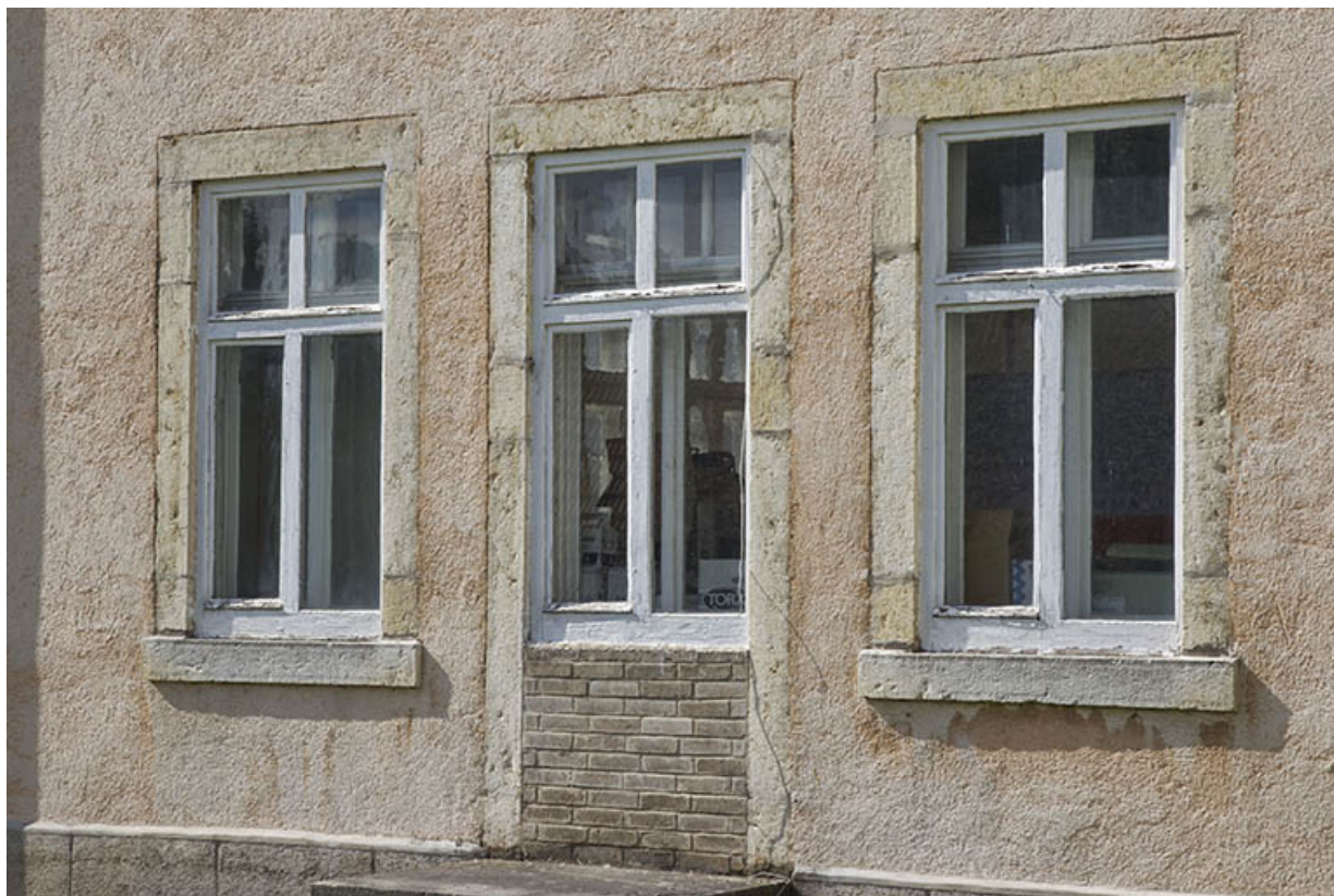
Usine, façade latérale droite : baies du rez-de-chaussée surélevé.
