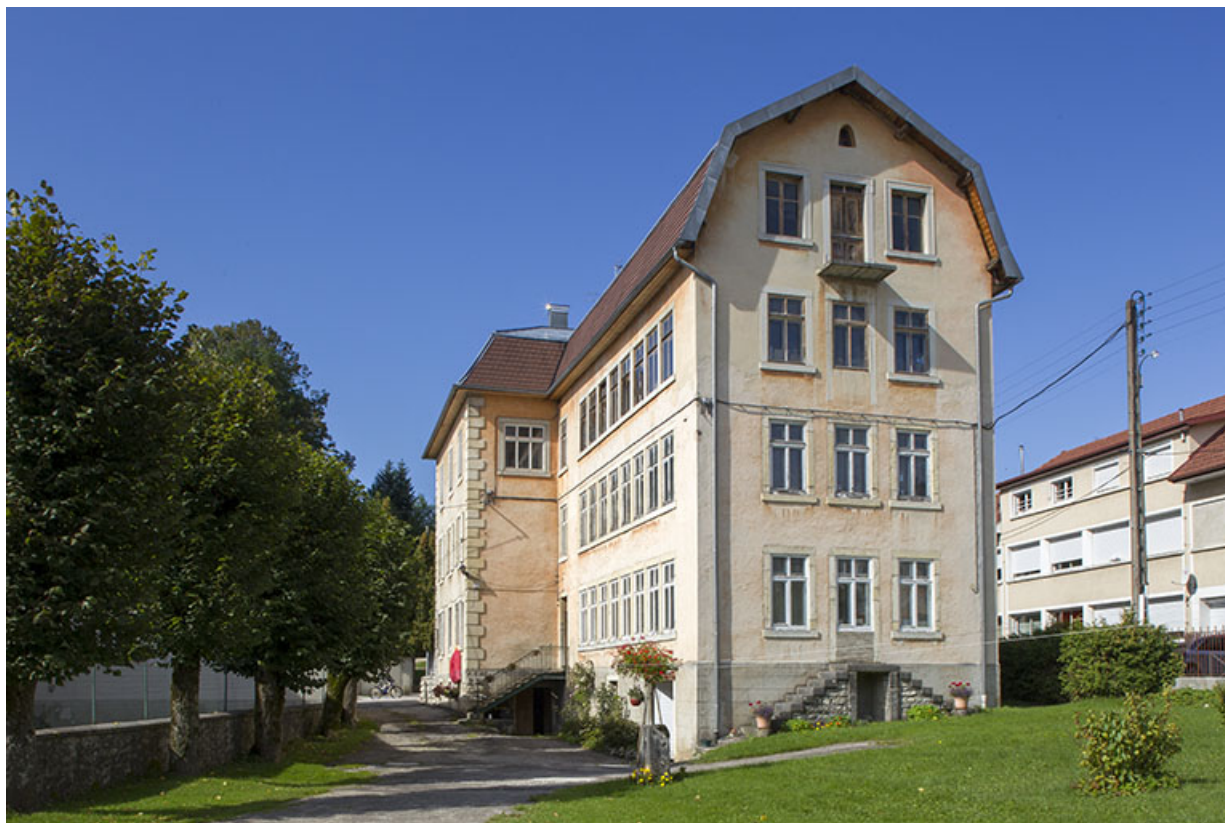
Une usine du début du 20e siècle (1904, architecte Calame) : usine d'ébauches de montres et de montres Guillaume (13-15 Grande Rue).
