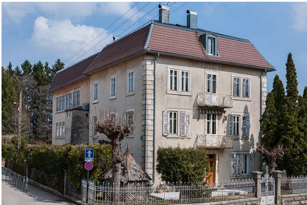
Vue d'ensemble, depuis l'ouest. De gauche à droite : usine et logement patronal, de trois quarts gauche. 25, Charquemont, 13 et 15 Grande Rue
