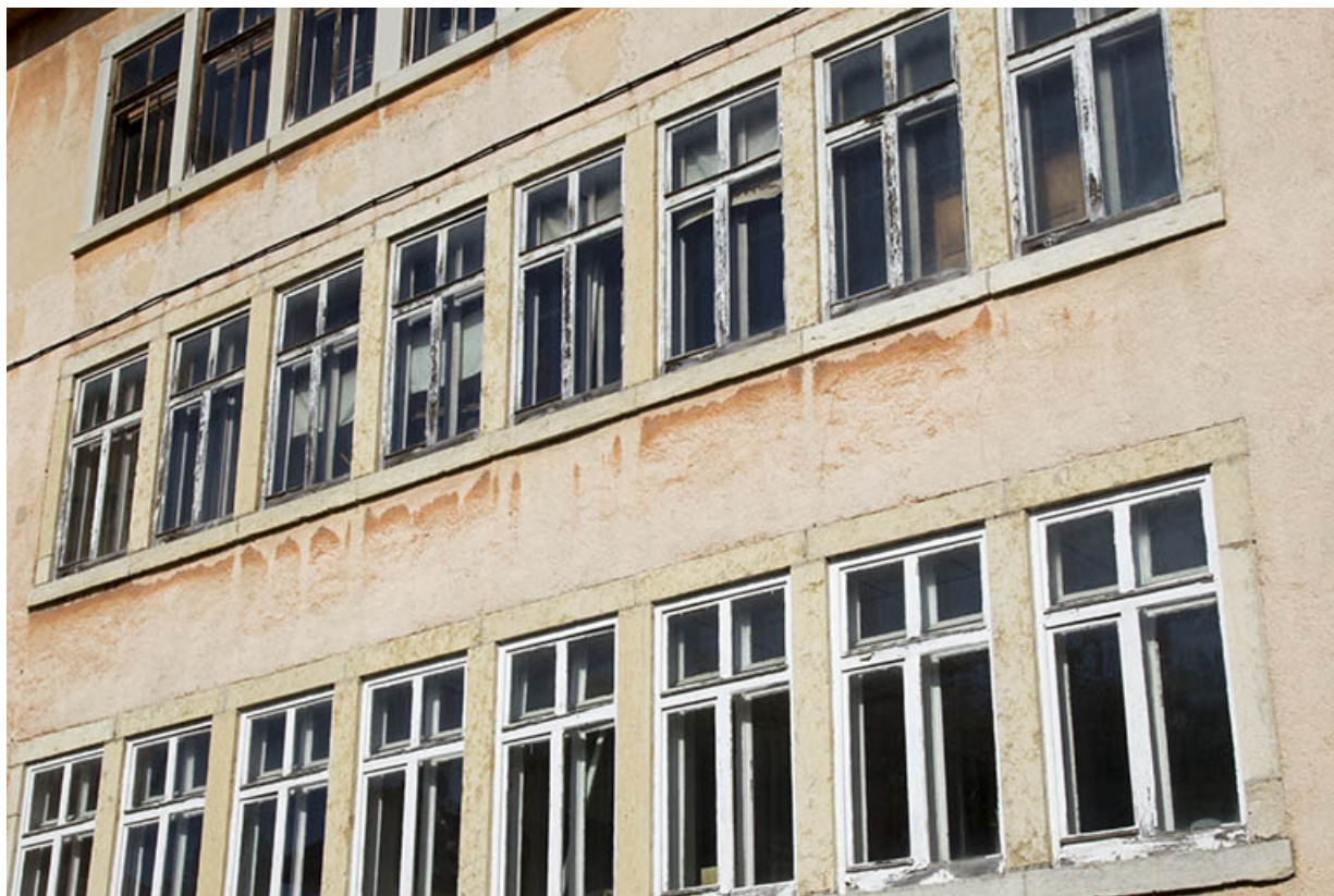
Usine, façade antérieure : fenêtres multiples.
