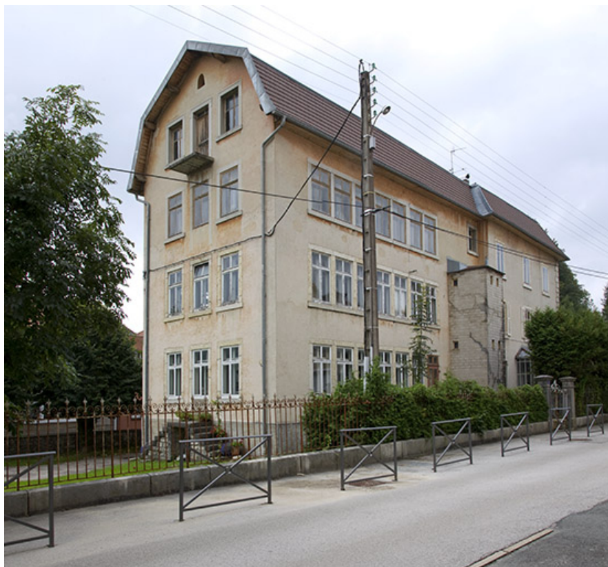
Usine : façades postérieure et latérale droite. 25, Charquemont, 13 et 15 Grande Rue
