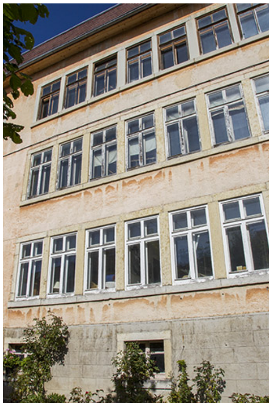
Usine : façade antérieure, vue en contre-plongée. 25, Charquemont, 13 et 15 Grande Rue
