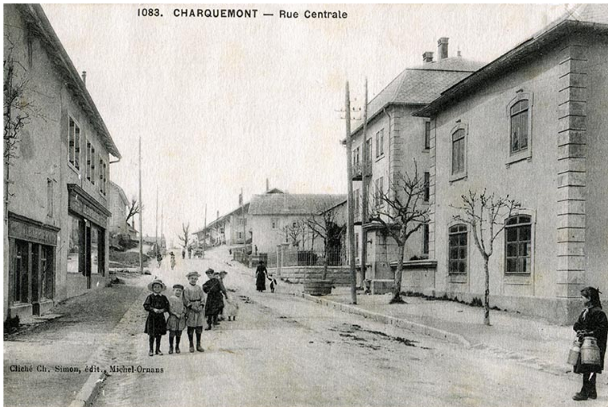
1083. Charquemont - Rue centrale [façade antérieure de l'habitation depuis le sud], 1er quart 20e siècle 25, Charquemont, 13 et 15 Grande Rue
