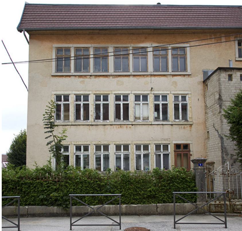
Usine : façade postérieure.
