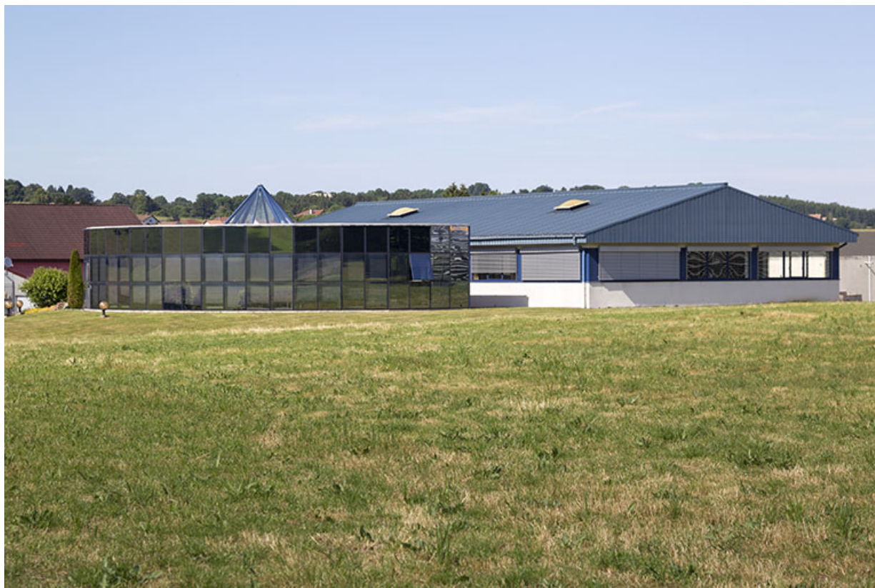
Bureau et atelier de fabrication, depuis le sud. 25, Charquemont le Grand Crôt
