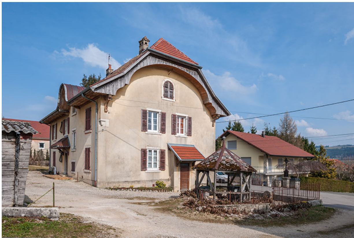
Logement patronal : façades postérieure et latérale gauche.
