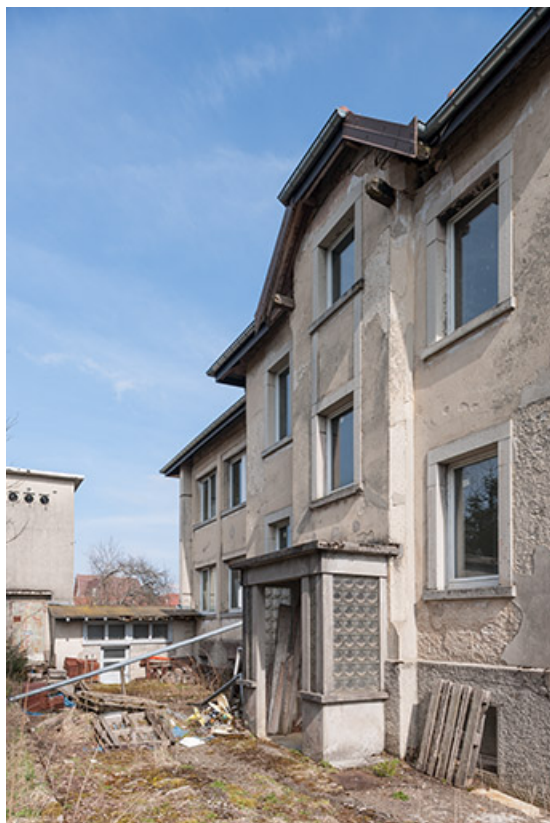
Usine : façade postérieure, de trois quarts droite.
