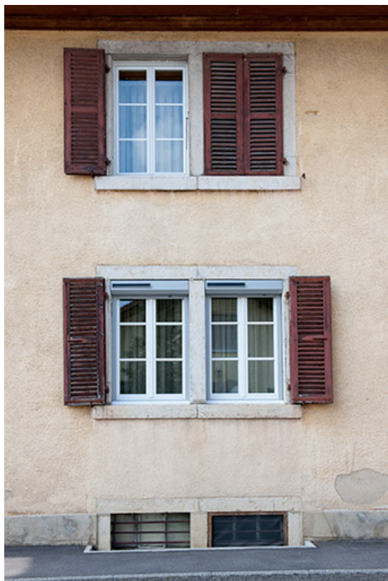
Logement patronal : fenêtres horlogères côté rue. 25, Charquemont, 10-14 rue du Château
