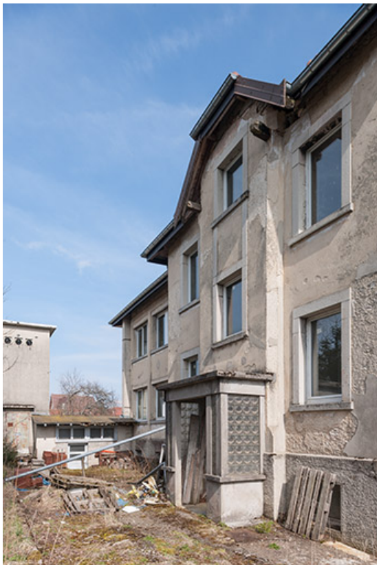
Usine : façade postérieure, de trois quarts droite.
