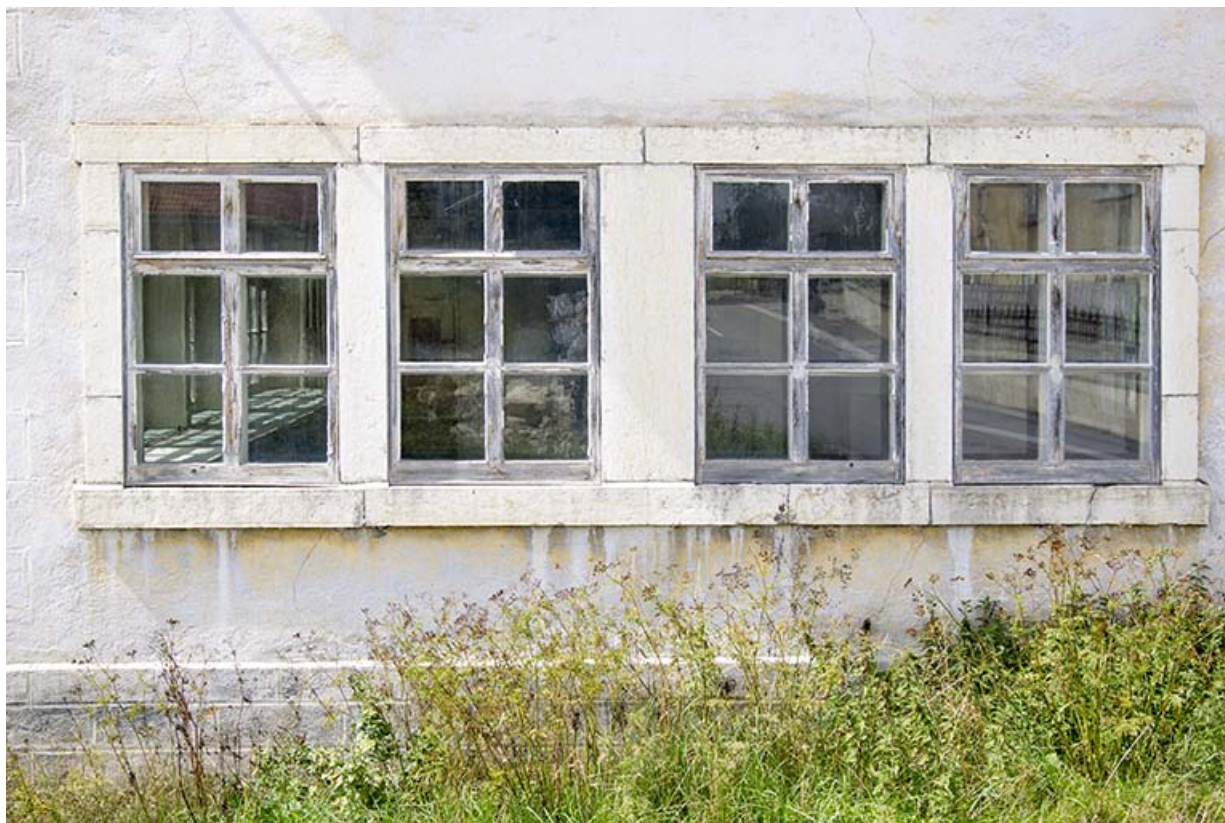
Usine, façade latérale gauche : fenêtres multiples du rez-de-chaussée. 25, Charquemont
