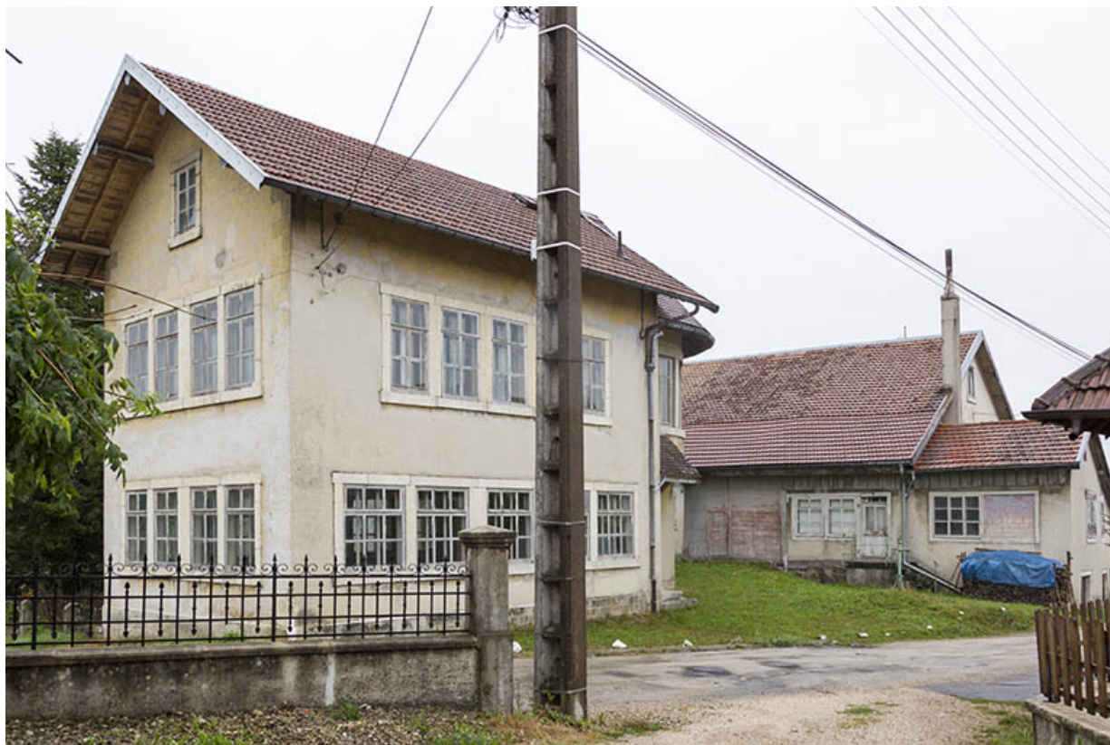
Vue d'ensemble, depuis le nord : façade latérale droite de la ferme et usine. 25, Charquemont, 9 Grande Rue
