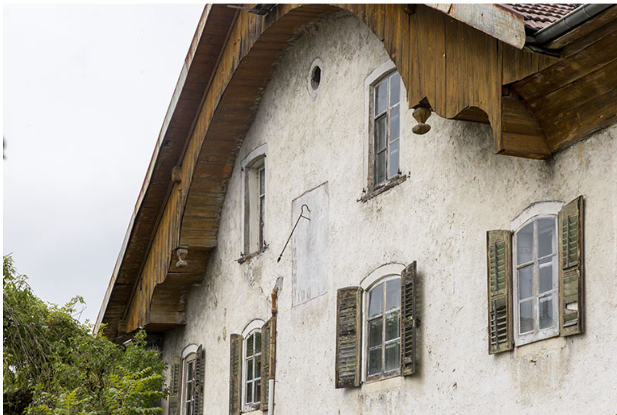
Façade antérieure : pignon et cadran solaire. 25, Charquemont, 9 Grande Rue
