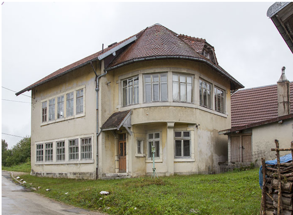
Usine : façades antérieure et latérale droite.
