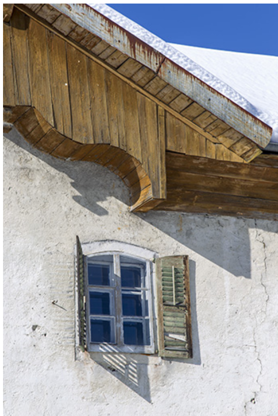
Façade antérieure : extrémité droite de la lambrichure et fenêtre.
