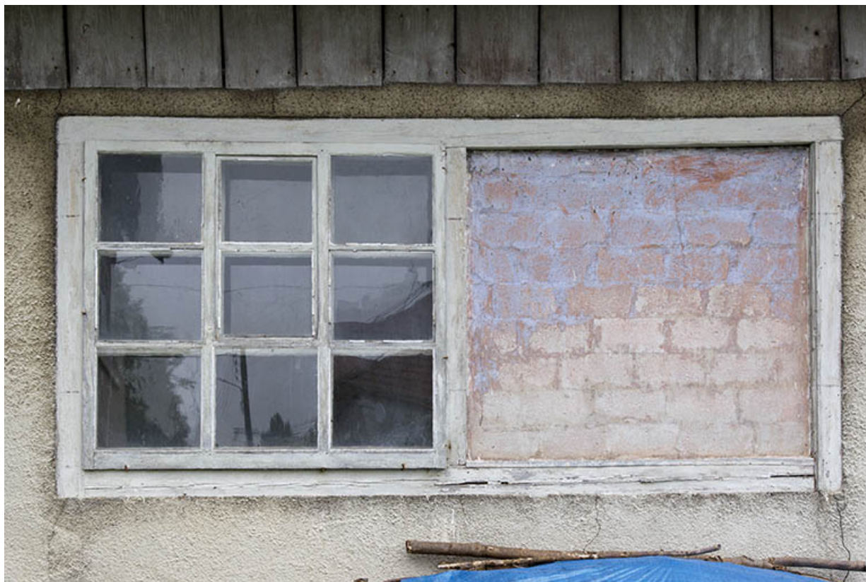
Façade latérale droite : fenêtres.
