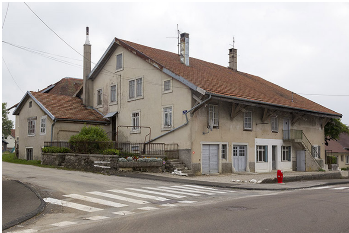
Vue d'ensemble, depuis le nord-ouest : façades postérieure et latérale gauche de la ferme. 25, Charquemont, 9 Grande Rue
