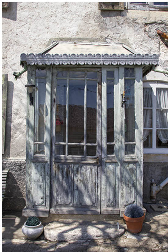
Façade antérieure : véranda.
