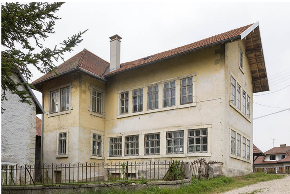
Usine : façades postérieure et latérale gauche.
