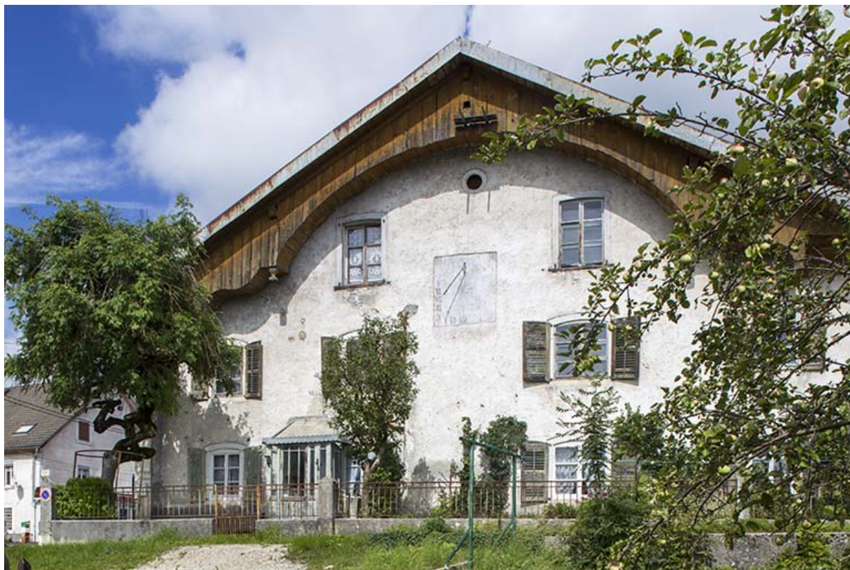
Façade antérieure. 25, Charquemont
