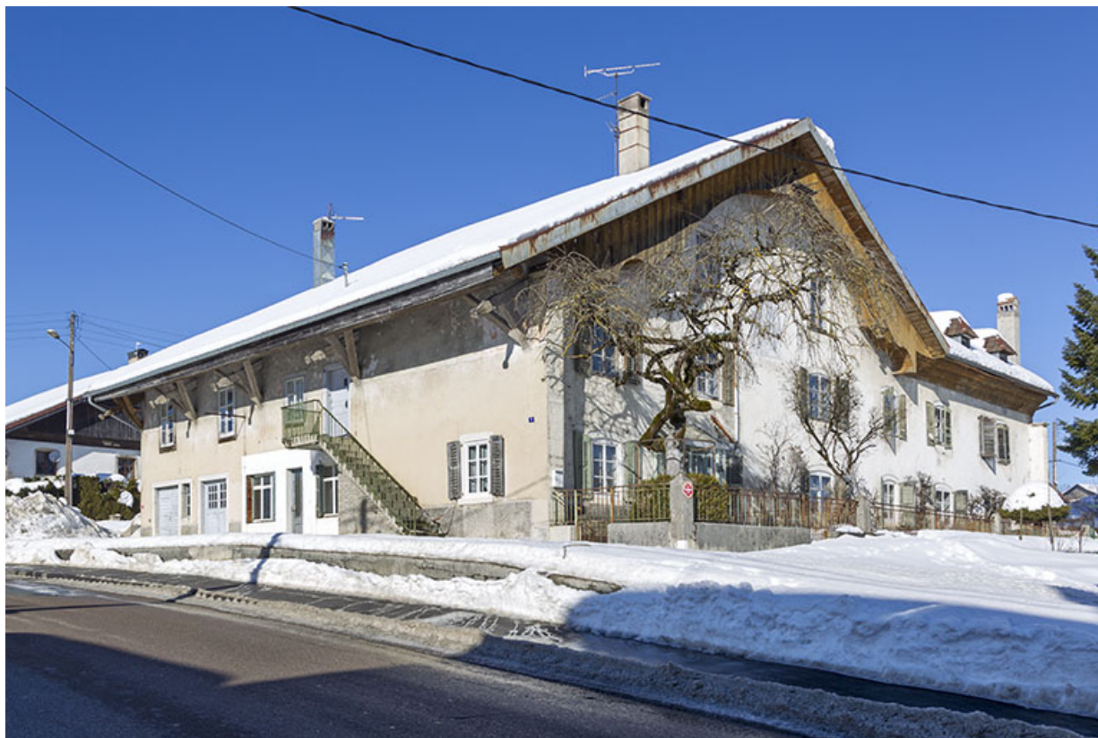
Vue d'ensemble, depuis le sud : façades antérieure et latérale gauche de la ferme, en hiver. 25, Charquemont, 9 Grande Rue
