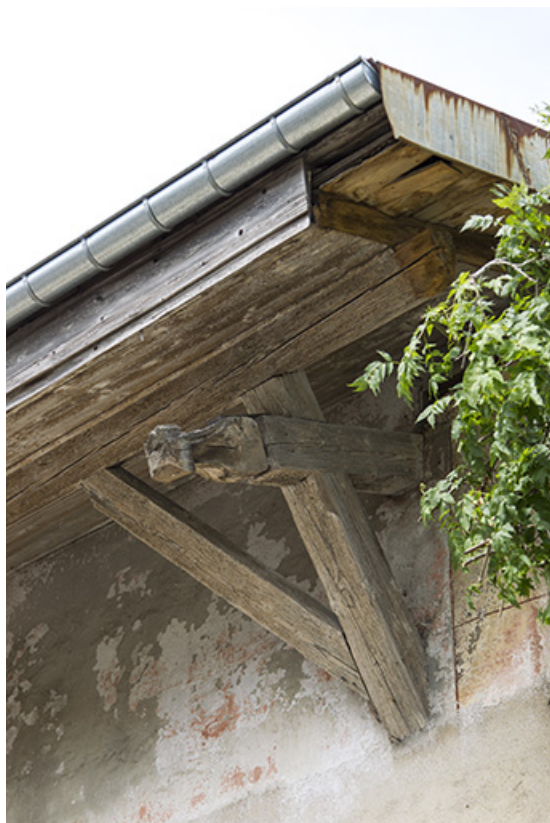
Façade latérale gauche : motif décoratif ornant l'extrémité d'un chevron.
