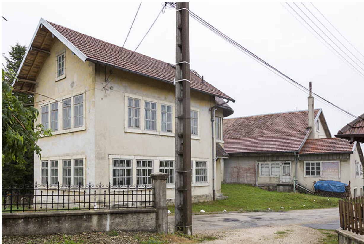
Vue d'ensemble, depuis le nord : façade latérale droite de la ferme et usine. 25, Charquemont, 9 Grande Rue
