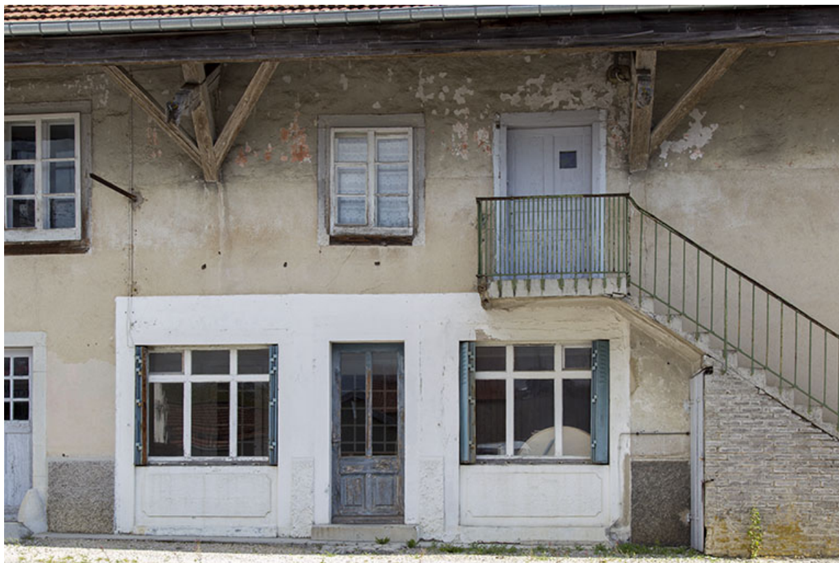
Façade latérale gauche : entrées au rez-de-chaussée et à l'étage. 25, Charquemont, 9 Grande Rue
