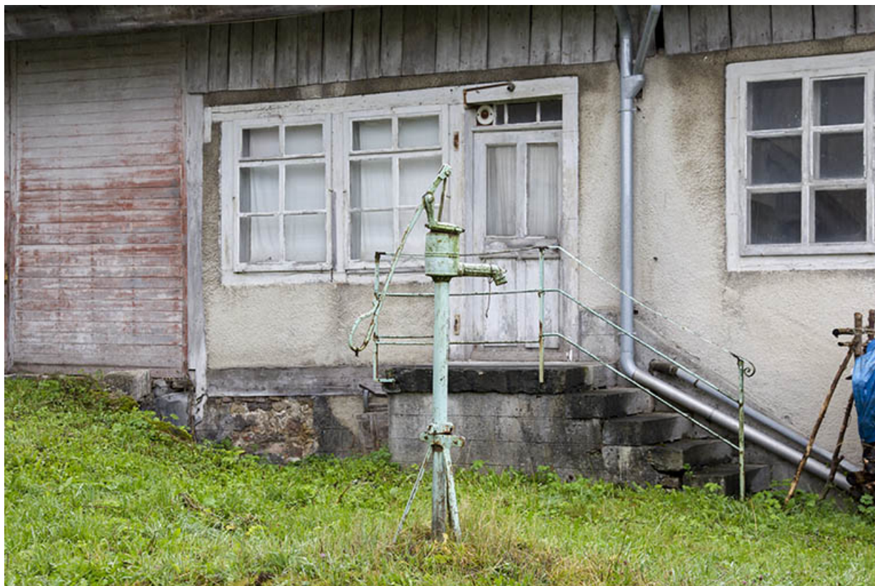
Façade latérale droite : entrée et pompe à eau. A gauche, la porte d'accès au fenil. 25, Charquemont, 9 Grande Rue
