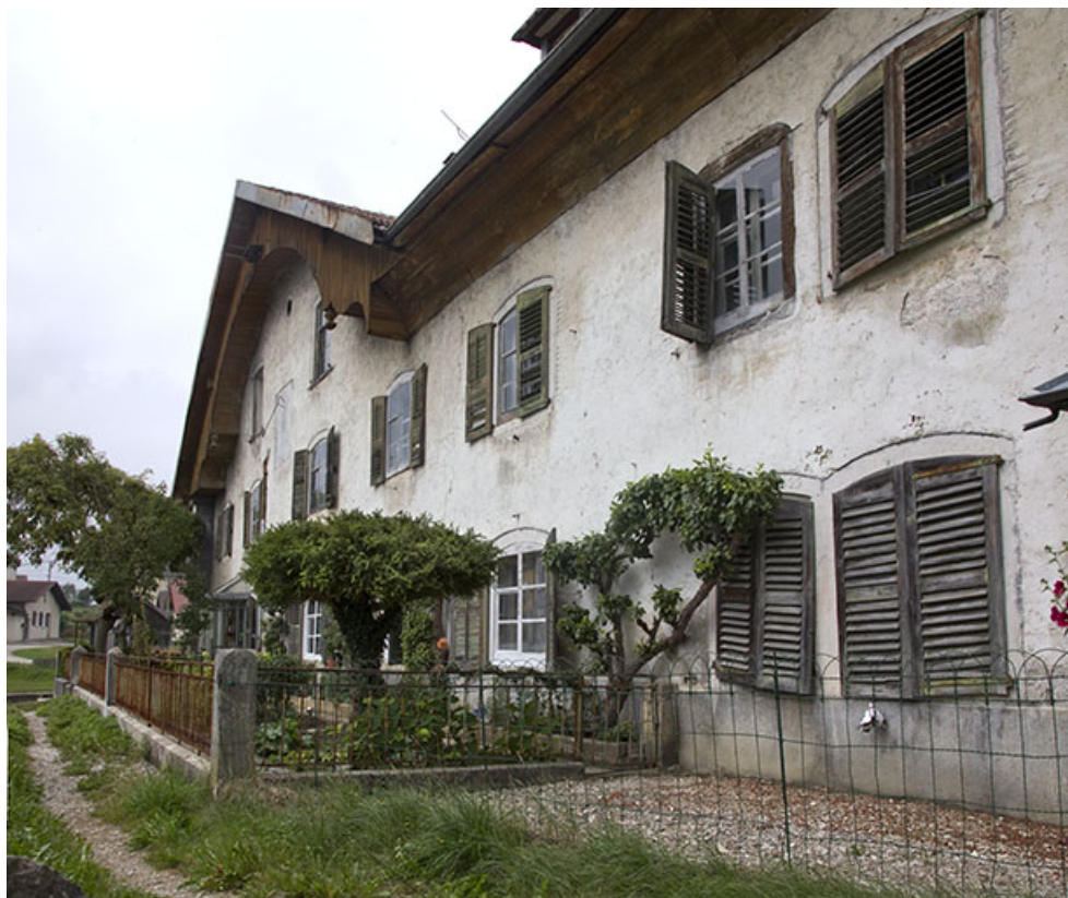
Façade antérieure, vue en enfilade depuis la droite.
