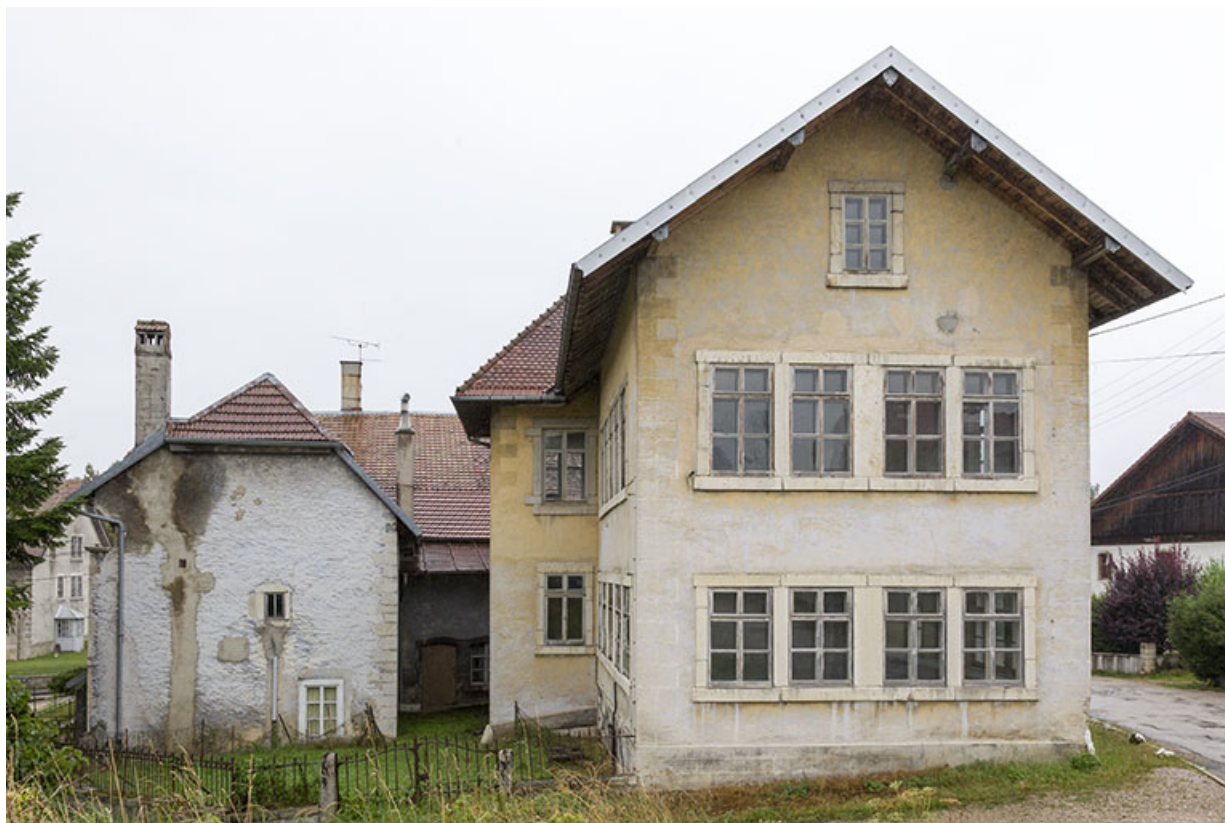
Usine : façade latérale gauche.
