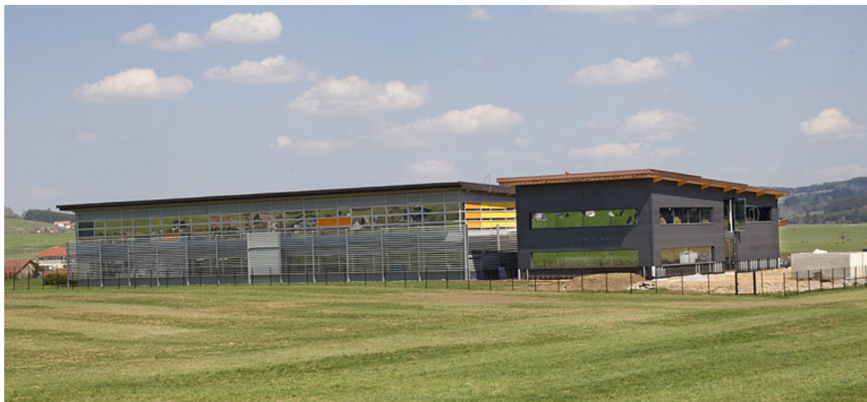
Façades postérieure et latérale gauche.
