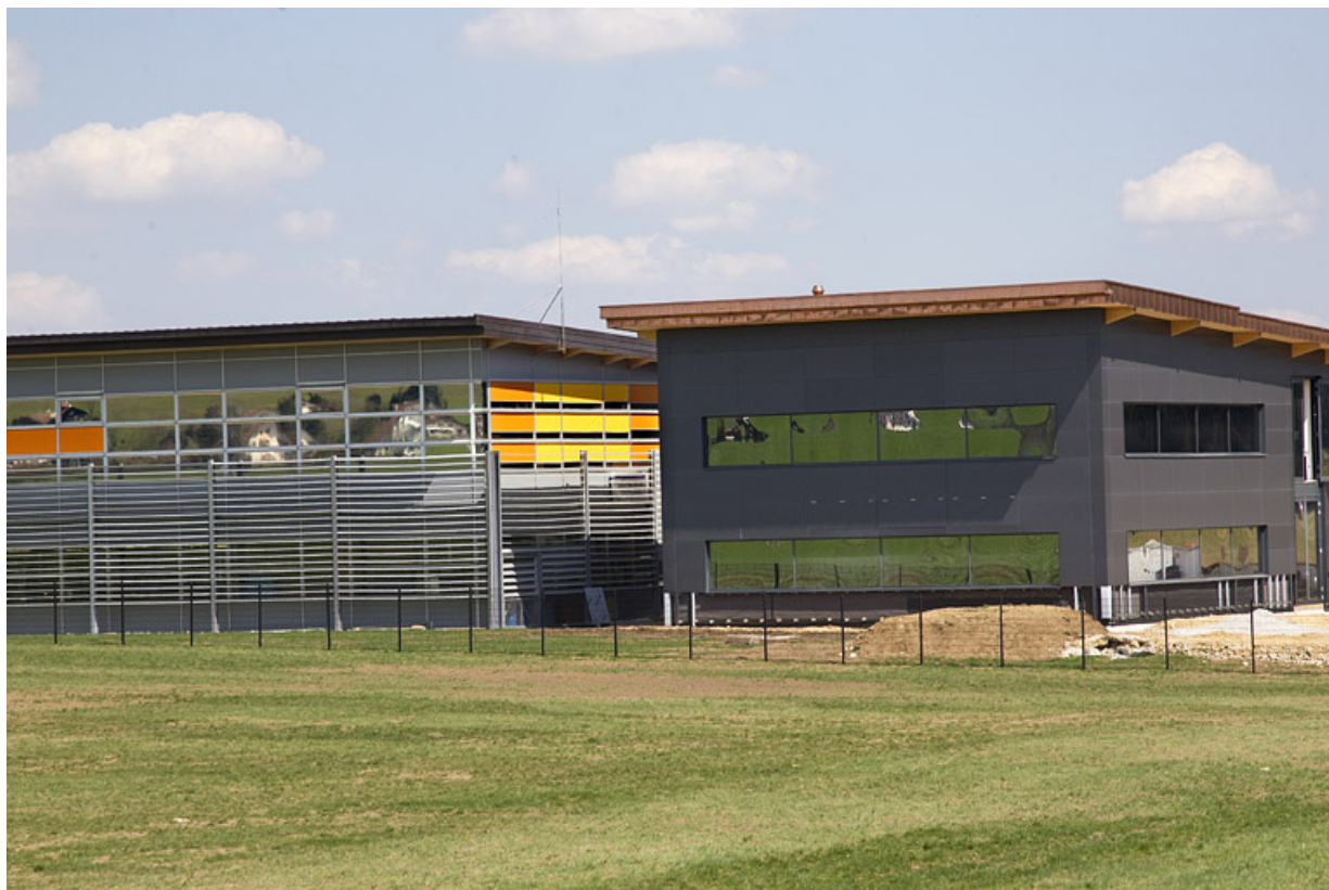
Atelier de 2013 et extrémité de celui de 2002. 25, Charquemont, 4 rue Pierre Frésard
