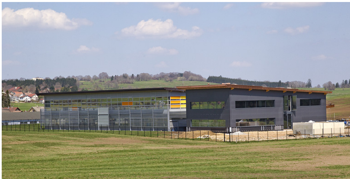
Usine de balanciers Frésard Composants, à Charquemont.
