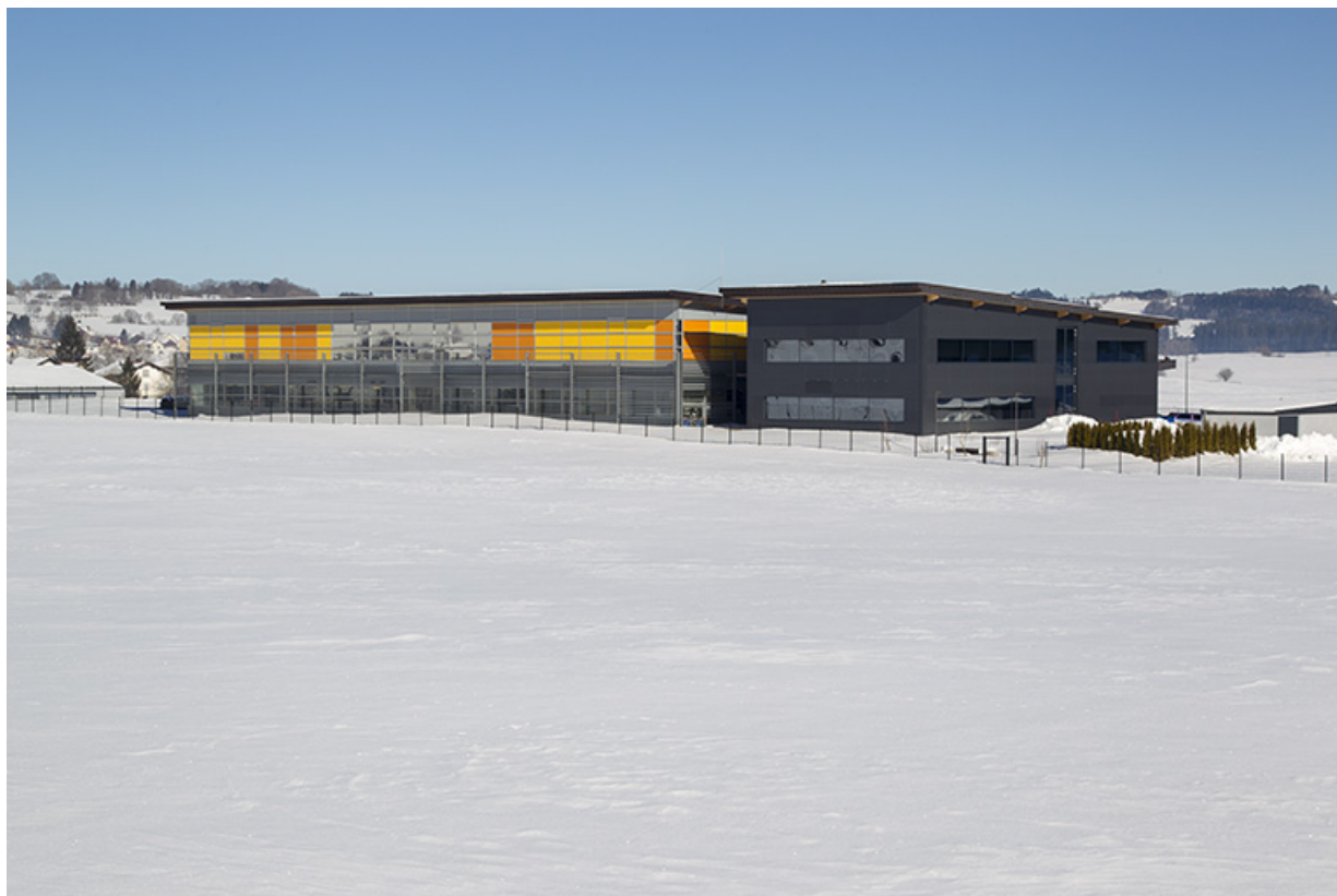
Une usine de 2002 (Sexer Loyrette Architecture) : usine de balanciers-spiraux Frésard Composants (4 rue Pierre Frésard). 25, Charquemont
