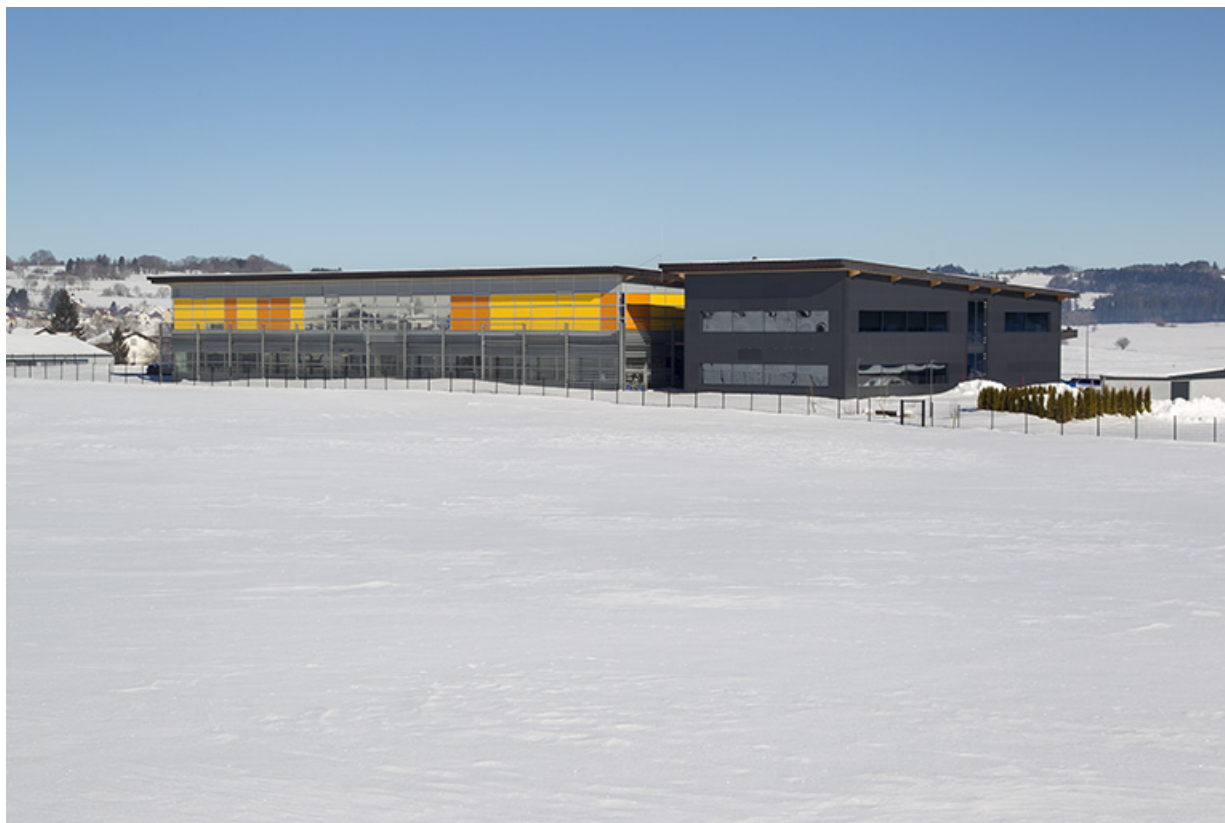
Une usine de 2002 (Sexer Loyrette Architecture) : usine de balanciers-spiraux Frésard Composants (4 rue Pierre Frésard). 25, Charquemont, 4 rue Pierre Frésard
