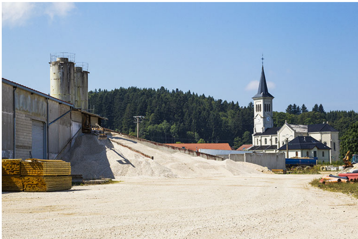
Atelier central : stockage de sable et gravier contre le mur nord. 25, Frambouhans, 10 Grande Rue
