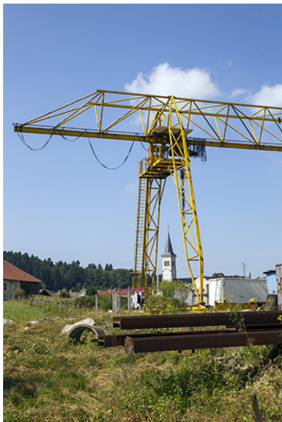
Portique roulant (extrémité sud).
