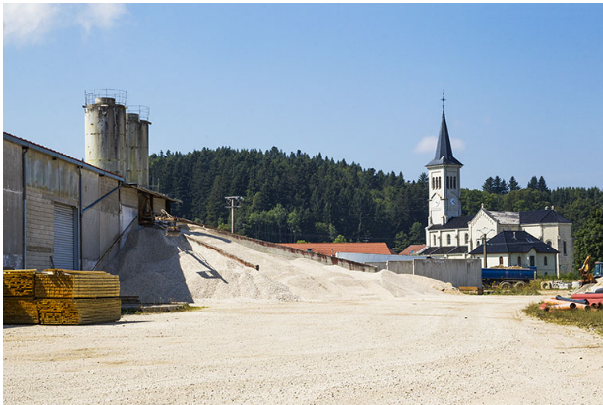
Atelier central : stockage de sable et gravier contre le mur nord.
