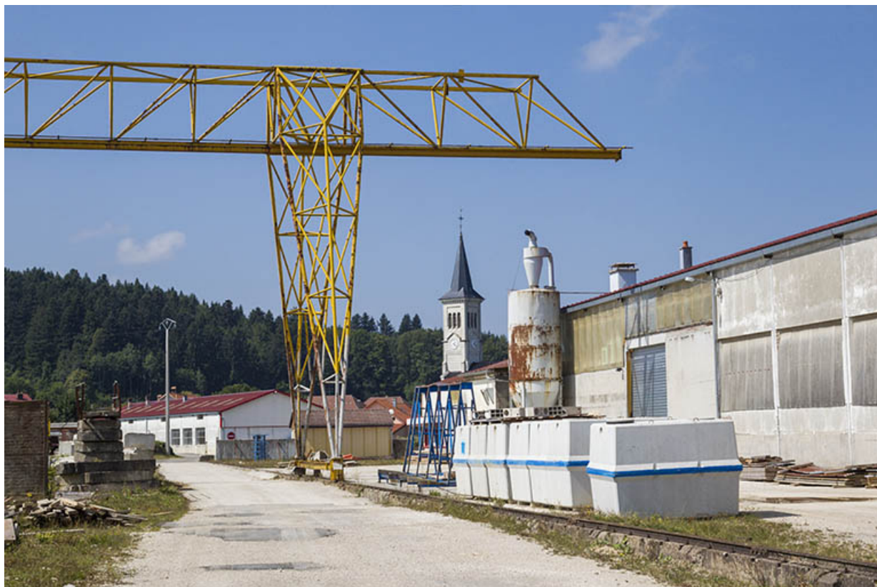
Ateliers vus en enfilade depuis l'est.
