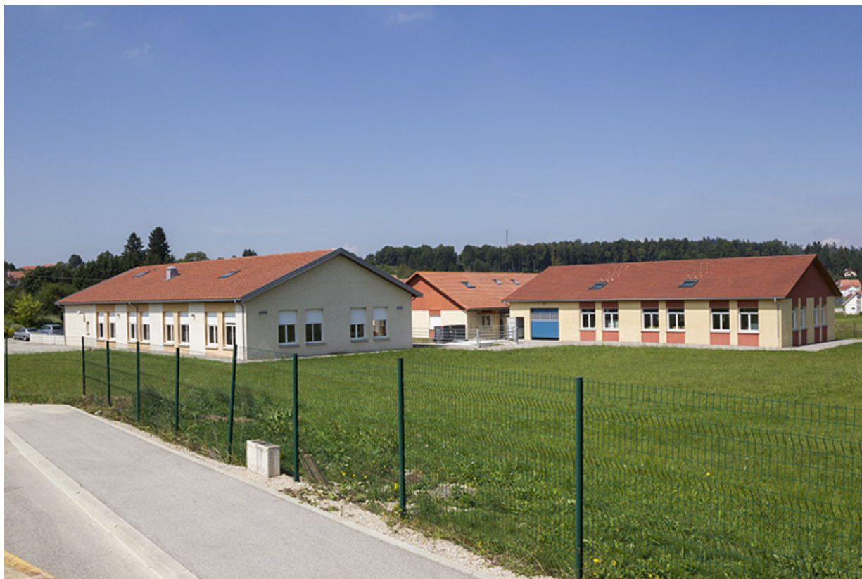
Ateliers sud et est : façades postérieure et latérale droite.
