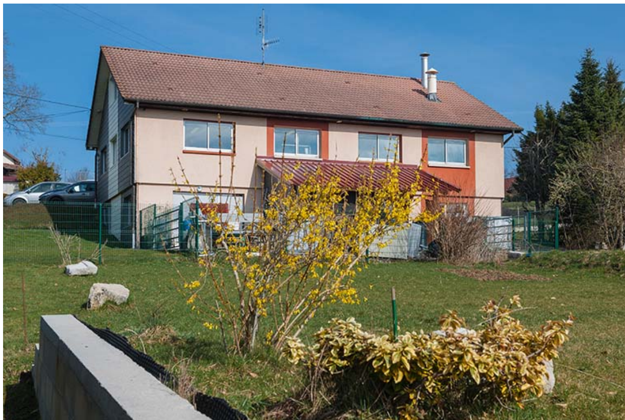
Usine : façade postérieure.
