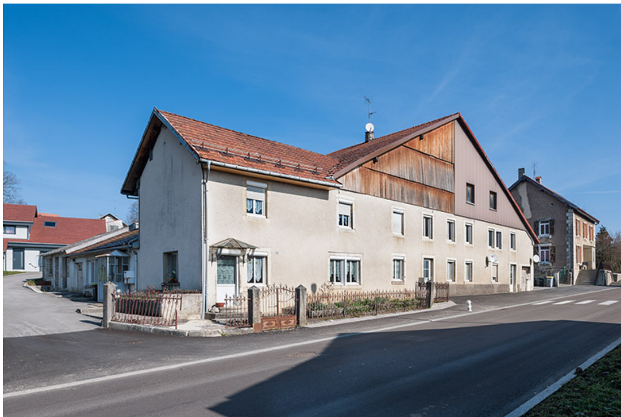
Ferme : façade antérieure, de trois quarts gauche.
