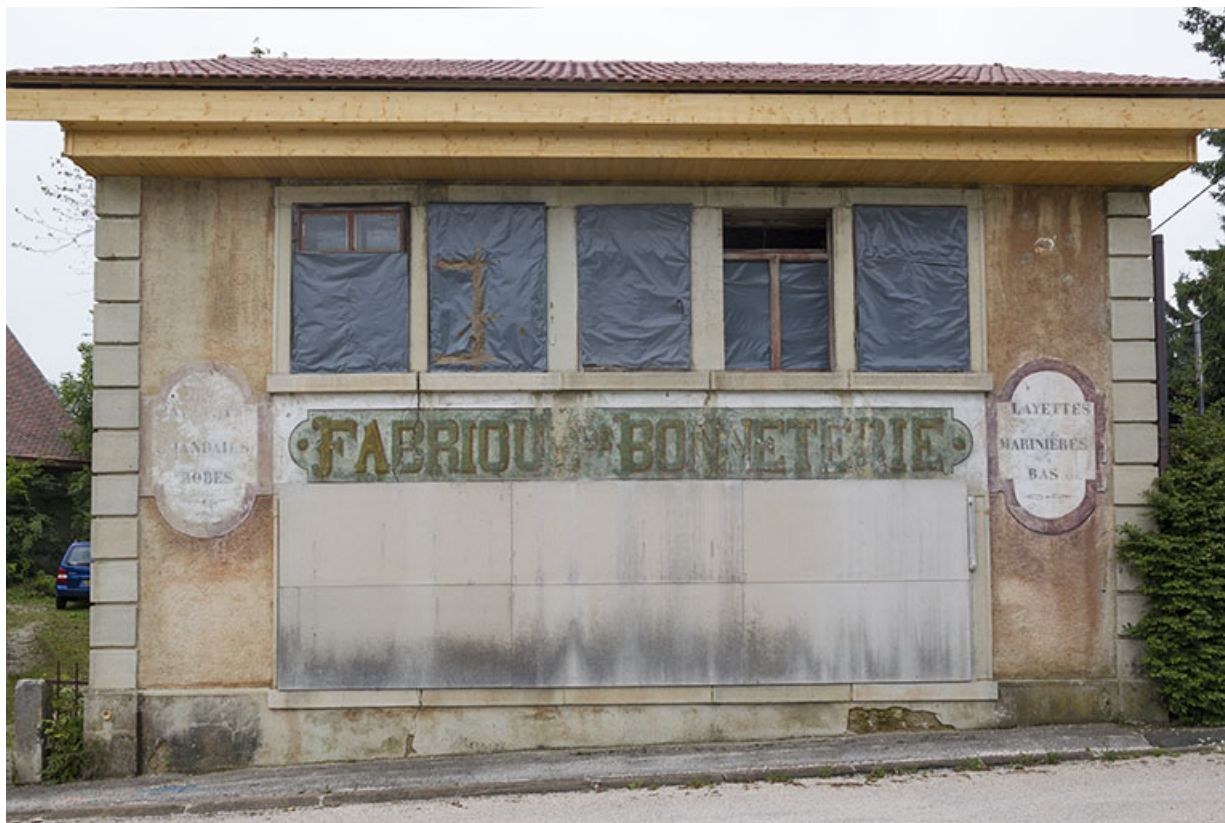
Usine : façade antérieure.
