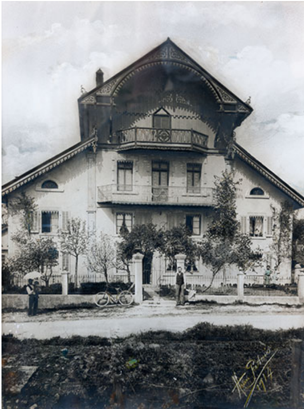
[Vue d'ensemble de l'ancienne ferme après surélévation], 1914 25, Frambouhans, 2 rue de la Bonneterie
