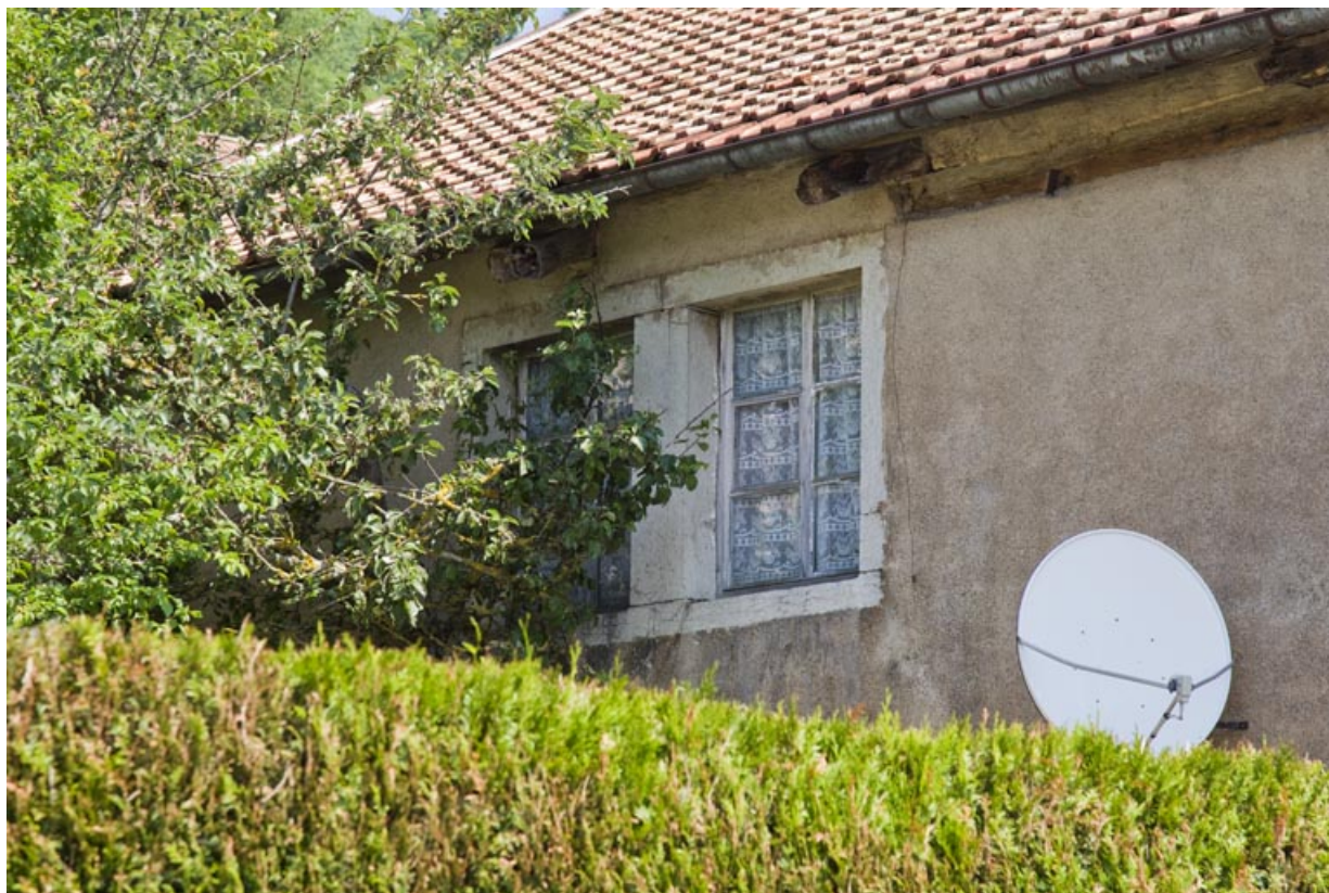
Fenêtre double sur la façade latérale gauche.
