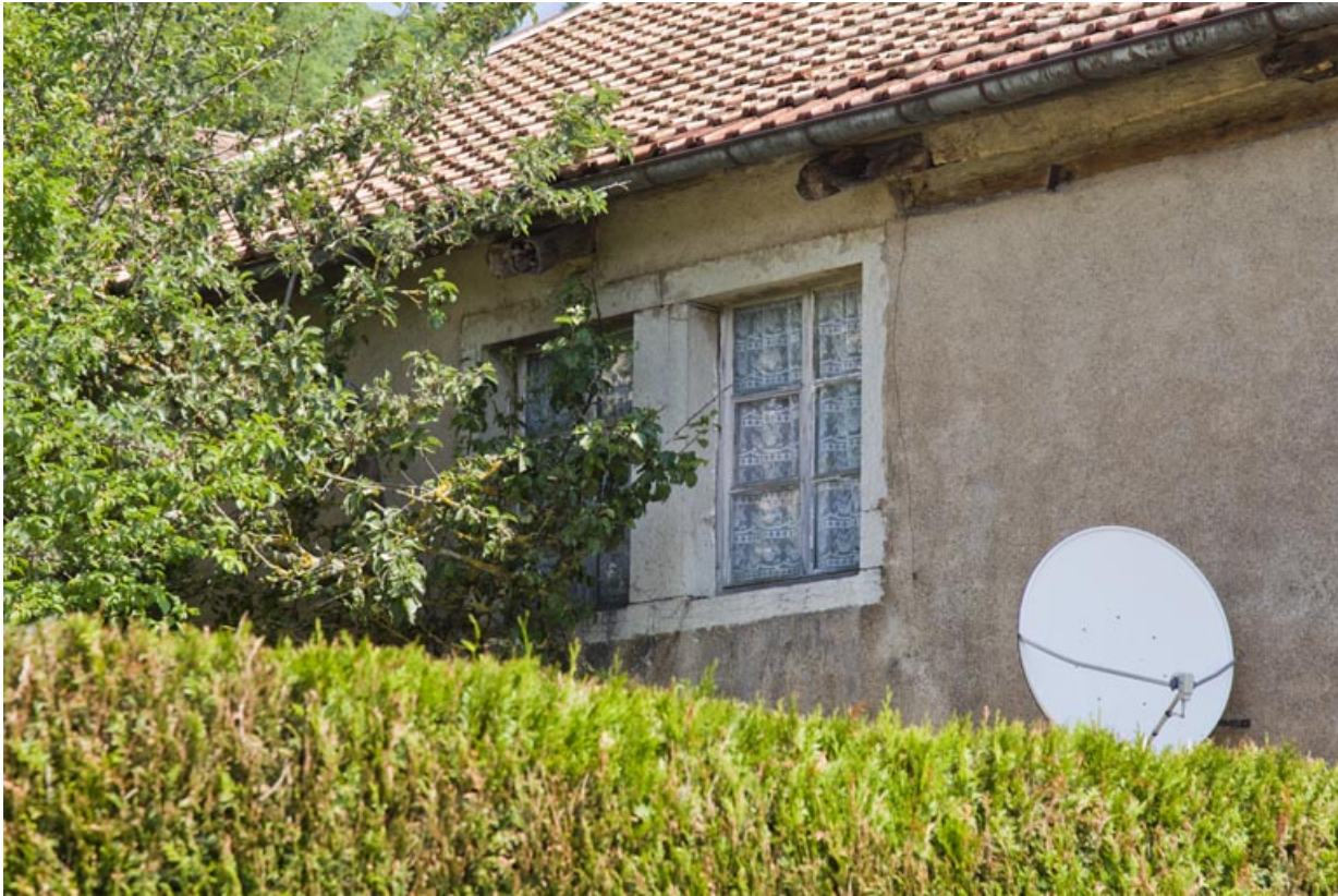
Fenêtre double sur la façade latérale gauche.
