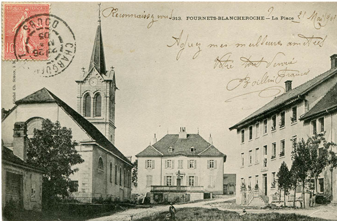
313. Fournets-Blancheroche - La Place [vue d'ensemble rapprochée de trois quarts droite], limite 19e siècle 20e siècle [avant 1905]. 25, Fournet-Blancheroche, 6 place François Joubert
