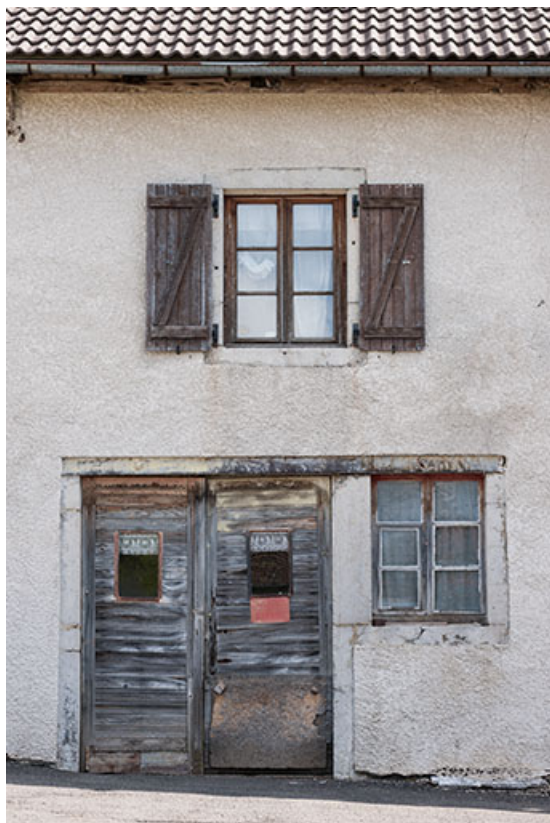
Ferme : porte et fenêtres sur la face latérale gauche. 25, Fournet-Blancheroche, 3-5 rue Ulysse Robert
