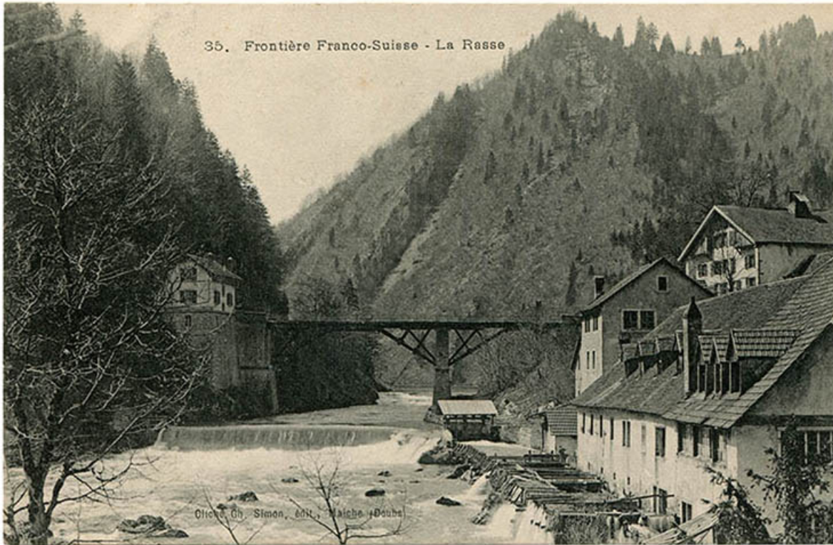
35. Frontière Franco-Suisse - La Rasse [vue rapprochée depuis l'aval], carte postale, entre 1893 et 1907. 25, Fournet-Blancheroche, lieudit : la Rasse
