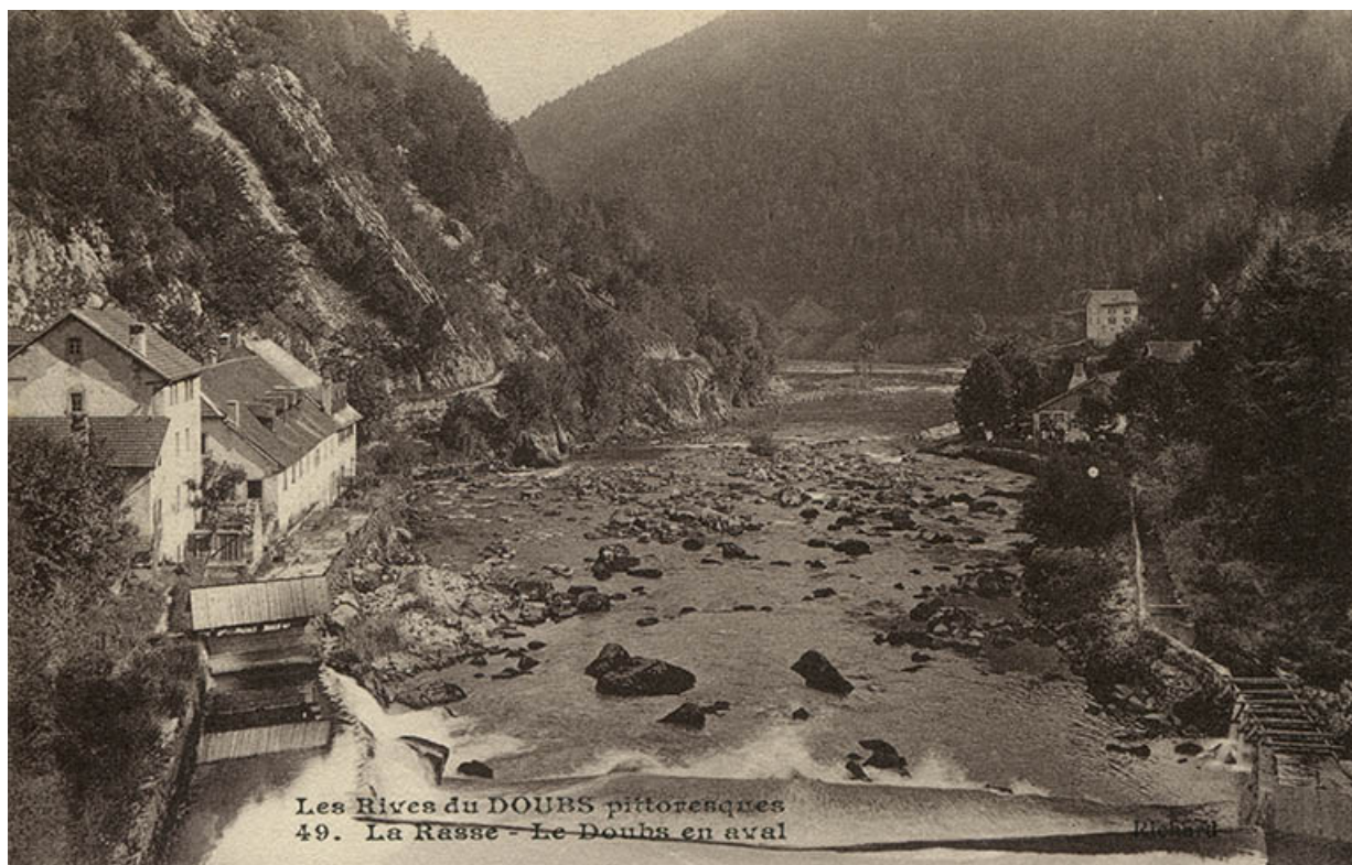
Les rives du Doubs pittoresques. 49. La Rasse - Le Doubs en aval [l'usine vue de la rive gauche en amont], 1er quart 20e siècle. 25, Fournet-Blancheroche, lieudit : la Rasse
