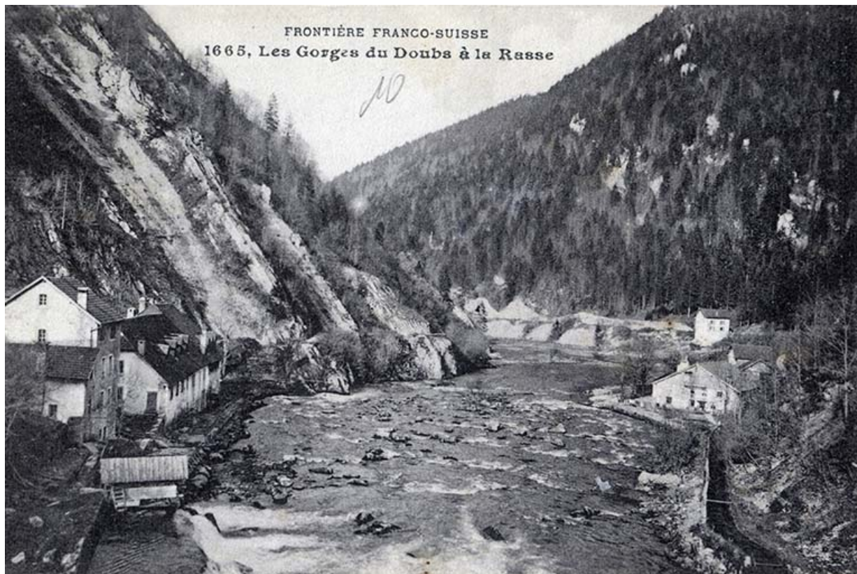
Frontière franco-suisse 1665. Les Gorges du Doubs à la Rasse [vue d'ensemble rapprochée depuis l'amont], entre 1907 et 1924. 25, Fournet-Blancheroche, lieudit : la Rasse
