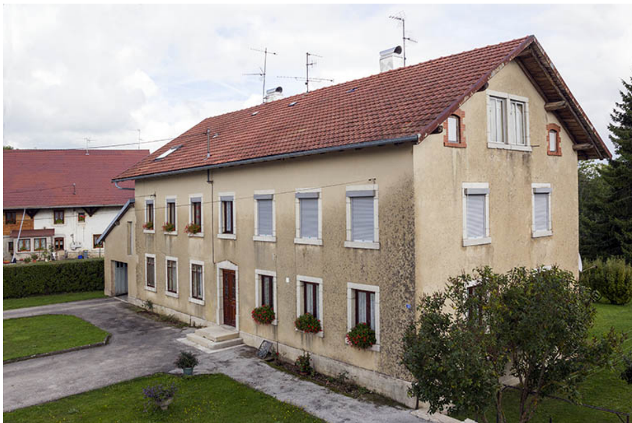
Façades antérieure et latérale droite.
