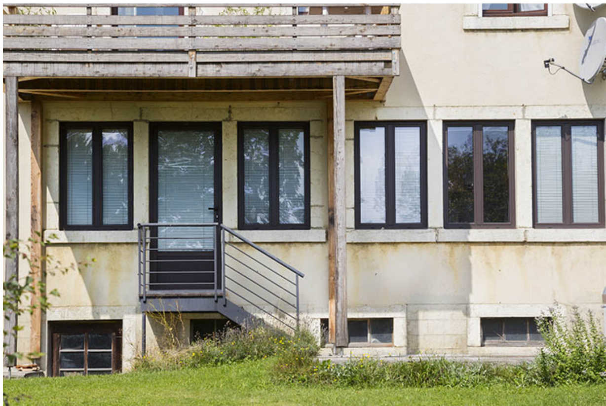
Façade postérieure : fenêtres de l'atelier.
