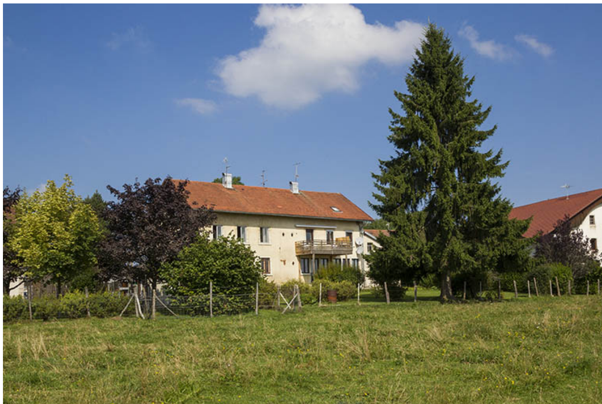
Vue d'ensemble, depuis l'est (façade postérieure).
