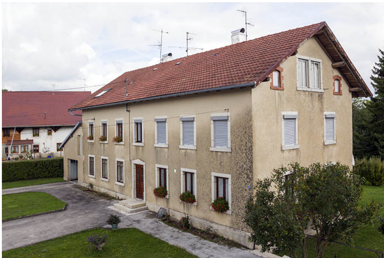
Façades antérieure et latérale droite.
