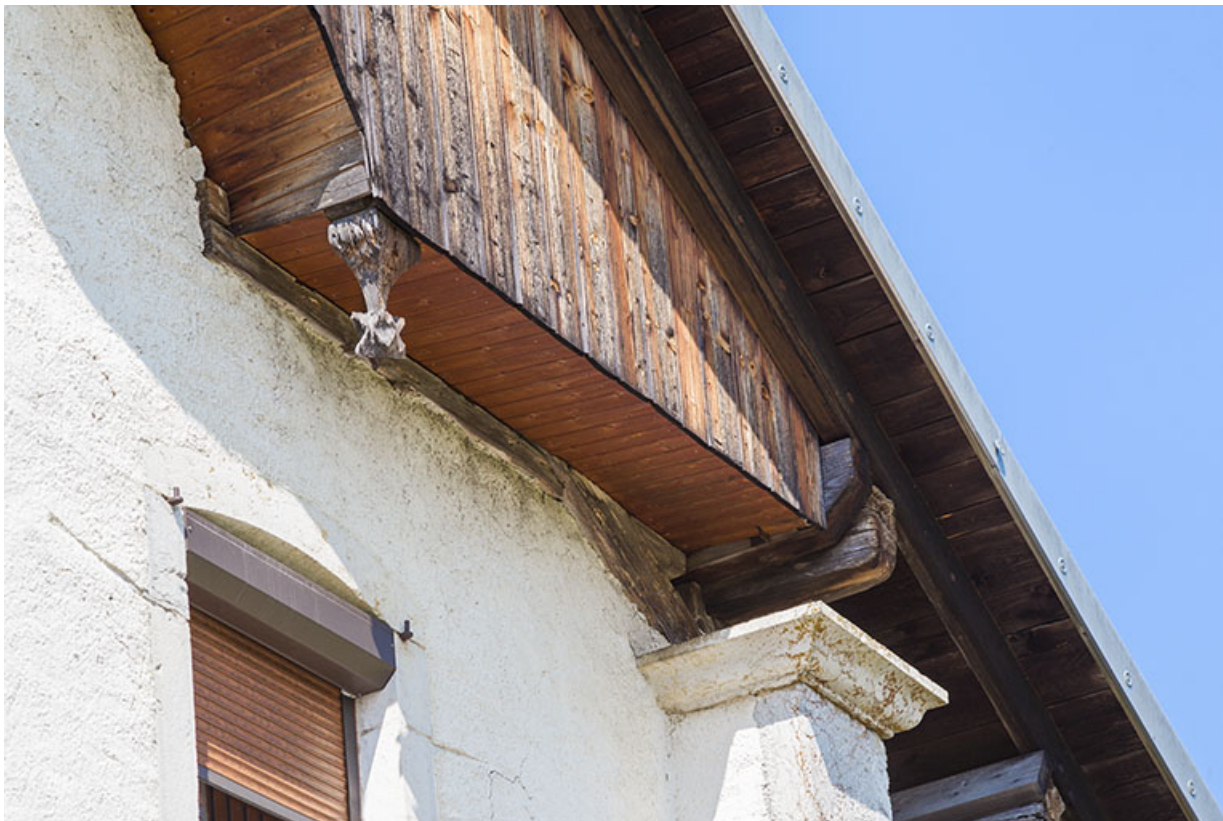
Façade est : chapiteau d'une coche et motif décoratif ornant l'extrémité pendante d'un poteau de la lambrichure. 25, Les Écorces, 17 et 17 bis Grande Rue
