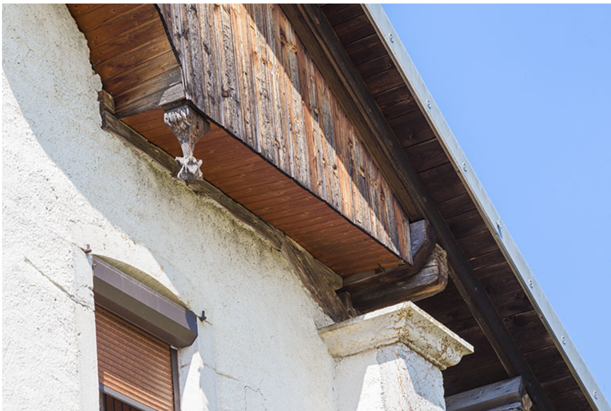
Façade est : chapiteau d'une coche et motif décoratif ornant l'extrémité pendante d'un poteau de la lambrichure. 25, Les Écorces, 17 et 17 bis Grande Rue
