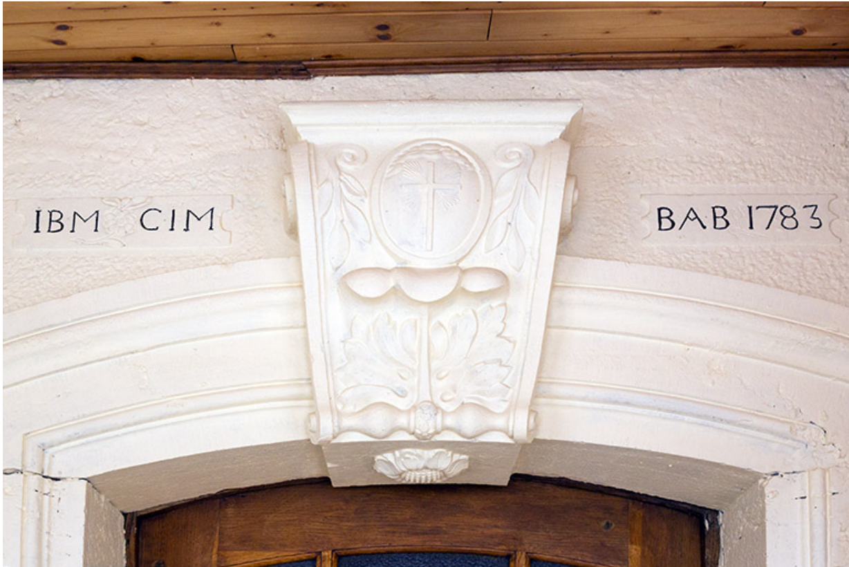
Façade sud : arc monolithe en béton avec sa fausse clef de voûte, des initiales et un chronogramme.
