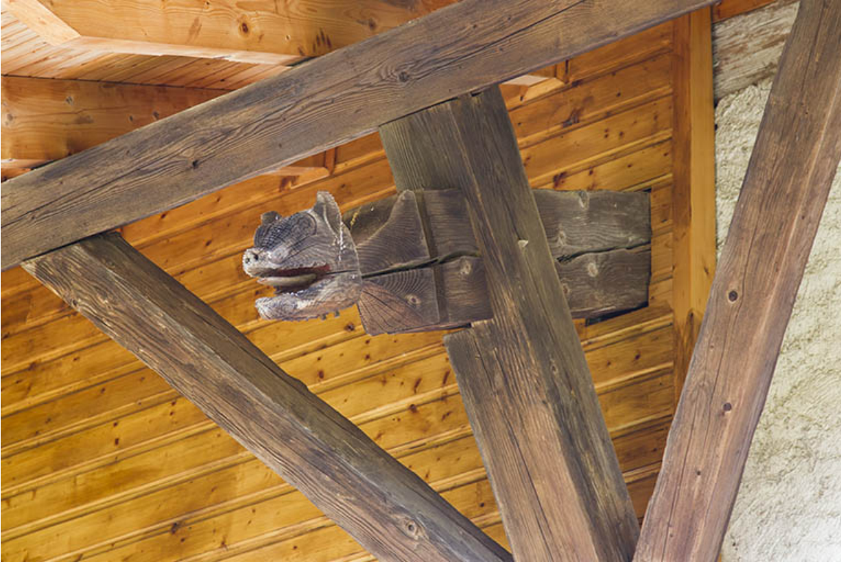
Façade sud : extrémité sculptée d'une pièce de la charpente supportant la toiture débordante.
