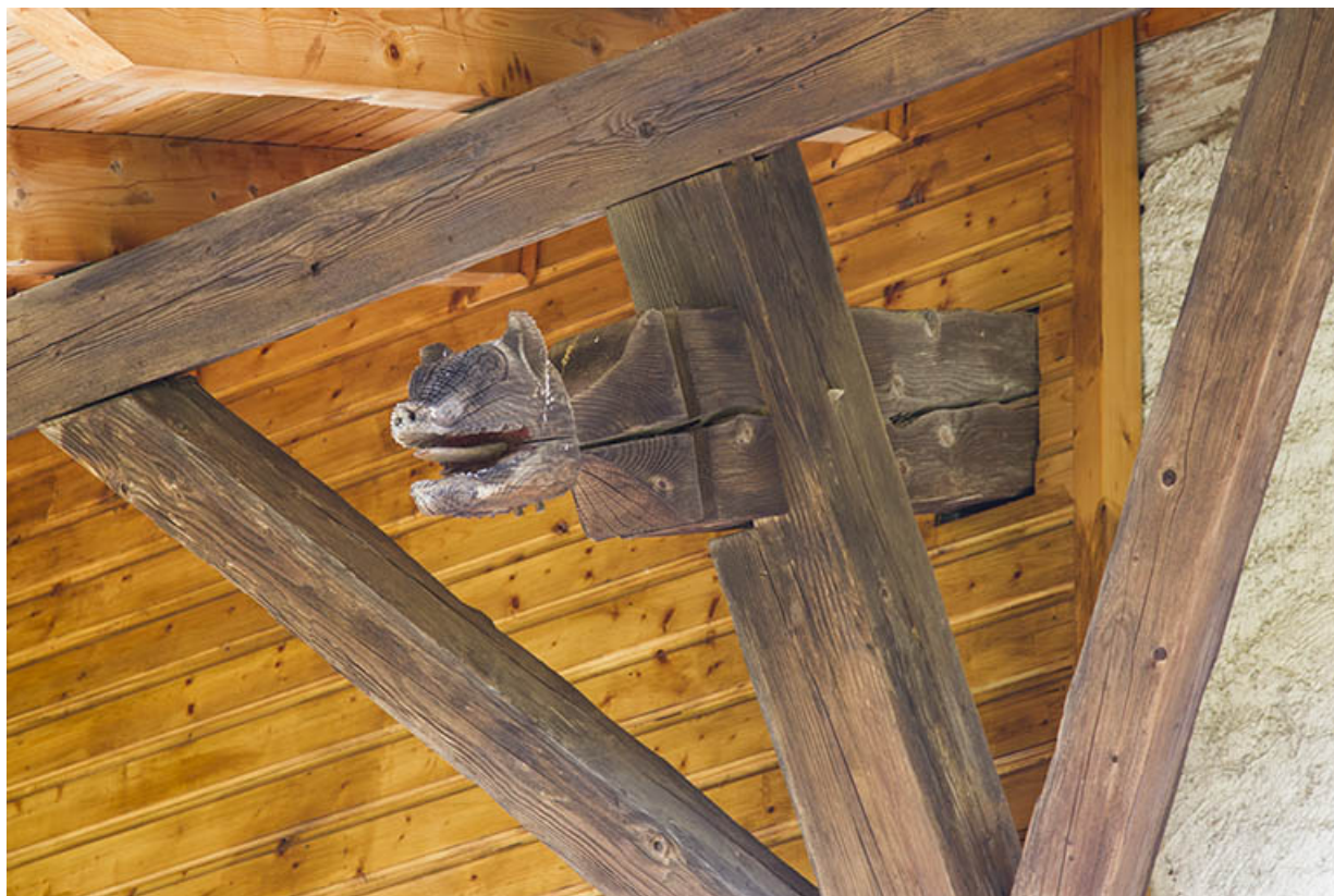
Façade sud : extrémité sculptée d'une pièce de la charpente supportant la toiture débordante. 25, Les Écorces, 17 et 17 bis Grande Rue
