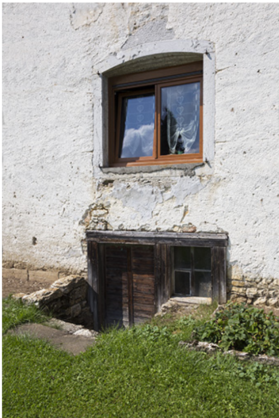
Façade est : accès au sous-sol et fenêtre de l'ancien salon.
