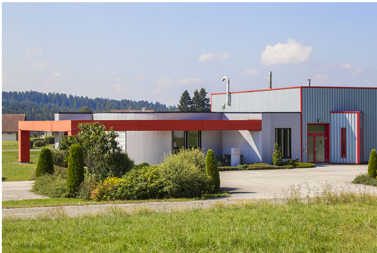
Façade antérieure : bureaux et entrée.
