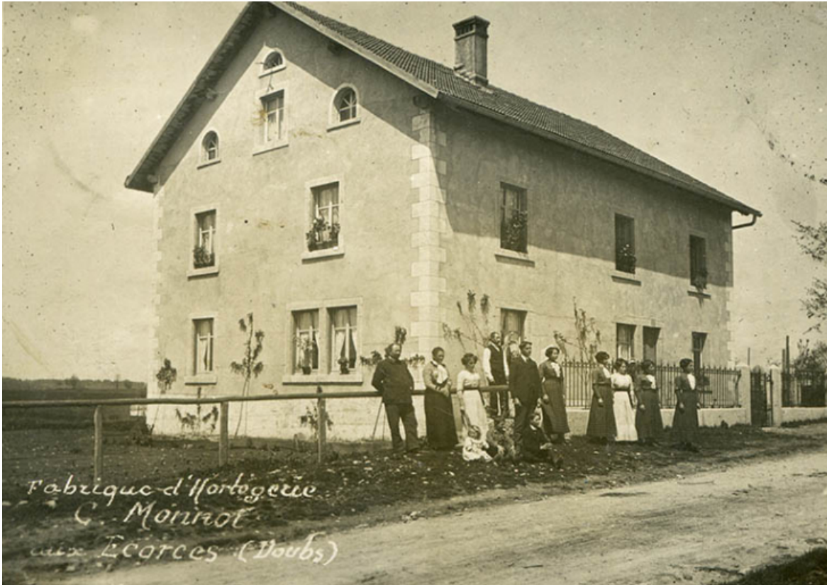
Fabrique d'horlogerie C. Monnot aux Écorces (Doubs) [le bâtiment vu de trois quarts gauche], 1er quart 20e siècle (avant 1912). Constant Monnot (à gauche) et sa famille (Laurent est visible à l'arrière-plan). 25, Les Écorces, 12, 14 Grande Rue
