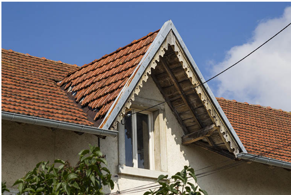
Maison au 14 Grande Rue : lucarne sur la façade antérieure.
