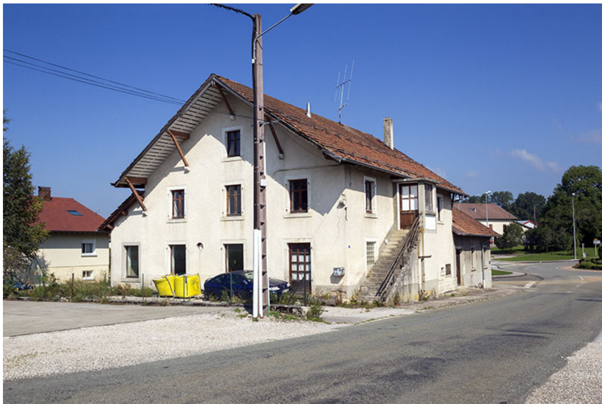
Façades antérieure et latérale droite.
