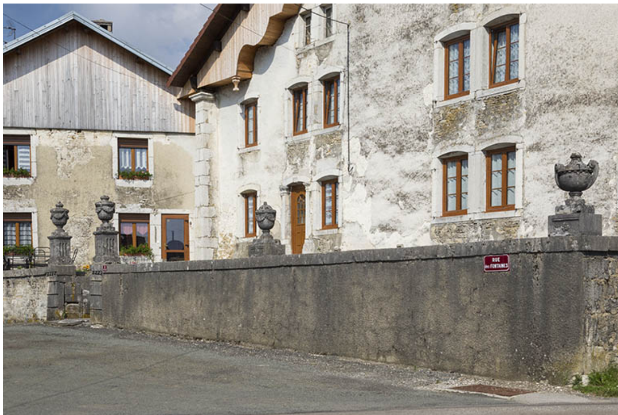
Terrasse surélevée à l'avant de la ferme.
