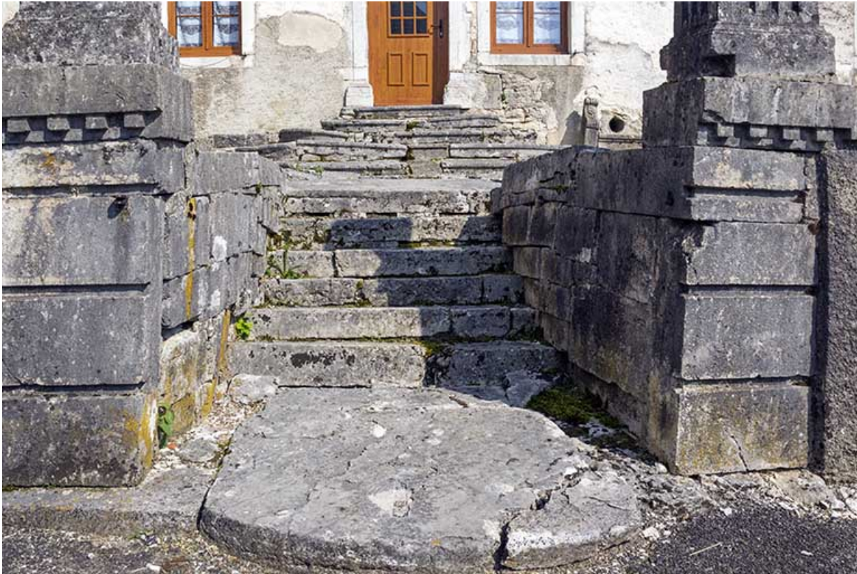
Terrasse surélevée : escalier.
