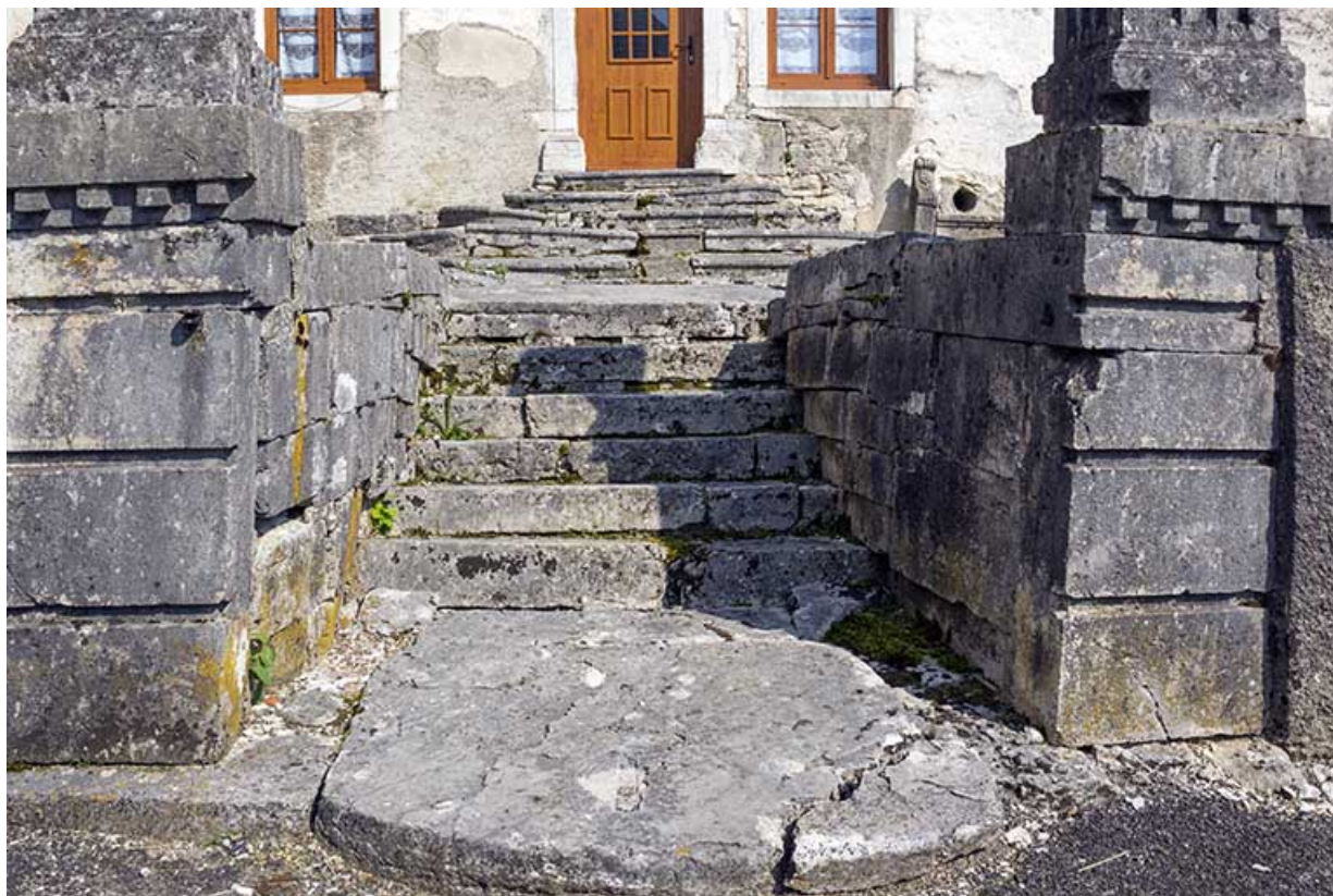
Terrasse surélevée : escalier.
