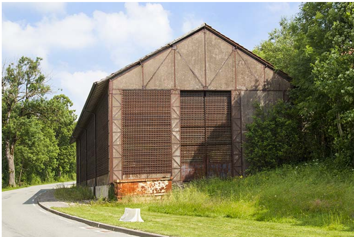
Site rue du Jura : entrepôt industriel, vu depuis l'atelier de fabrication. 25, Tréviillers, 11 rue du Jura
