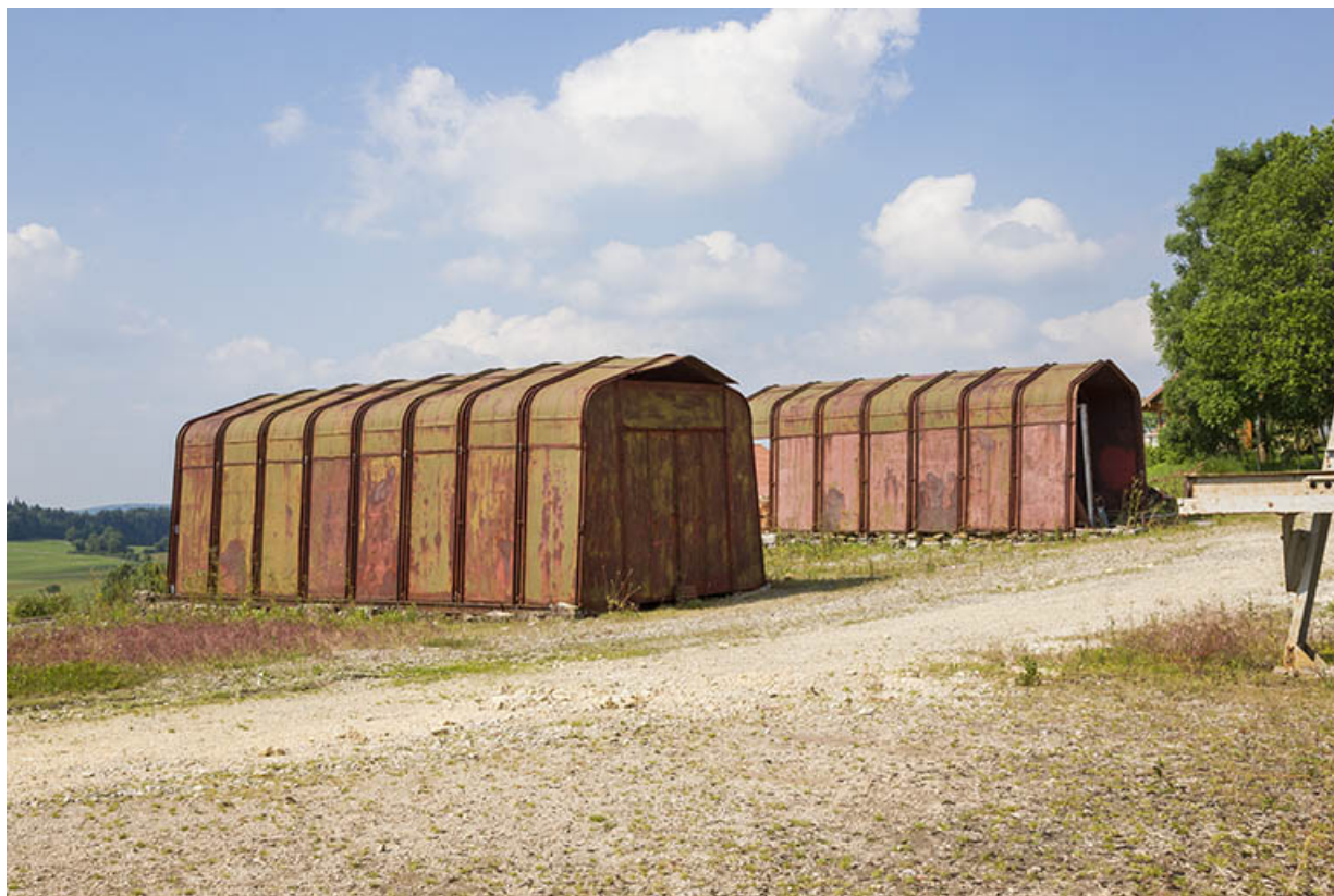
Site rue du Contremont : bâtiments métalliques à parois inclinées Fillod. 25, Trévillers, 11 rue du Jura
