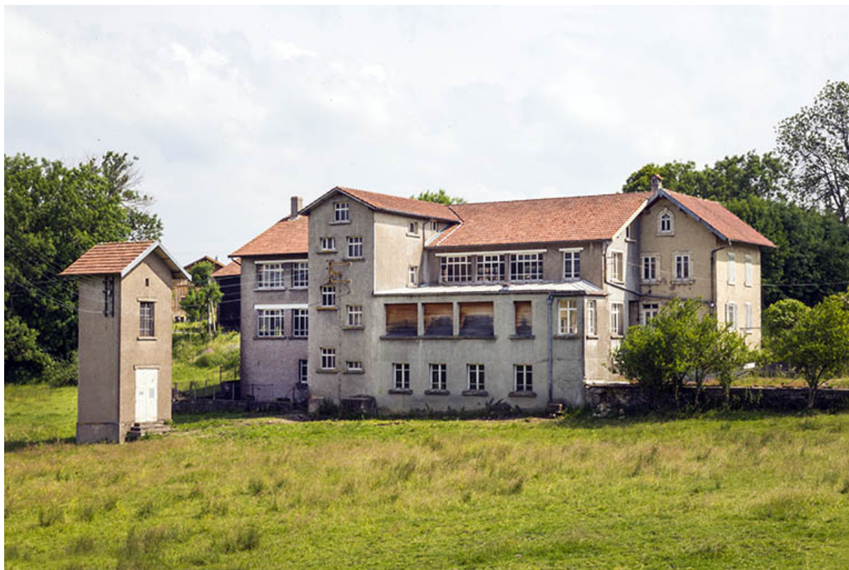
Site rue du Jura : atelier de fabrication et logement (façade postérieure). 25, Tréviillers, 11 rue du Jura
