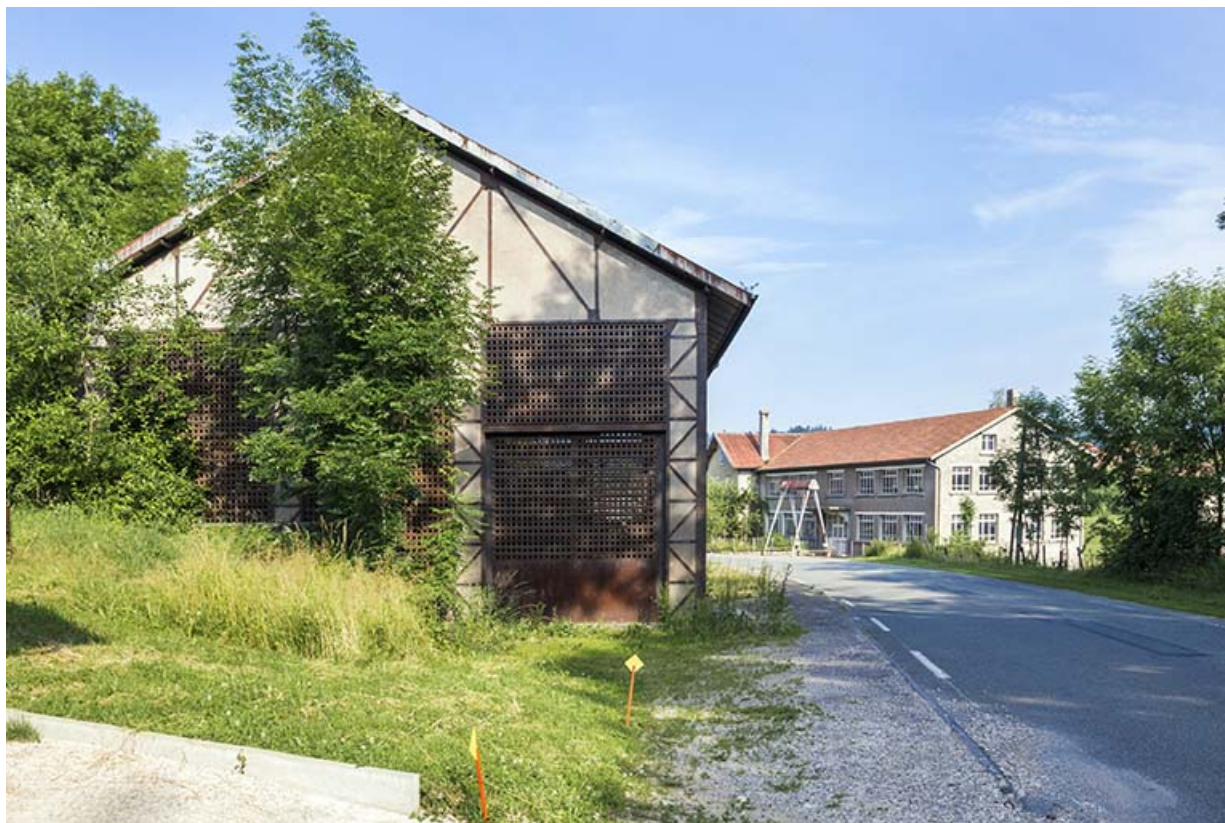
Site rue du Jura : vue d'ensemble depuis l'est. 25, Trévilleurs, 11 rue du Jura
