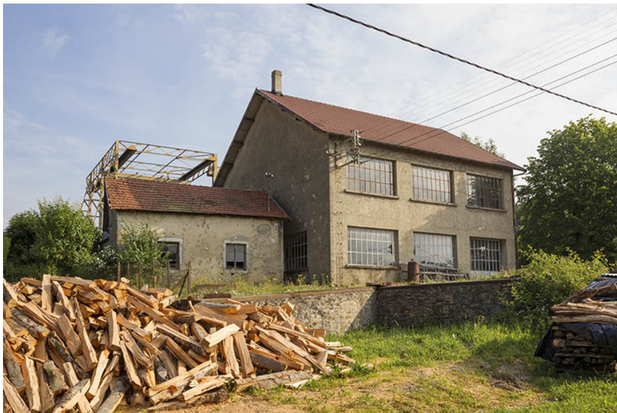
Site rue du Contremont : atelier de fabrication et ancien logement, depuis le sud (façade postérieure). 25, Tréviillers, 11 rue du Jura
