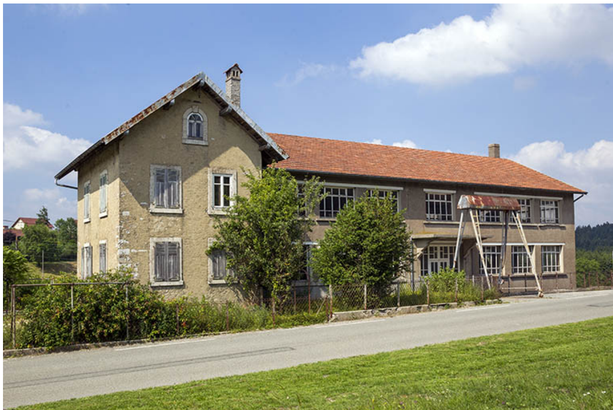
Site rue du Jura : logement, atelier de fabrication et portique (façade antérieure de trois quarts gauche). 25, Tréviillers, 11 rue du Jura
