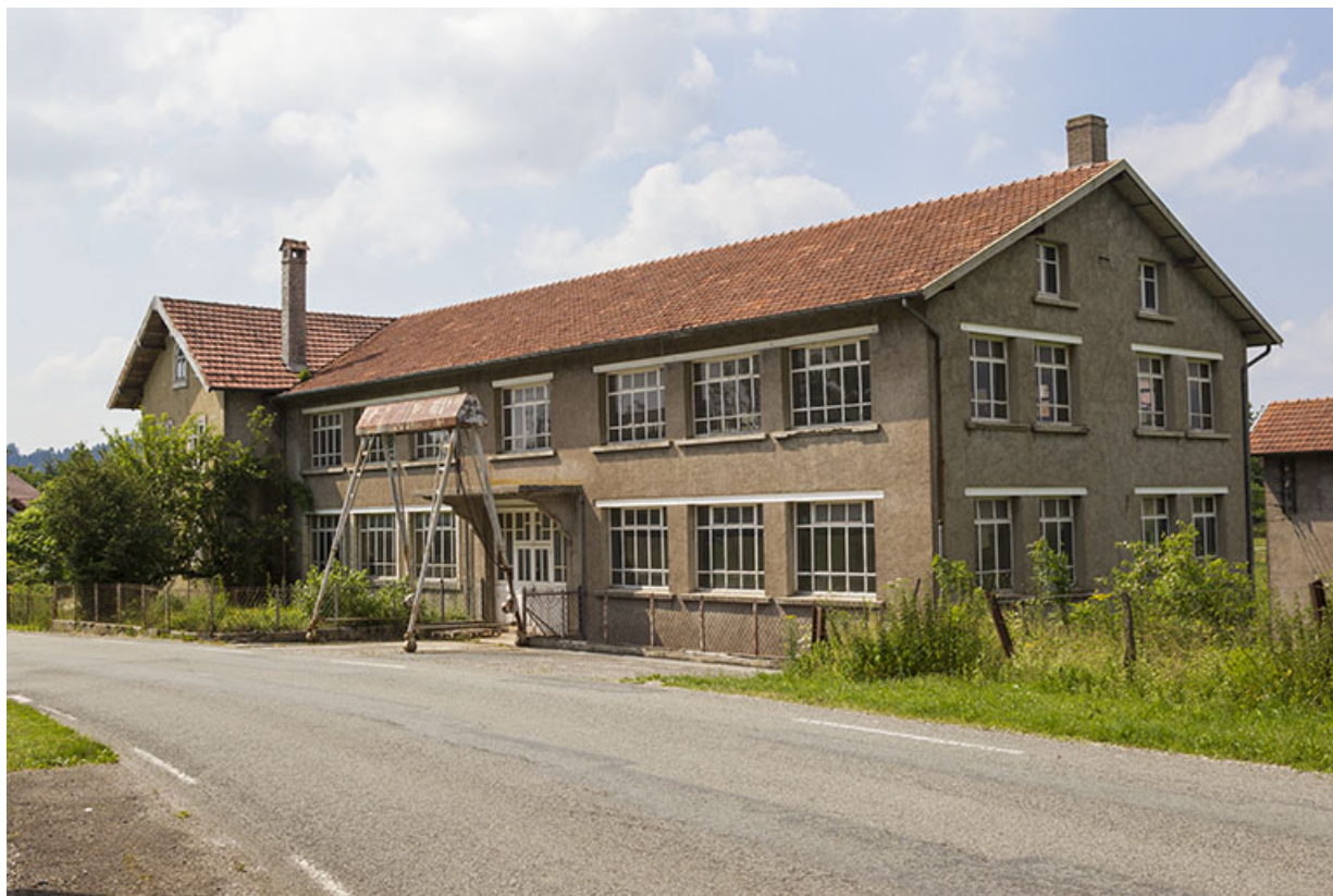
Site rue du Jura : atelier de fabrication et portique (façade antérieure de trois quarts droite). 25, Tréviillers, 11 rue du Jura
