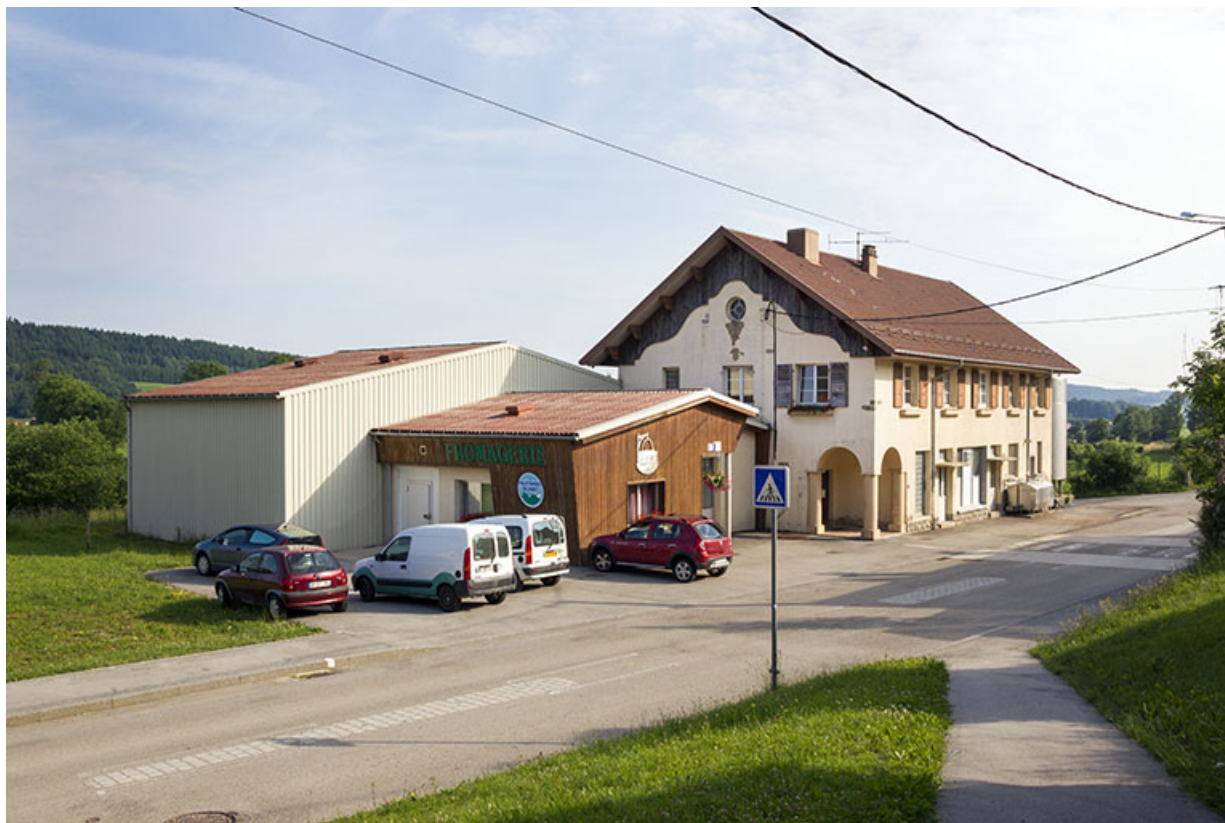
Nouvelle fromagerie : vue d'ensemble, depuis le sud.
