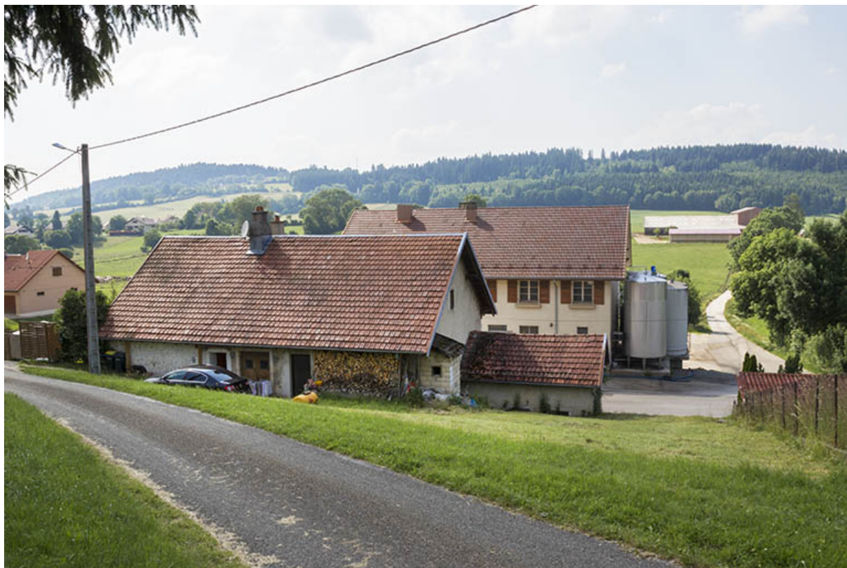
Ancienne fromagerie : façade postérieure (vue du nord-est).
