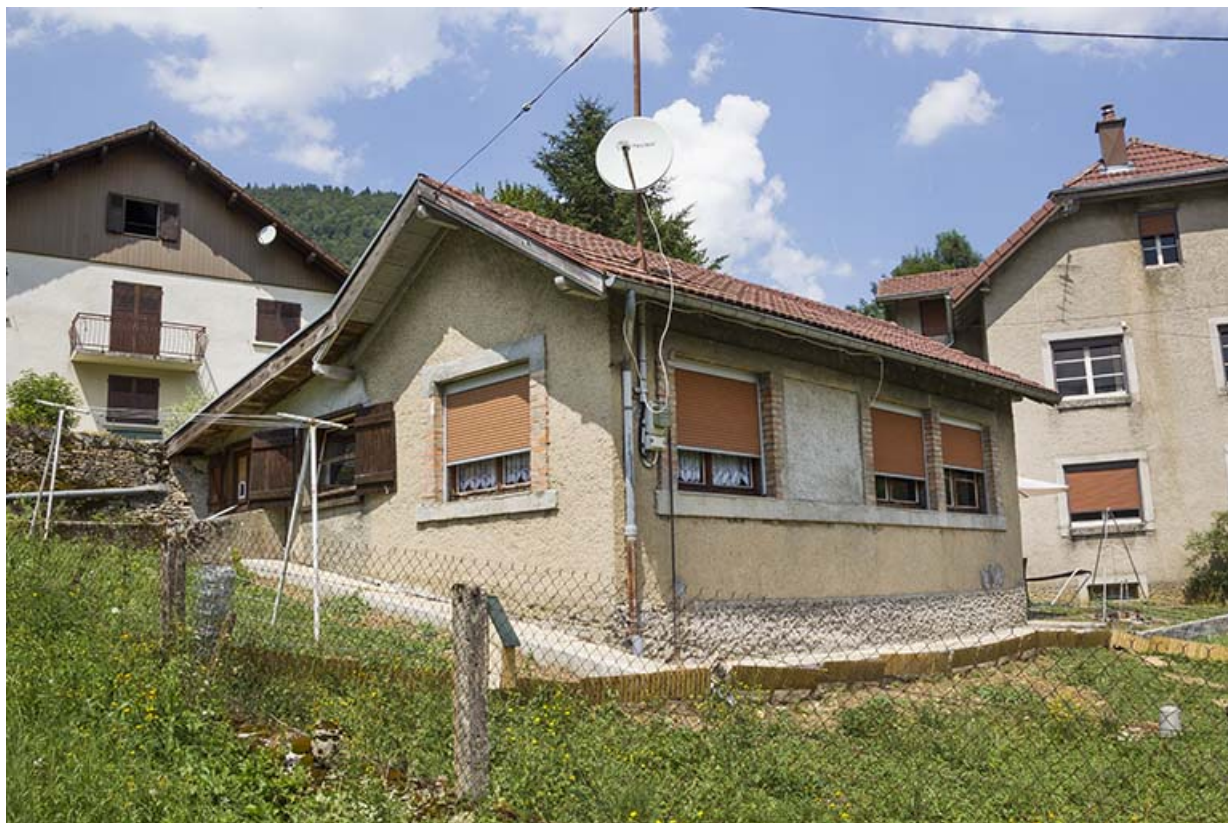
L'atelier de fabrication, depuis le sud.
