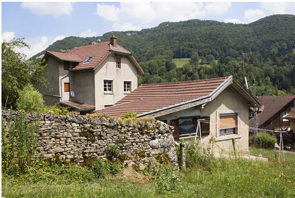
Atelier de fabrication et logement, depuis l'ouest.
