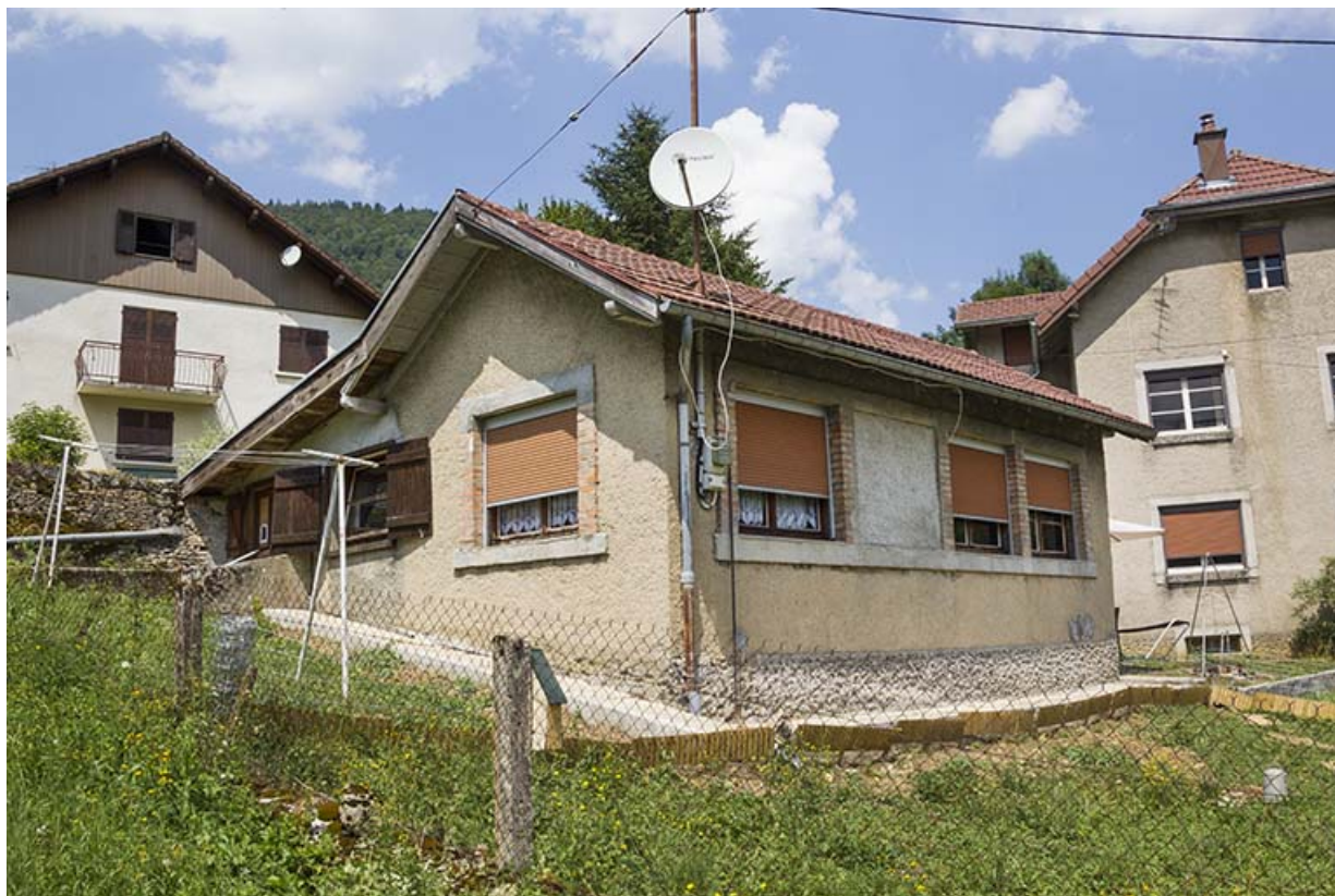
L'atelier de fabrication, depuis le sud.
