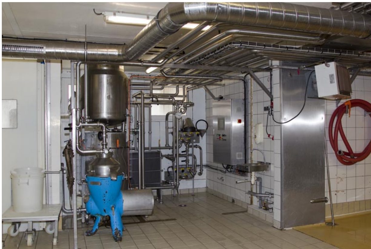
Écrémeuse et installation de dépotage du lait et refroidissement du sérum. 25, Charmauvillers, 6 Grande Rue
