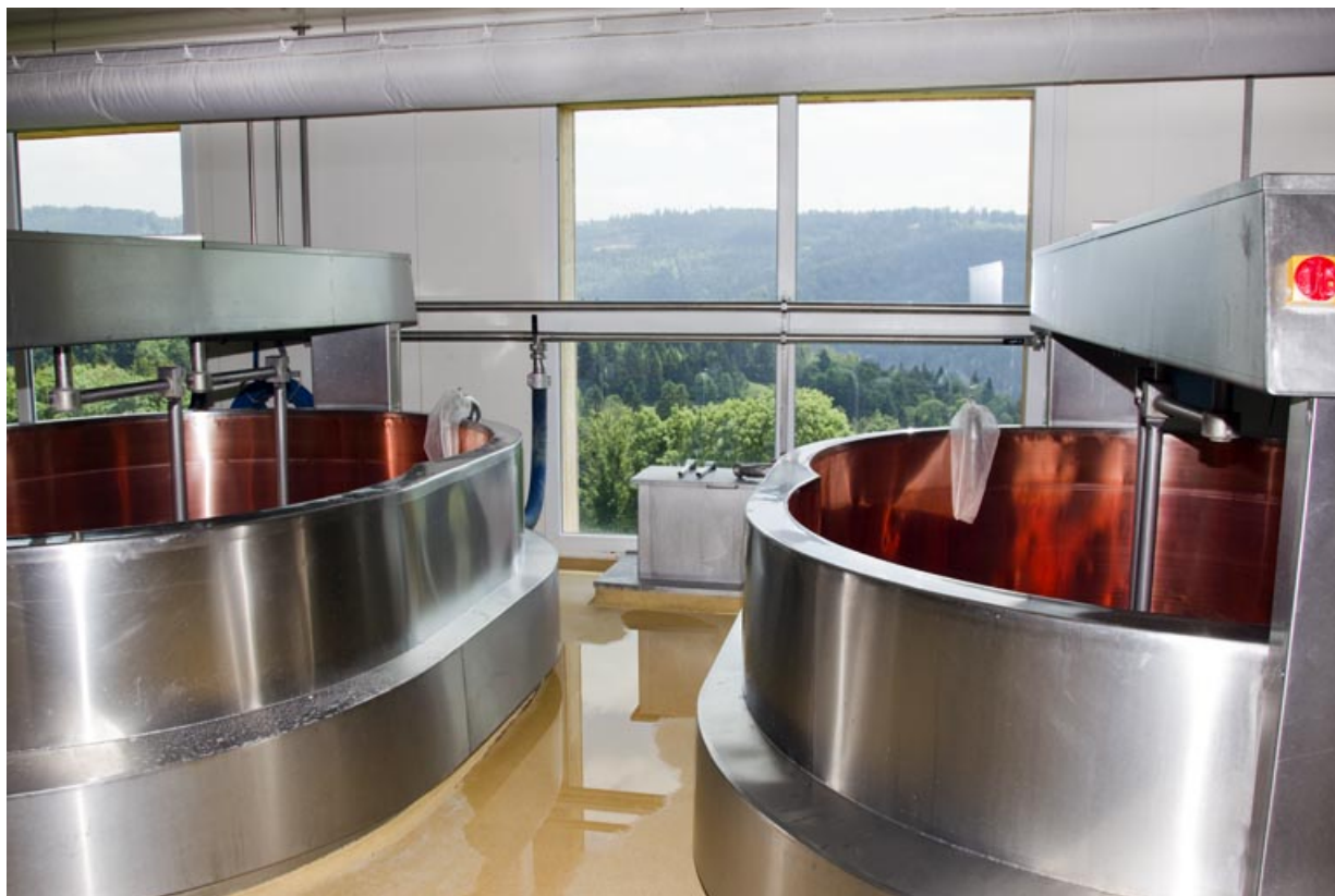
Cuves de fabrication et baie vitrée donnant sur la vallée.
