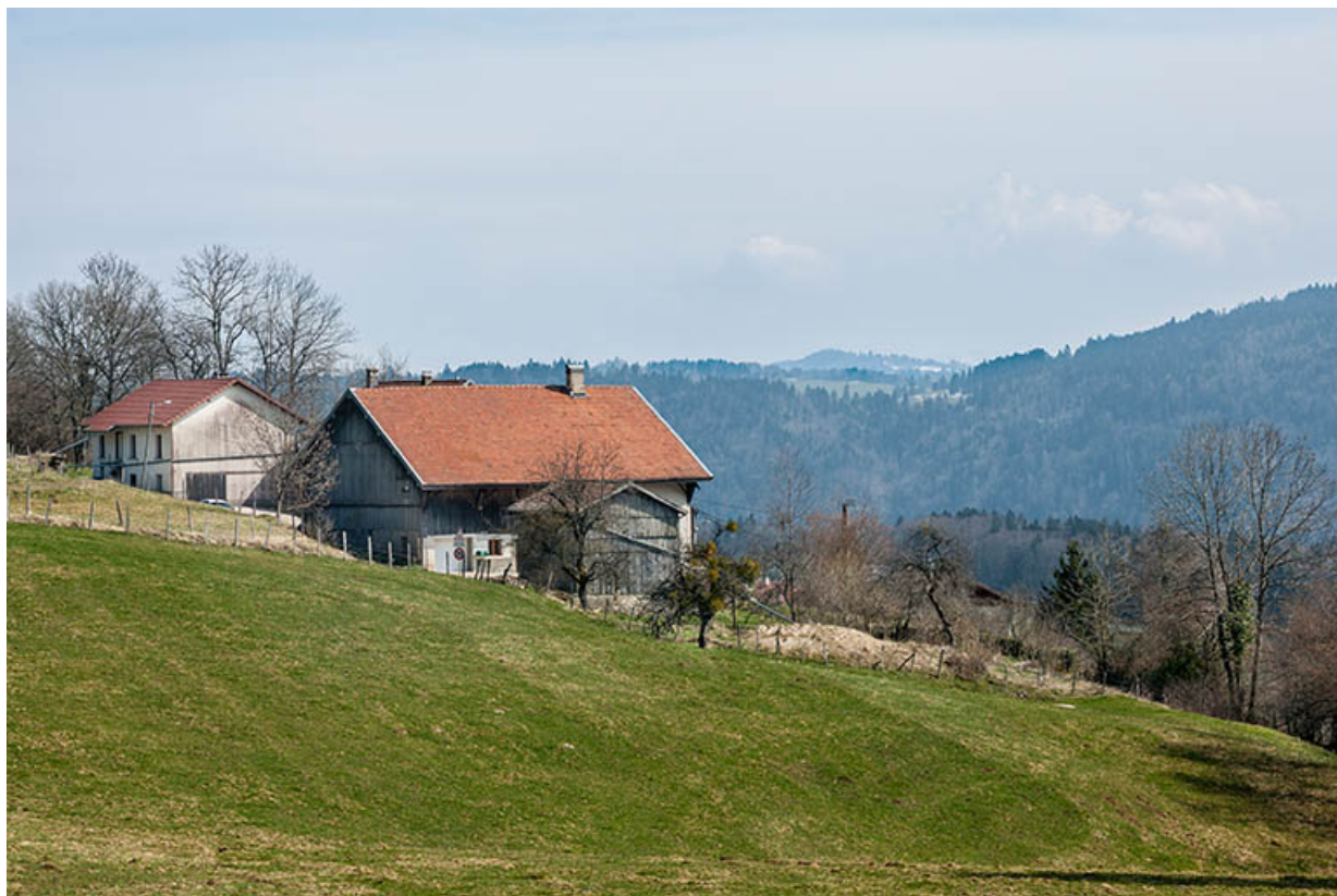
Garage, ferme et logement, depuis l'ouest.
