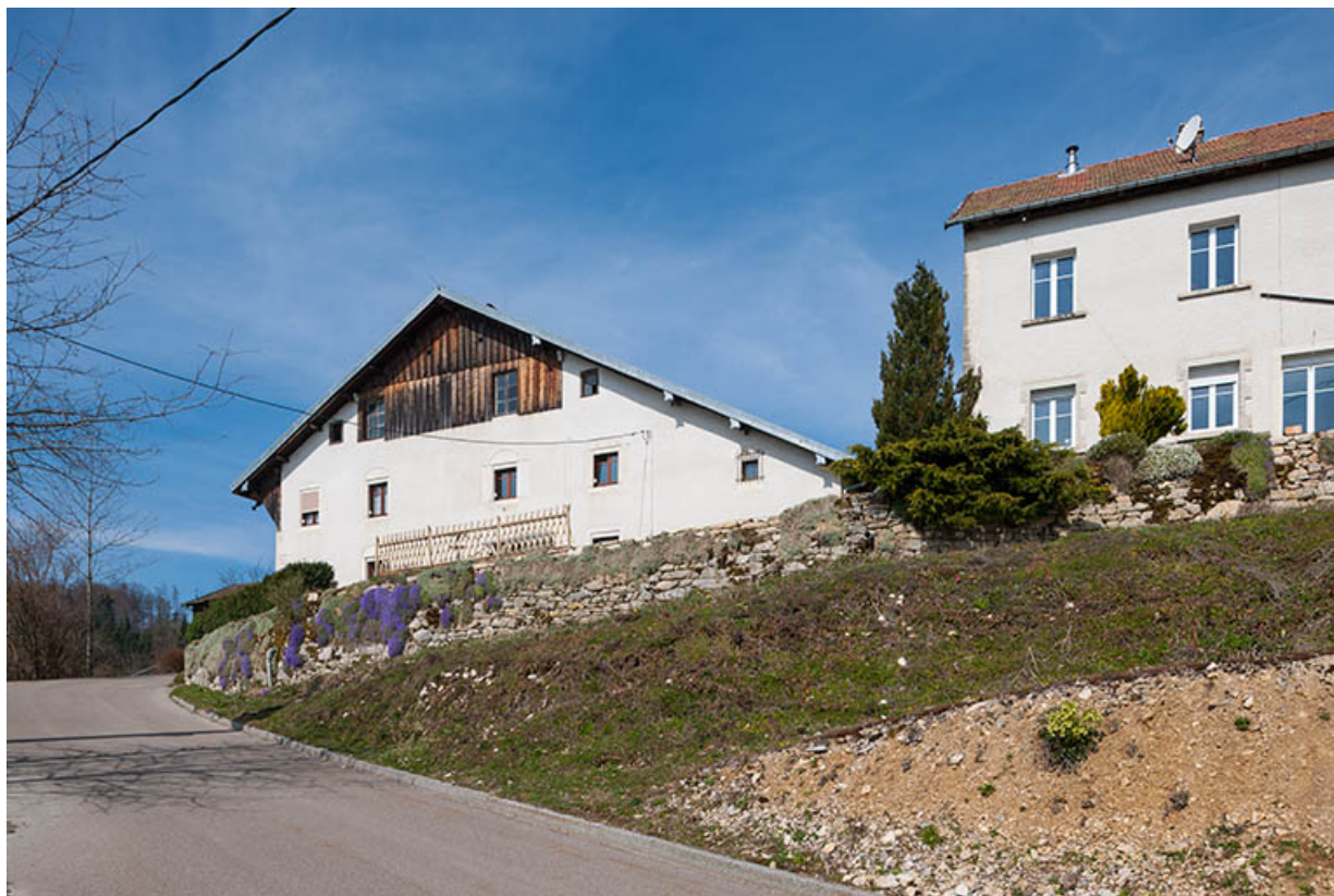
Ferme et atelier de fabrication, depuis l'est. 25, Charmauvillers, lieudit : le Seud
