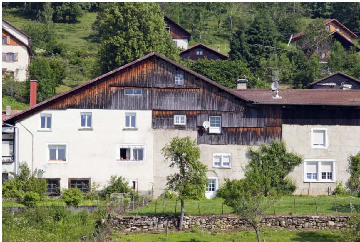
Façade latérale droite (vue rapprochée).
