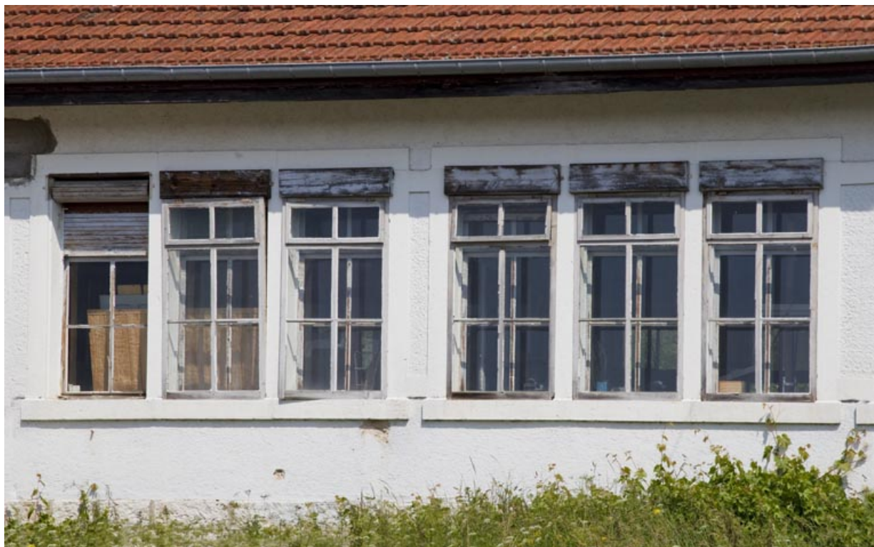
Détail des fenêtres de l'atelier.
