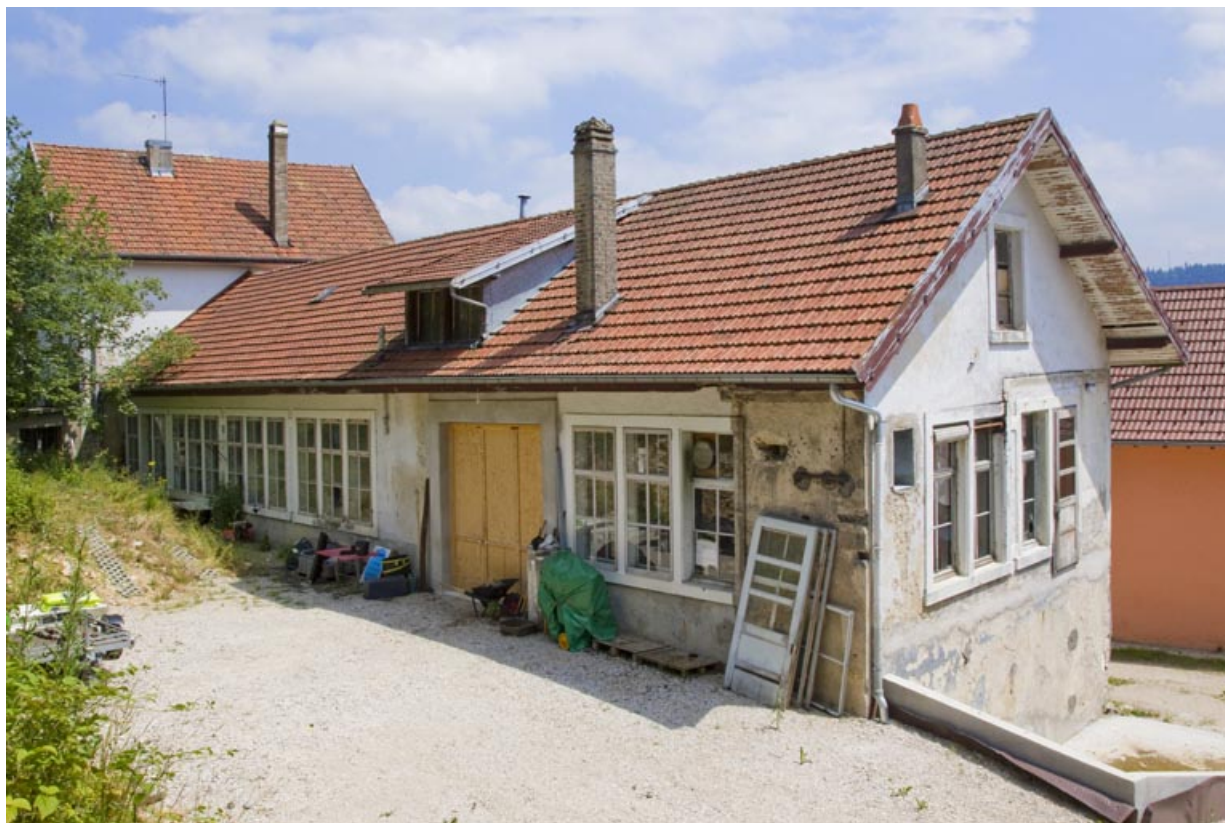
Façades postérieure et latérale gauche.
