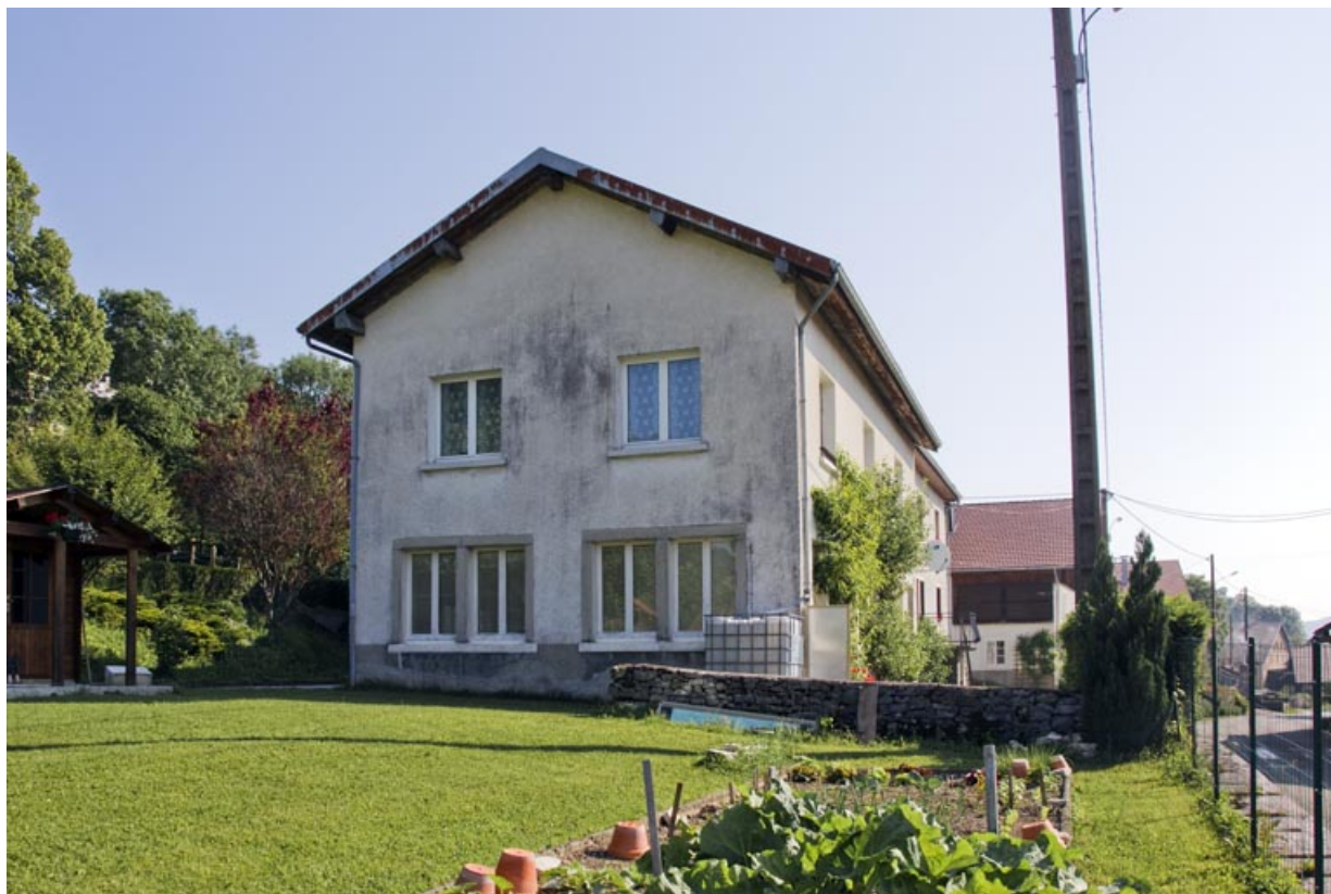
Façade latérale gauche de l'atelier.
