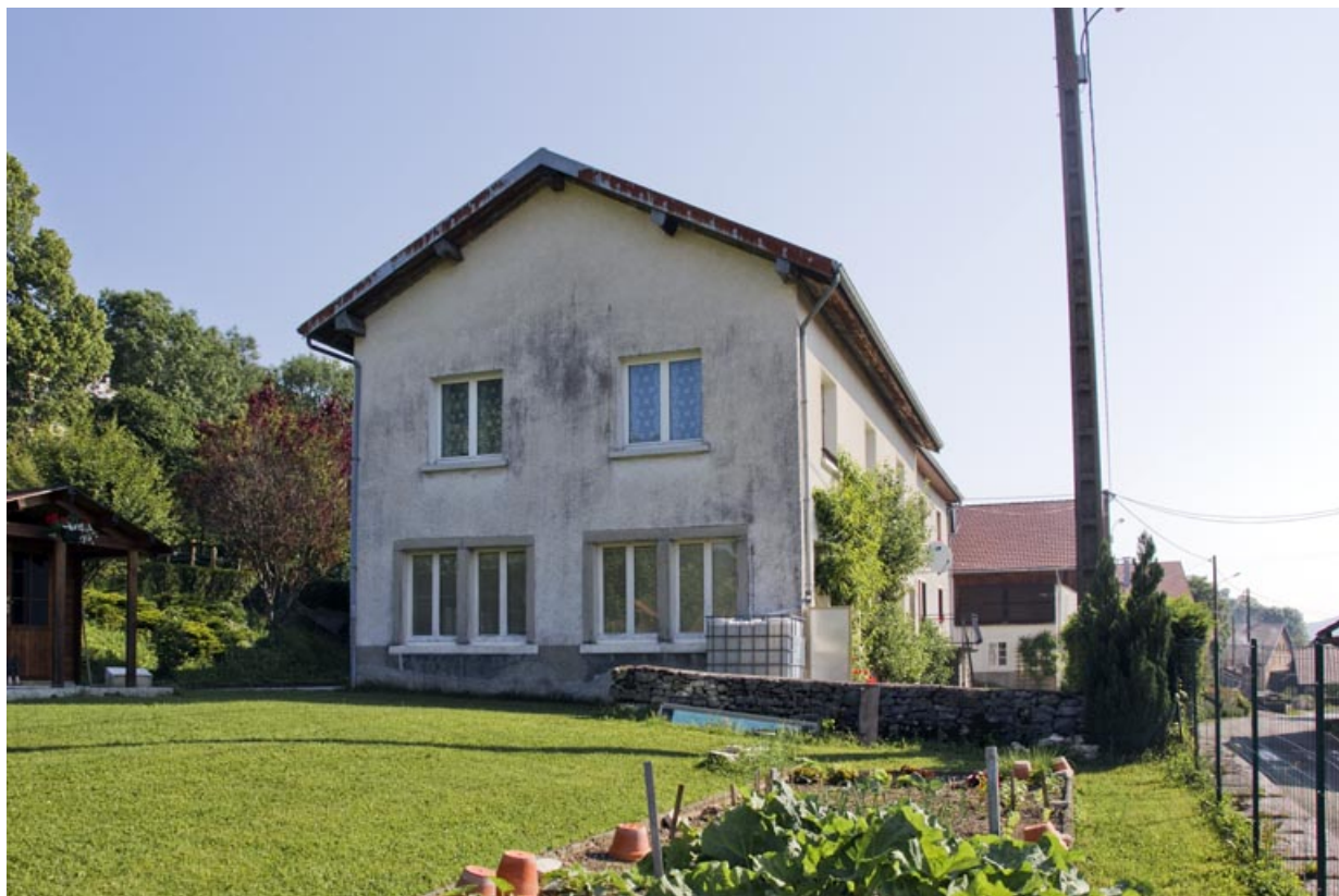
Façade latérale gauche de l'atelier.
