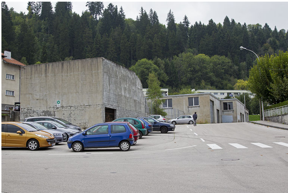
Site ancien : atelier de fabrication plastique désaffecté, rue du Tremplin. 25, Morteau, 13 rue du Maréchal Leclerc
