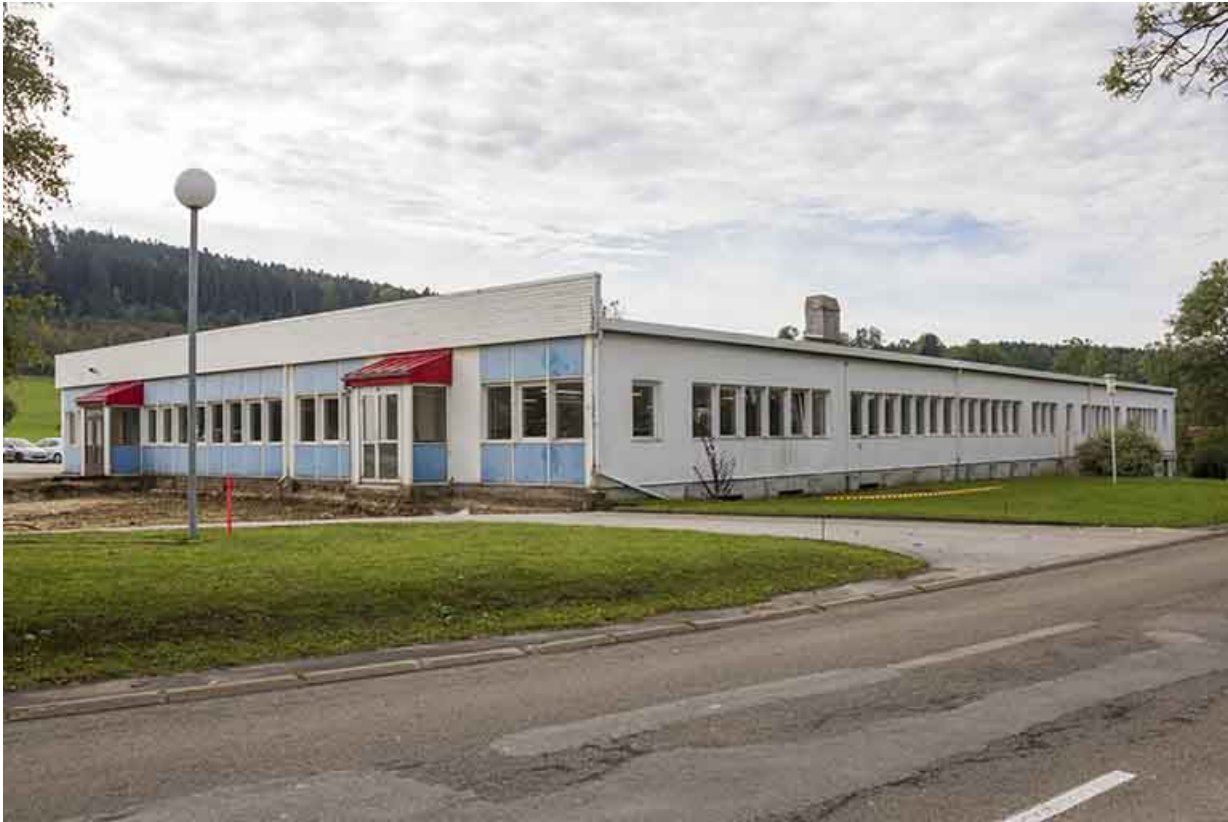
Vue d'ensemble depuis le nord, avant l'extension de 2013.
