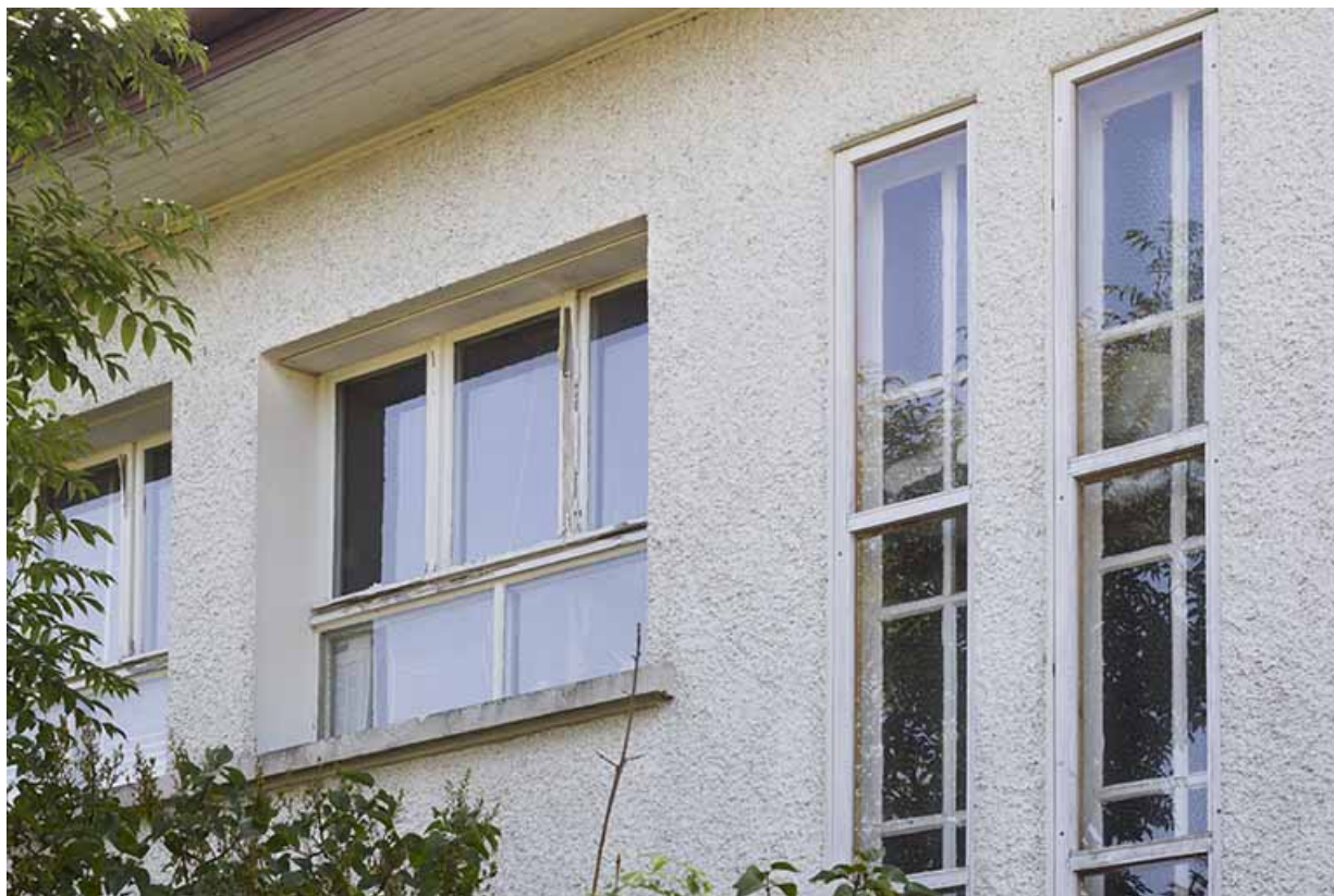
Atelier de fabrication : baies sur la façade postérieure.
