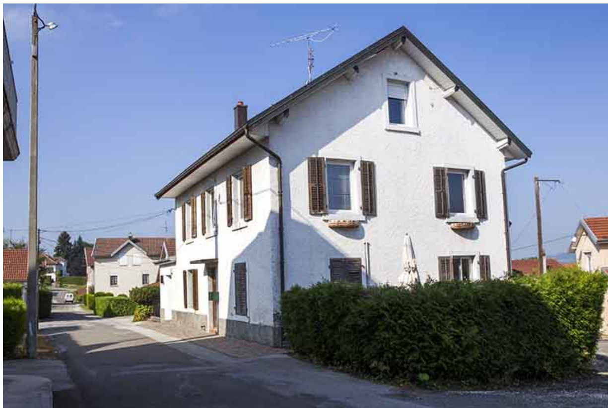
Logement patronal : façades antérieure et latérale droite.
