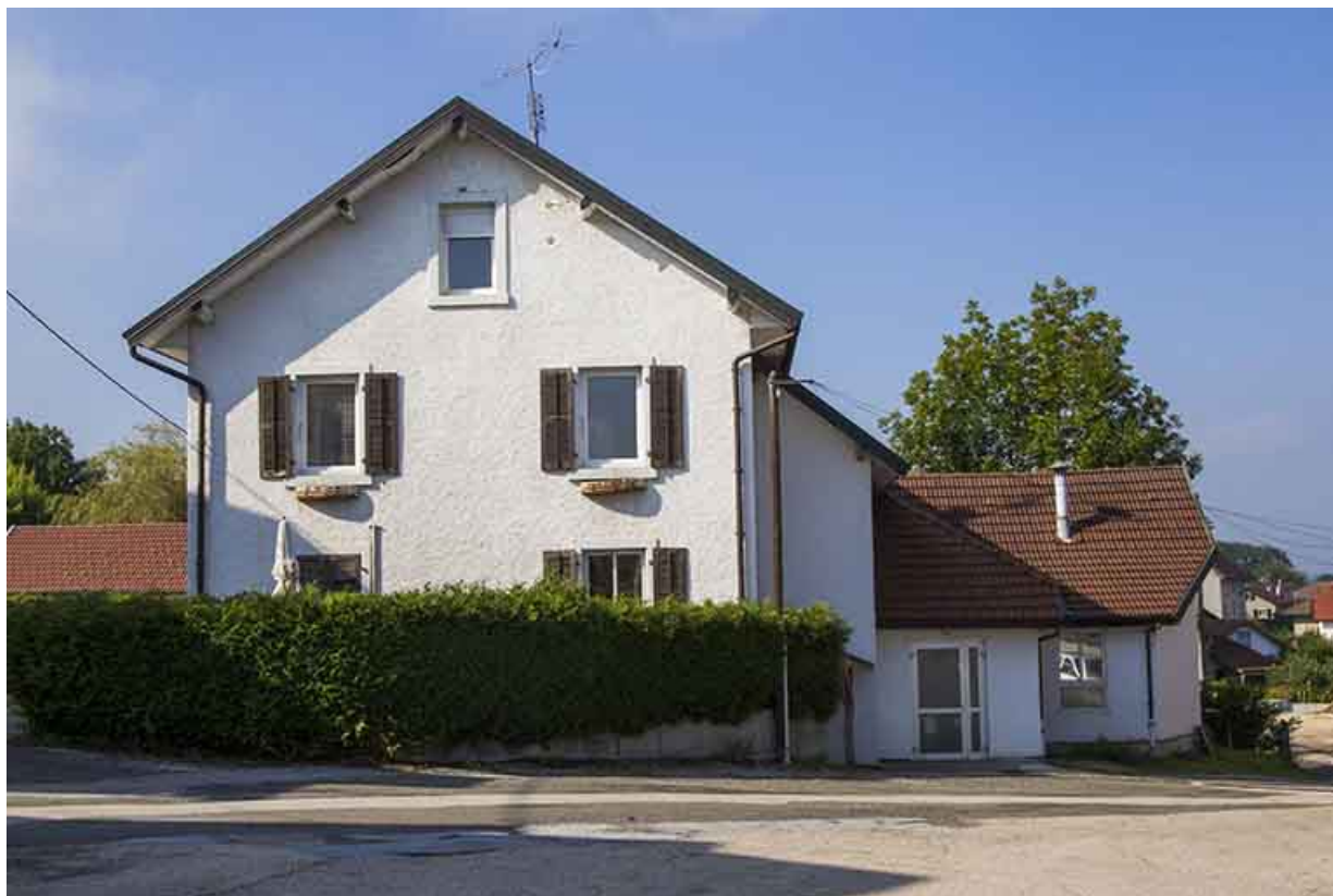
Logement patronal : façade latérale droite.
