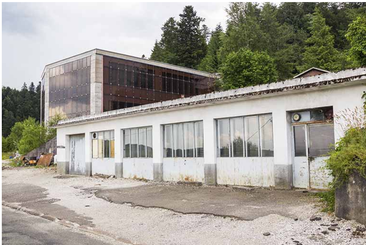
Atelier de fabrication du milieu des années 1990, depuis la rue des Clos Magnin. 25, Damprichard, 1 rue des Clos Magnin
