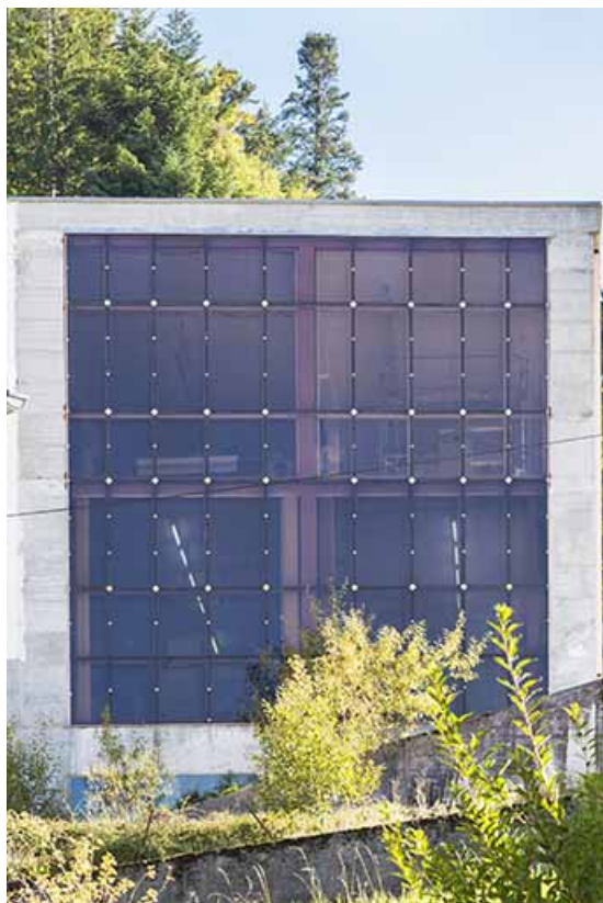
Pan de verre de l'atelier de fabrication du milieu des années 1990. 25, Damprichard, 1 rue des Clos Magnin
