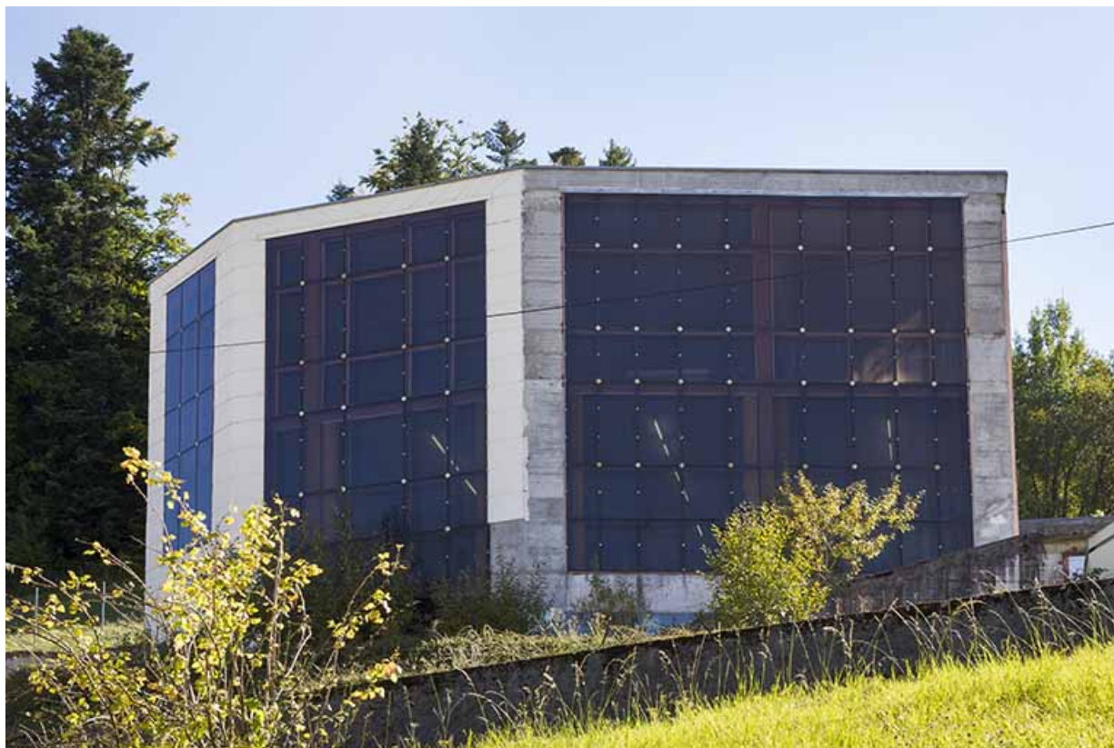
Atelier de fabrication du milieu des années 1990.
