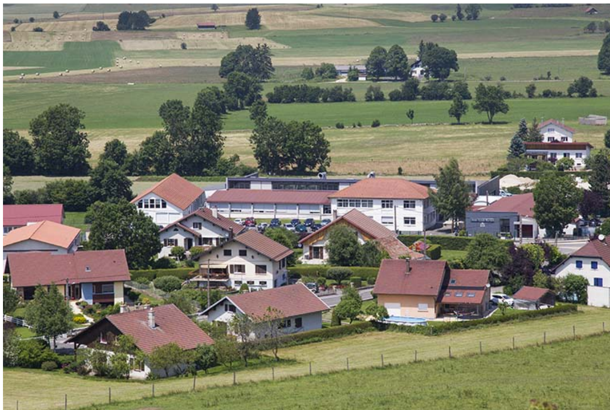
Vue d'ensemble plongeante, depuis le sud-est.
