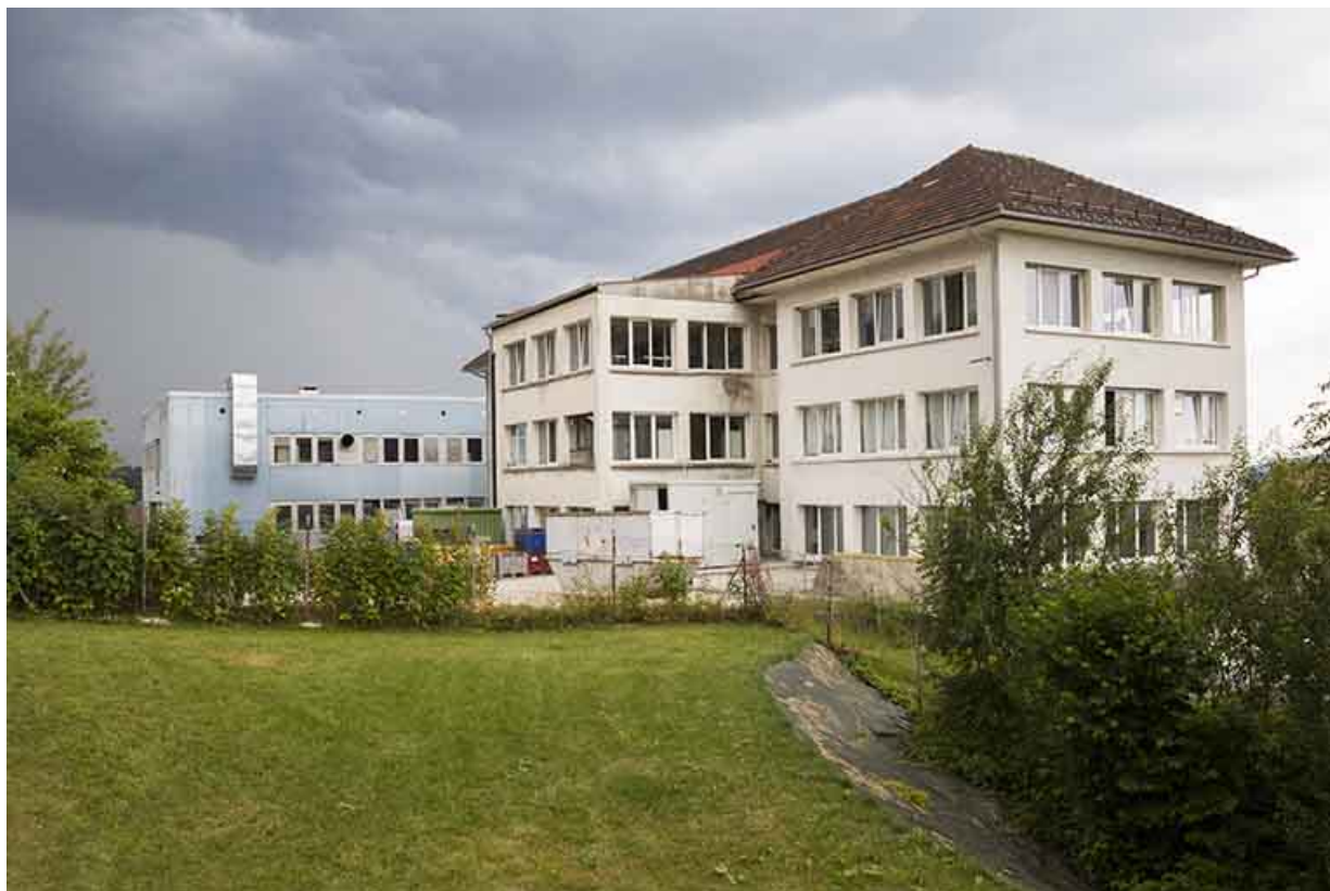
Ateliers de 1952 et 1970-1971 : façades postérieure et latérale gauche.
