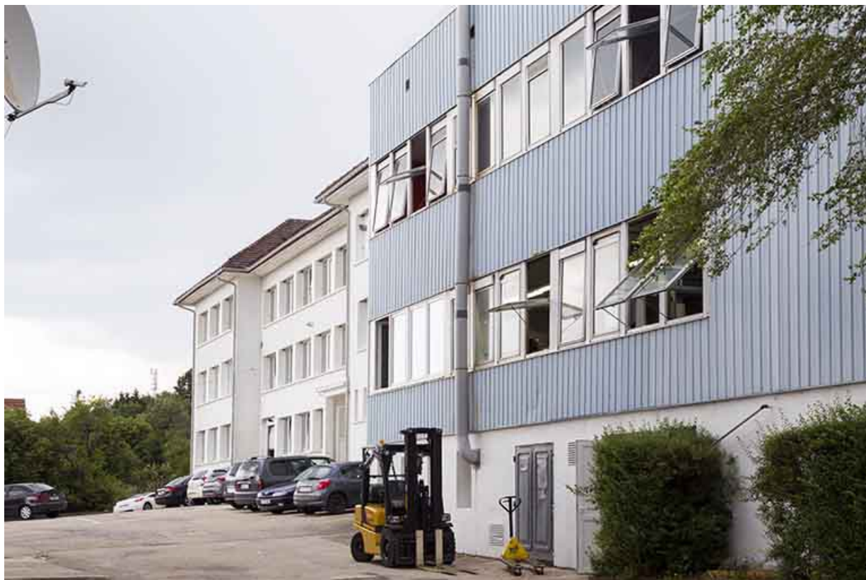
Ateliers de 1952 et 1970-1971, vus de l'entrée. 25, Damprichard, 21-25 rue du Maréchal Leclerc
