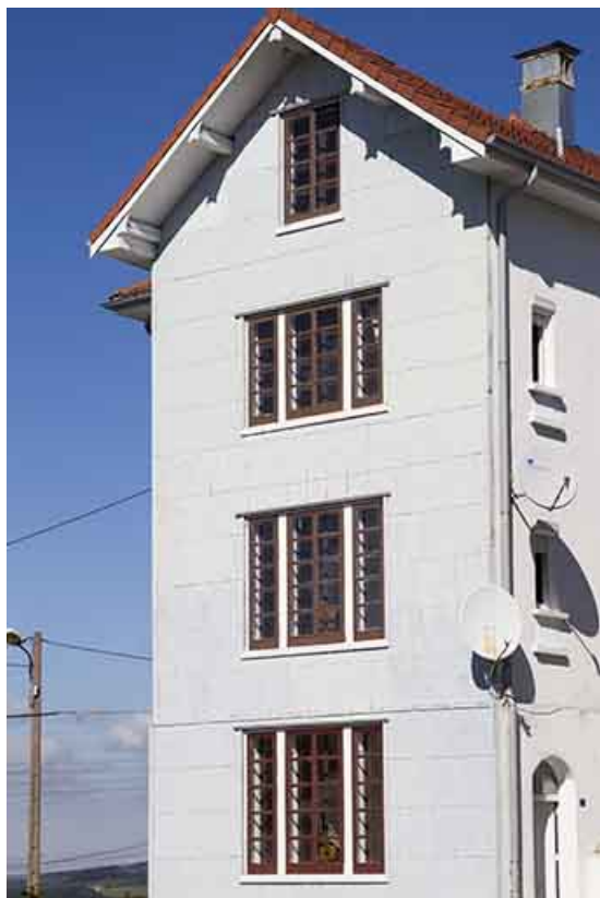
Atelier de 1948 : baies du mur pignon oriental. 25, Damprichard, 21-25 rue du Maréchal Leclerc
