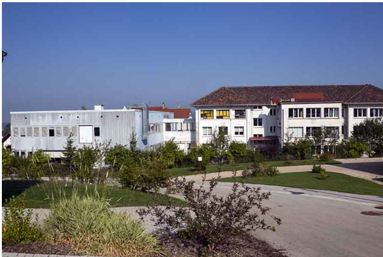
Vue d'ensemble, depuis l'est (atelier de 1952 à droite, extension de 1970-1971 à gauche). 25, Damprichard, 21-25 rue du Maréchal Leclerc
