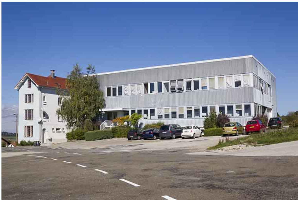
Vue d'ensemble, depuis le sud (atelier de 1948 à gauche, extension de 1970-1971 à droite). 25, Damprichard, 21-25 rue du Maréchal Leclerc
