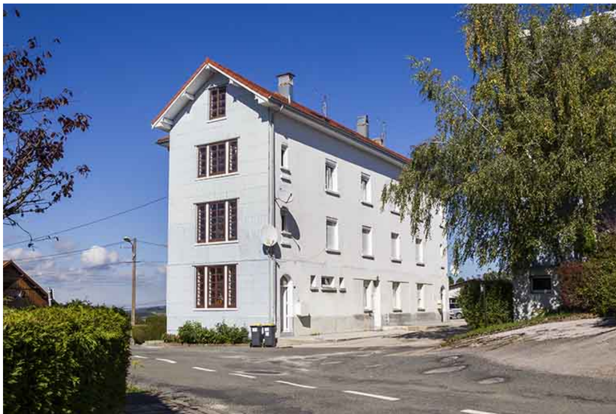
Atelier de 1948 : façade antérieure de trois quarts gauche.
