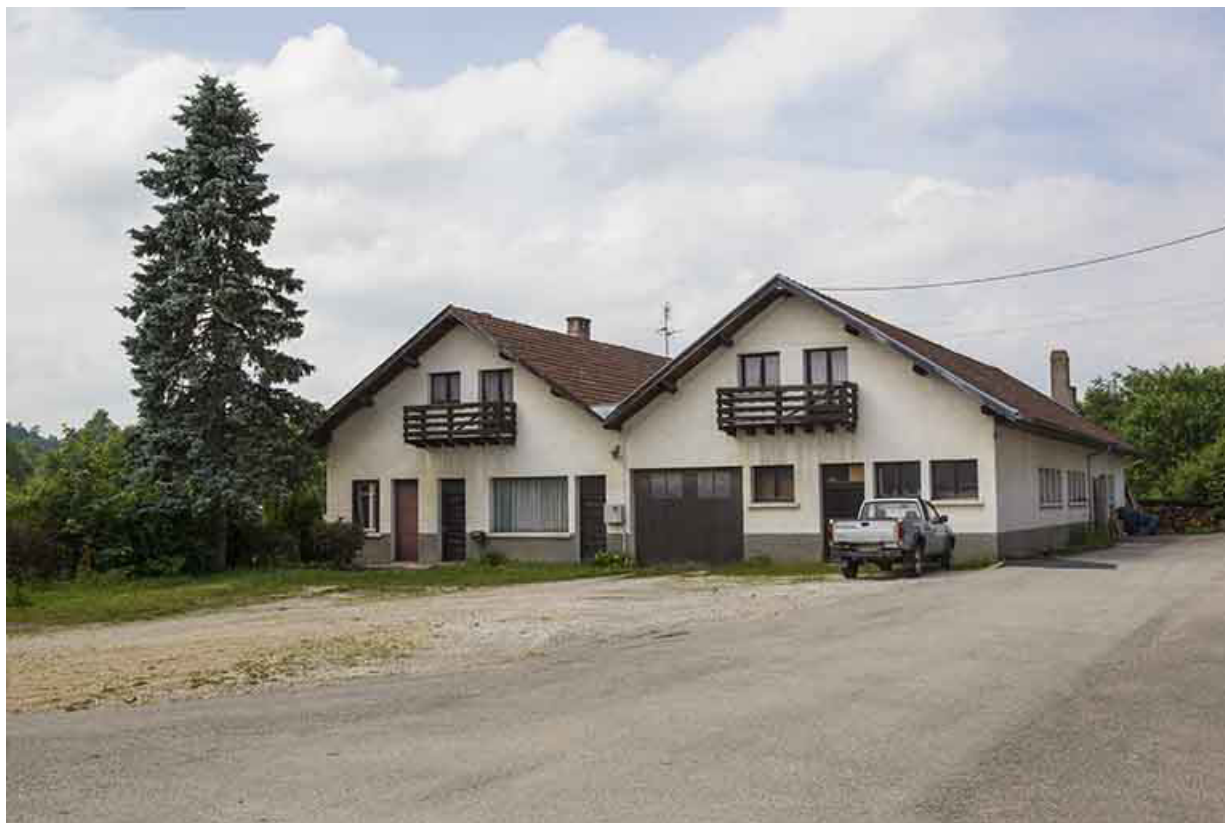
Vue d'ensemble, depuis la rue du Stade à l'est (façades antérieure et latérale droite). 25, Damprichard, 13-15 rue du Stade
