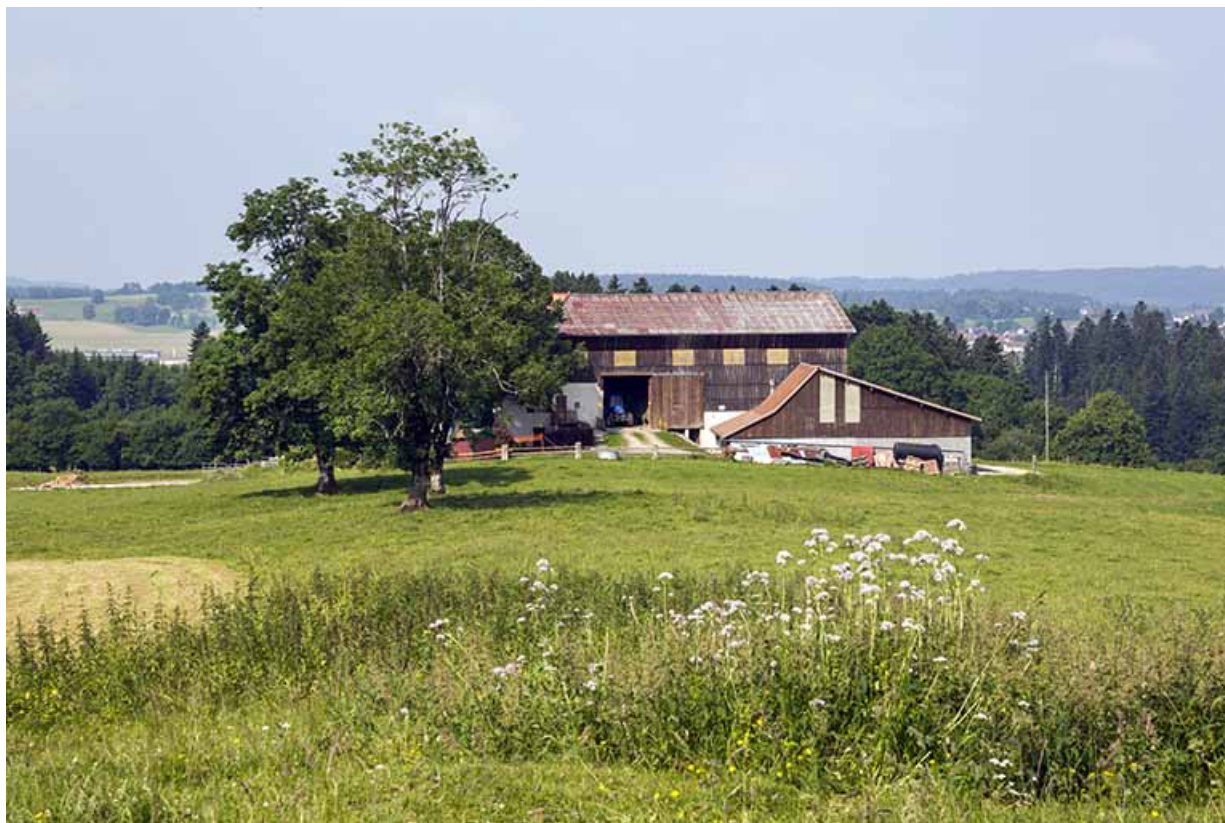
Vue d'ensemble rapprochée, depuis l'est. 25, Damprichard, lieudit : Combe Bourgeois
