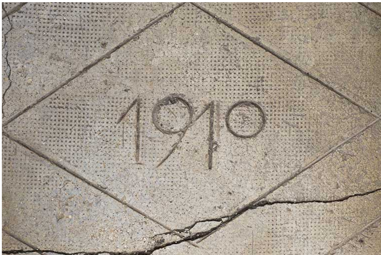
Logement patronal : date 1910 inscrite sur la dalle en béton de l'entrée.
