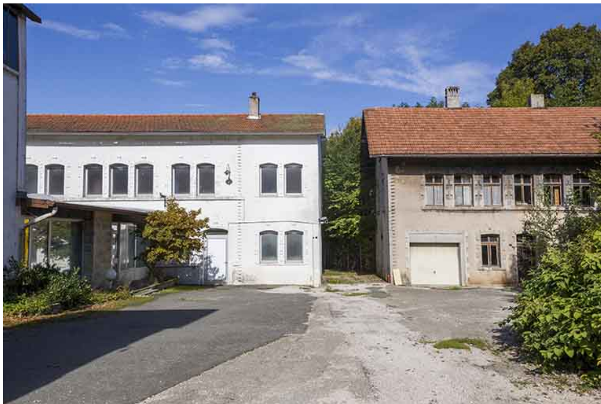
Ateliers de fabrication (bâtiments Bourgeois d'origine). Celui de droite abritait l'usine de boîtes de montre et de traitement de surface des métaux d'Étienne Bourgeois.
