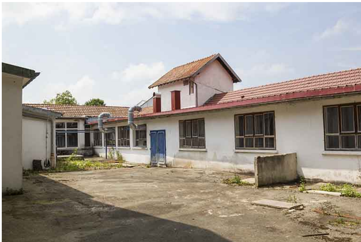
Cour et ateliers au nord du bâtiment Bourgeois.
