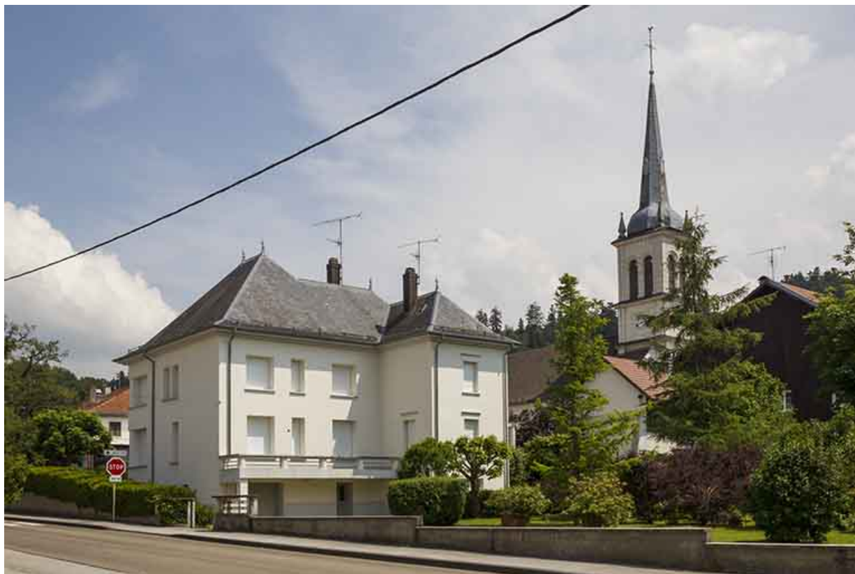
Logement patronal depuis l'ouest (façade postérieure).
