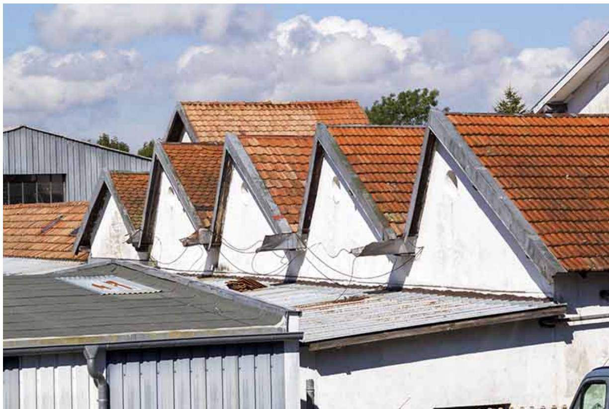
Toits en shed de l'atelier de fabrication à l'ouest du bâtiment Bourgeois.
