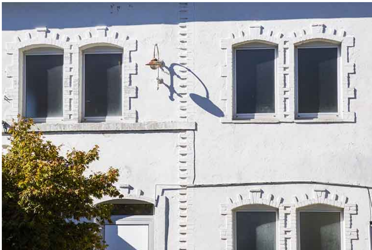
Atelier de fabrication d'origine (bâtiment Bourgeois) : détail des baies.
