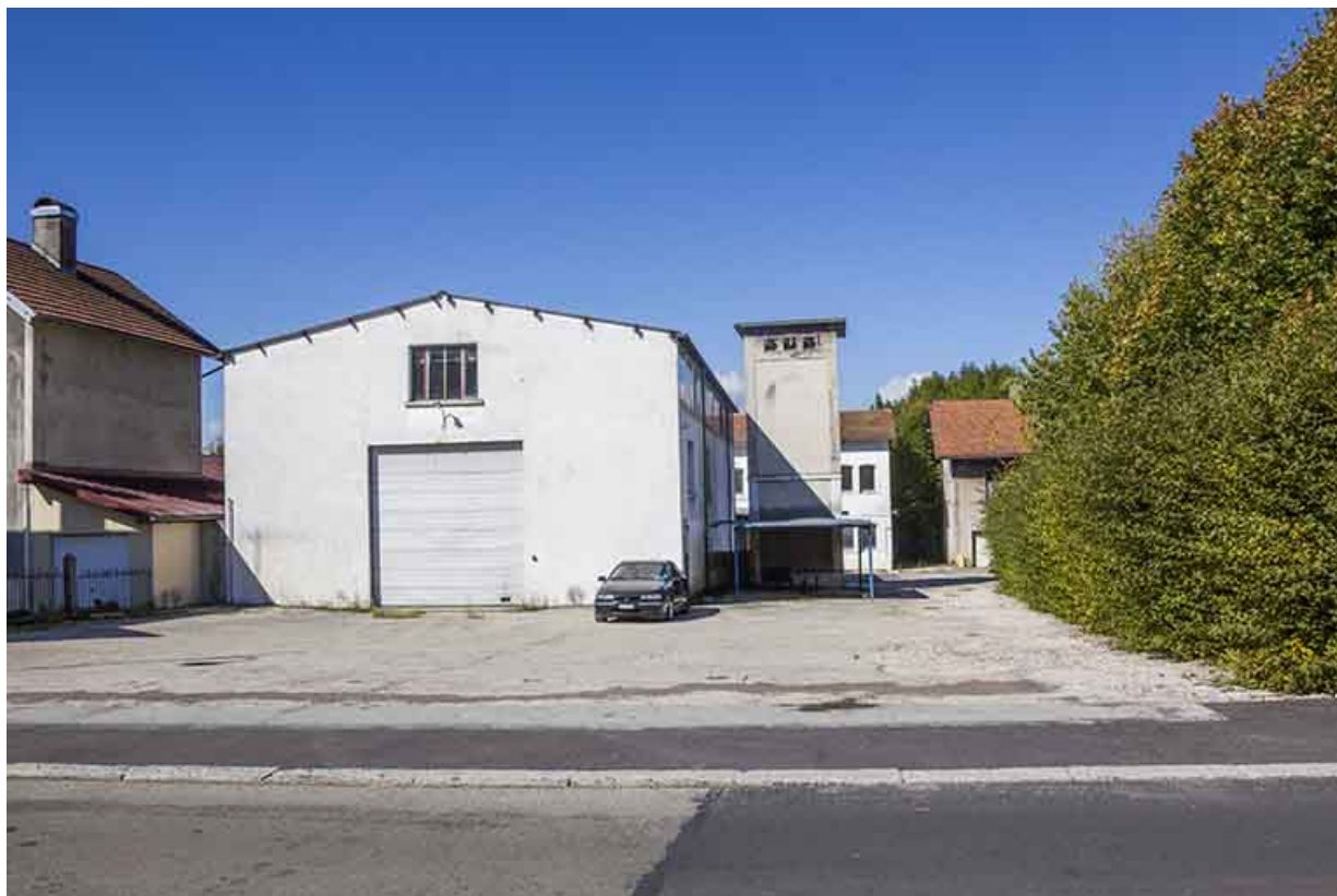
Vue d'ensemble de l'usine, depuis la rue du Professeur Grammont.
