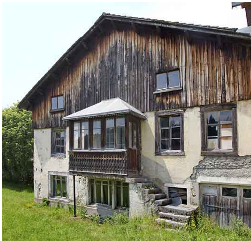
Logement d'ouvriers : façade antérieure.
