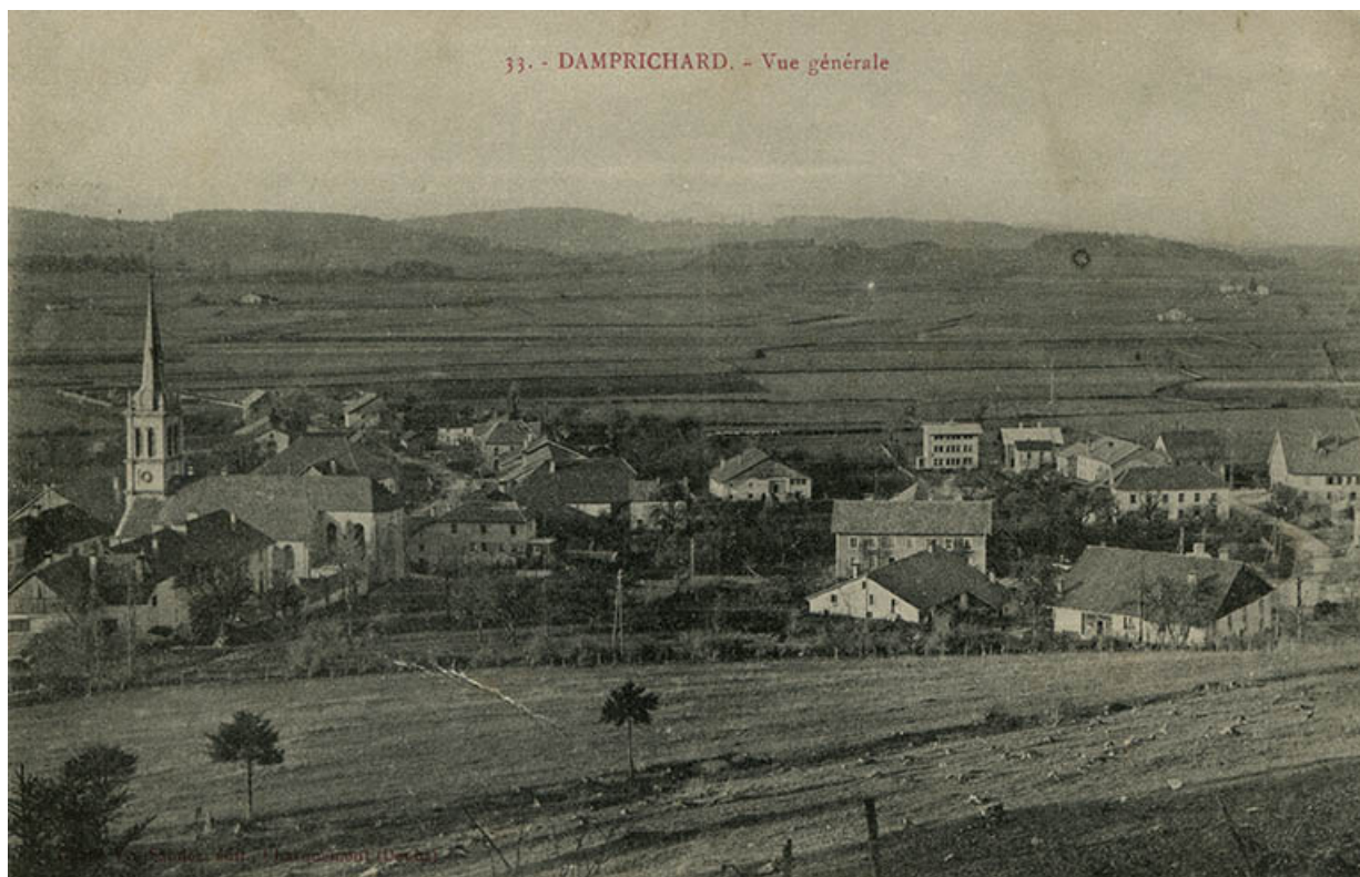
33. - Damprichard. - Vue générale [depuis le sud-est], limite 19e siècle 20e siècle (entre 1895 et 1901 ?). L'usine Bourgeois est visible à droite.
