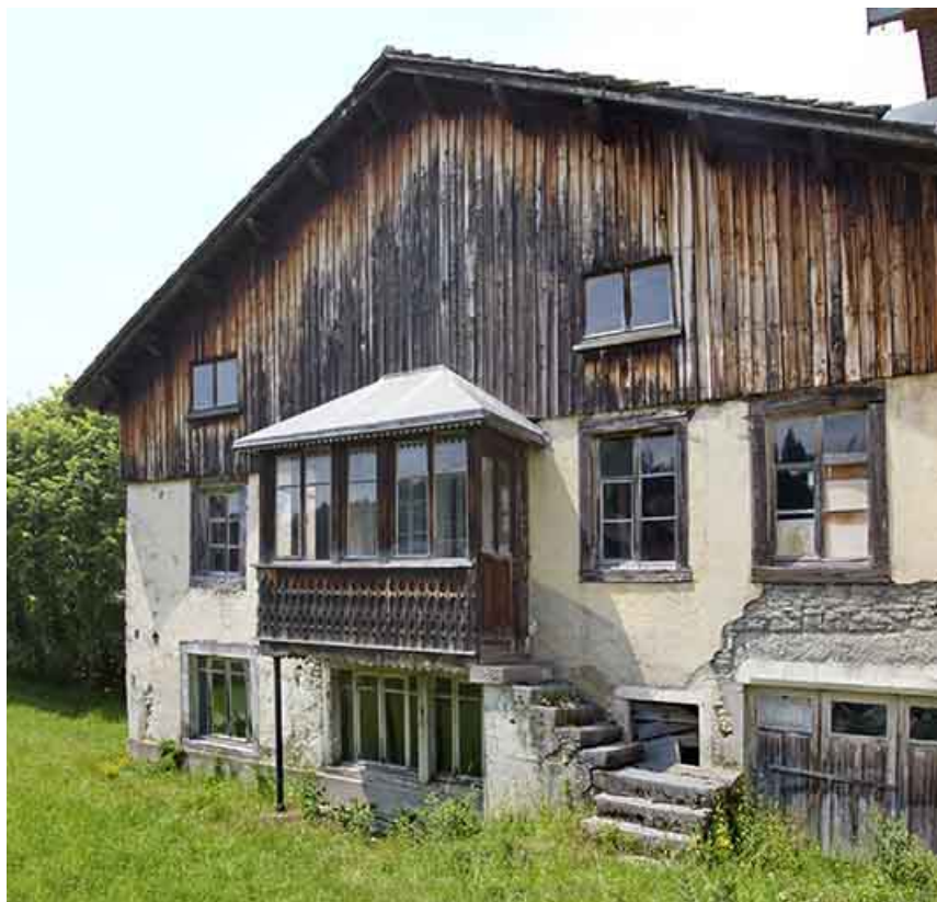
Logement d'ouvriers : façade antérieure.
