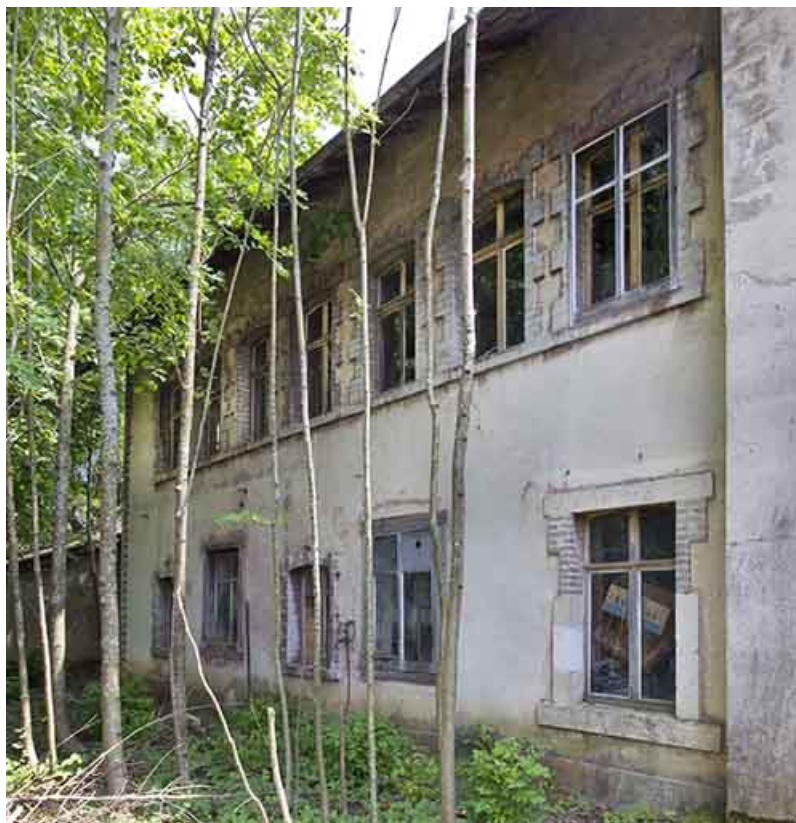
Atelier de fabrication occidental : façade postérieure.
