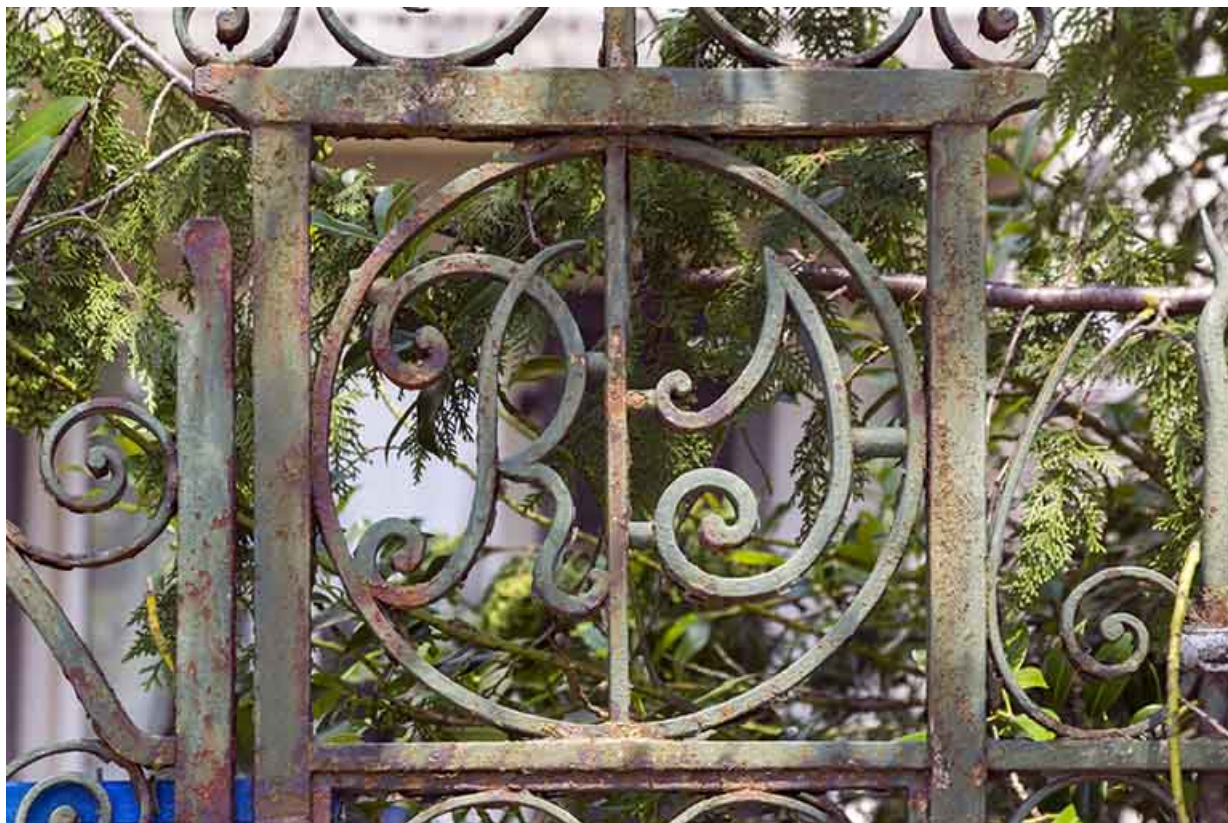
Logement patronal : initiales RS (Roch Stéphanie) à droite de la grille de clôture. 25, Damprichard, 11 rue du Professeur Grammont
