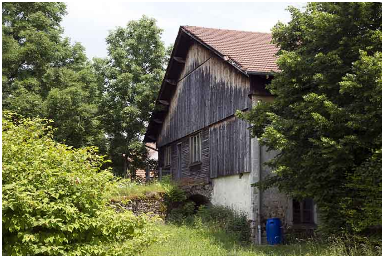
Logement d'ouvriers : façade postérieure et pont de grange.
