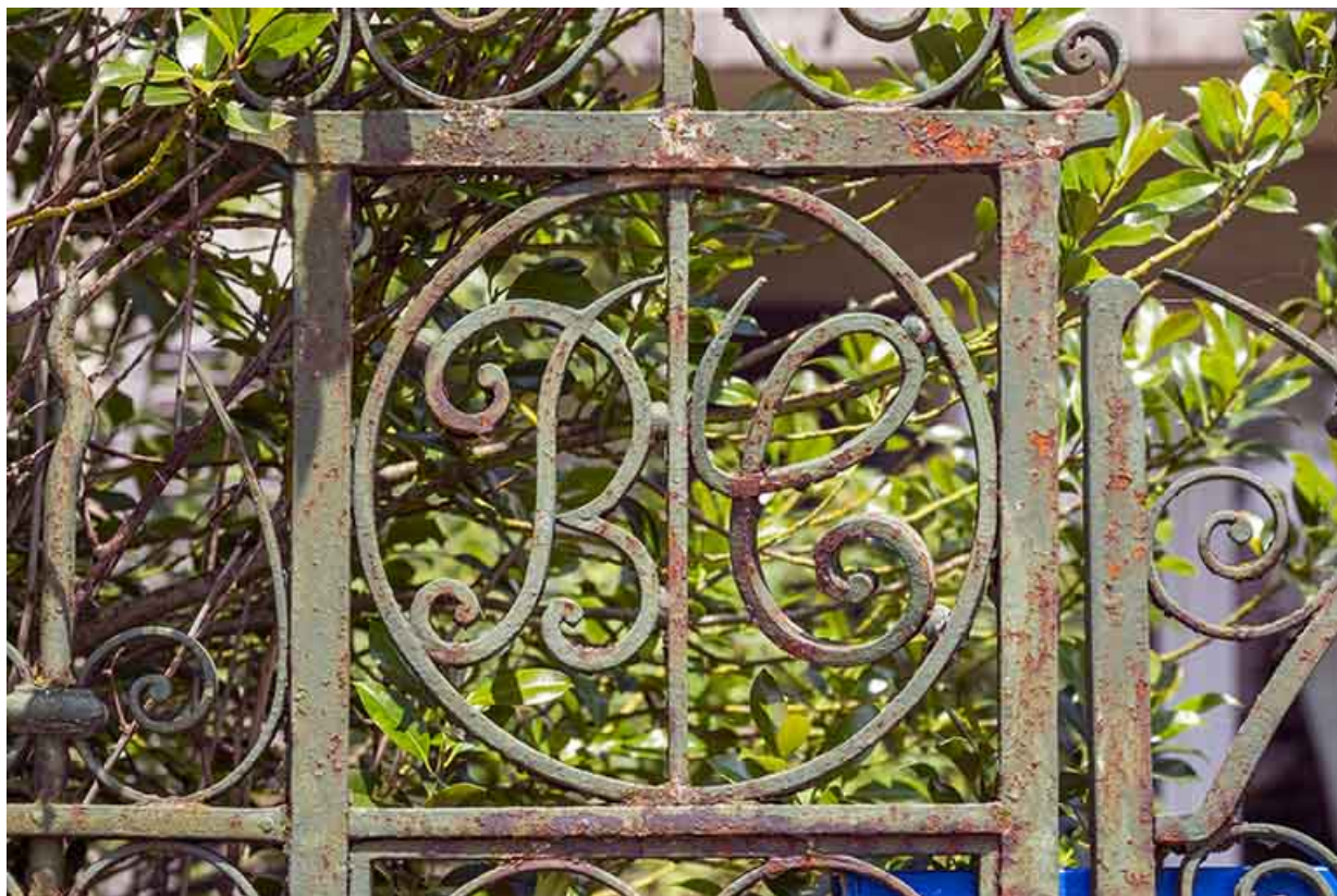
Logement patronal : initiales BC (Bourgeois Césaire) à gauche de la grille de clôture. 25, Damprichard, 11 rue du Professeur Grammont
