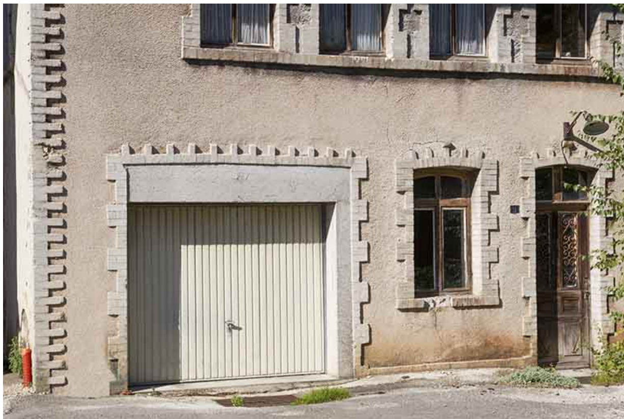
Atelier de fabrication occidental : baies au rez-de-chaussée de la façade antérieure.
