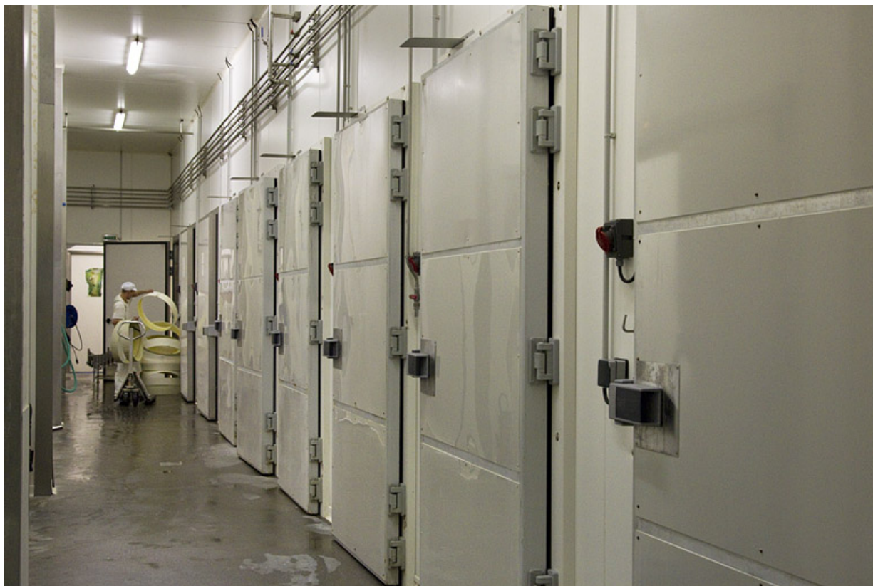
Fabrication du comté : couloir desservant les caves d'affinage.
