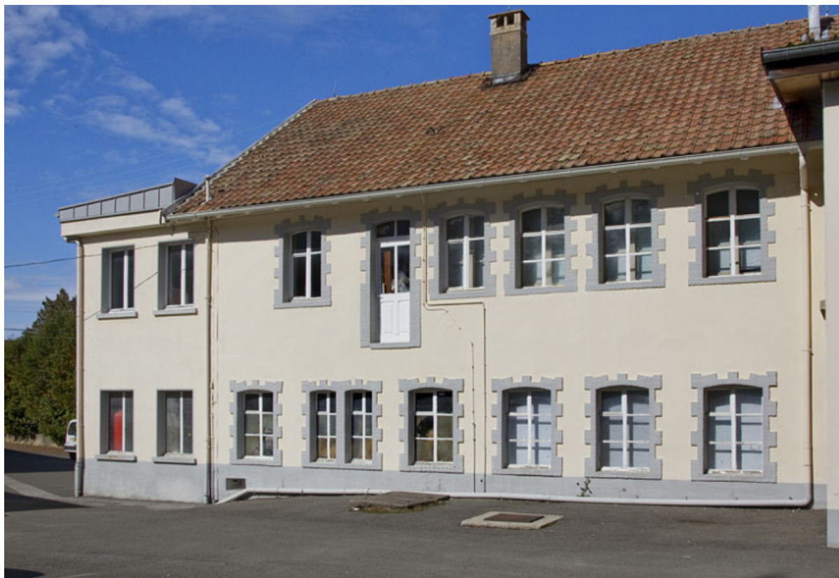
Atelier rehaussé en 1923-1924 : façade latérale droite. 25, Damprichard, 1 rue de l' Industrie
