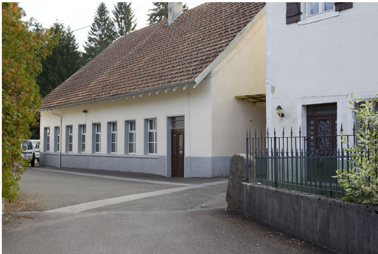
Atelier de 1888, côté cour, de trois quarts droite. 25, Damprichard, 1 rue de l' Industrie
