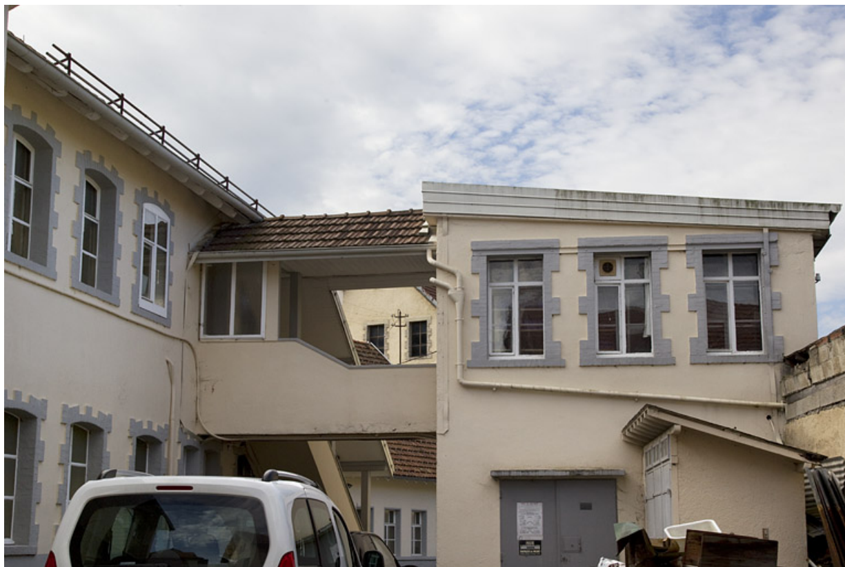
Passerelle reliant l'atelier de 1912 et celui rehaussé en 1923-1924 : façade postérieure. 25, Damprichard, 1 rue de l' Industrie
