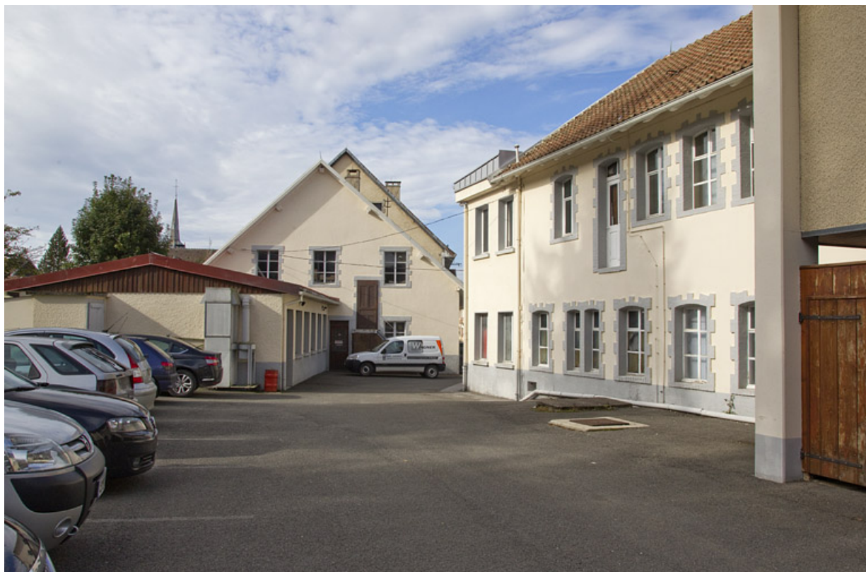
Atelier rehaussé en 1923-1924, depuis le fond de la cour. 25, Damprichard, 1 rue de l' Industrie
