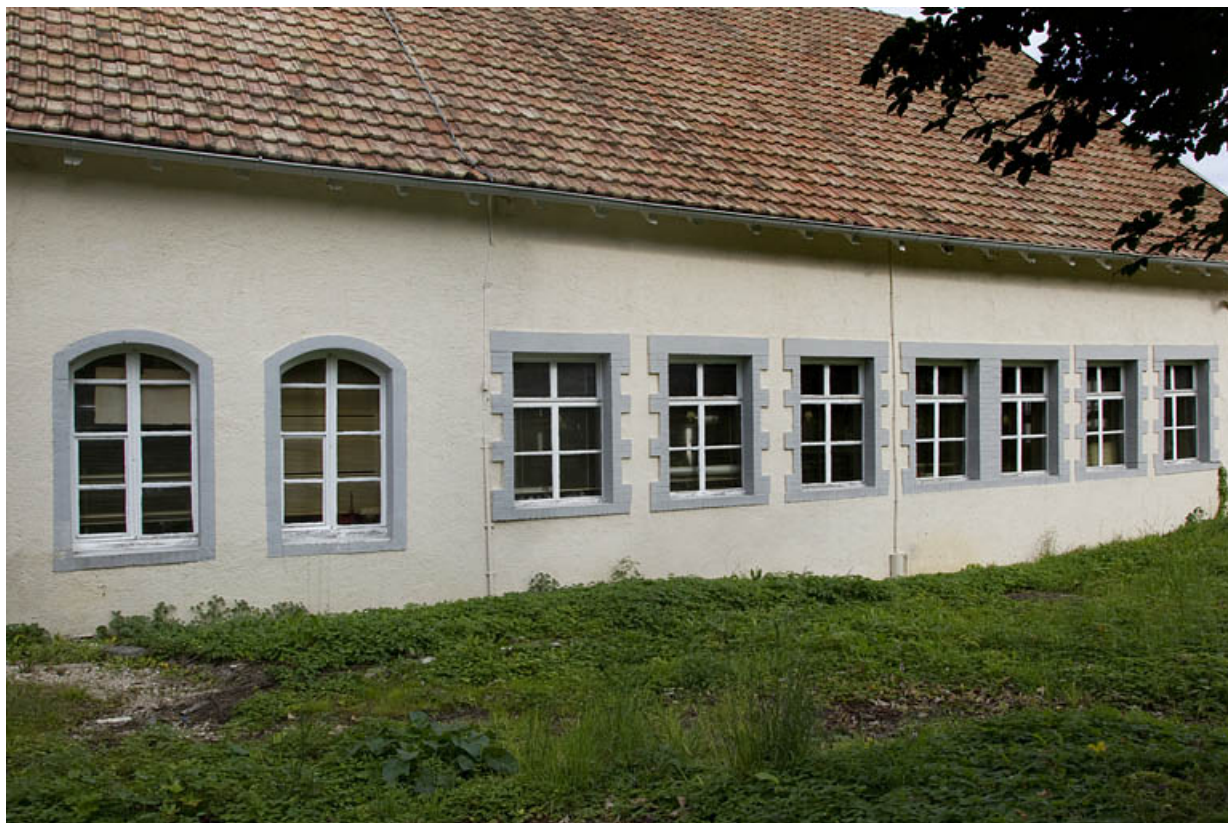
Atelier de 1888, côté pré : détail des fenêtres.
