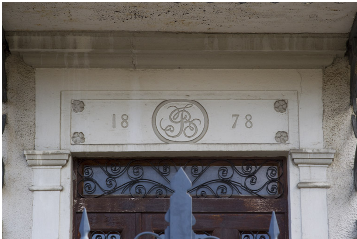
Logement patronal : linteau de la porte d'entrée.
