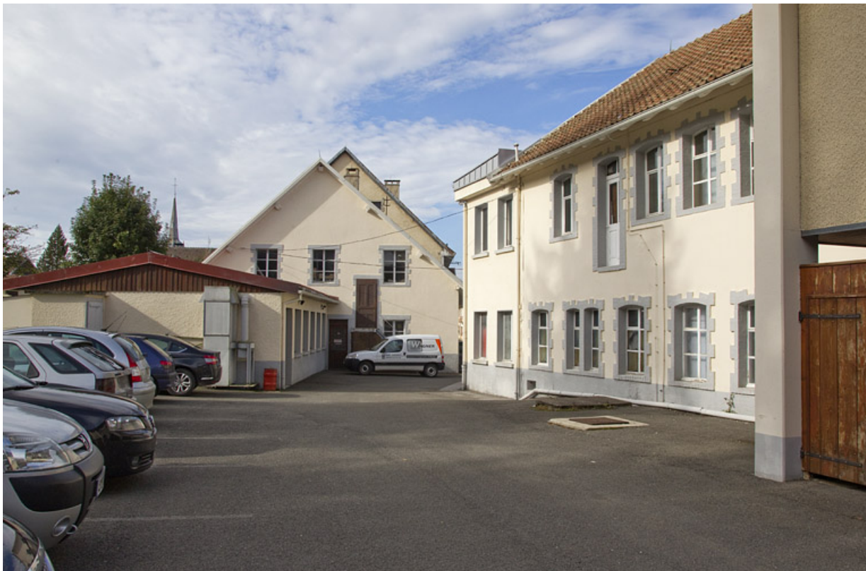
Atelier rehaussé en 1923-1924, depuis le fond de la cour. 25, Damprichard, 1 rue de l' Industrie
