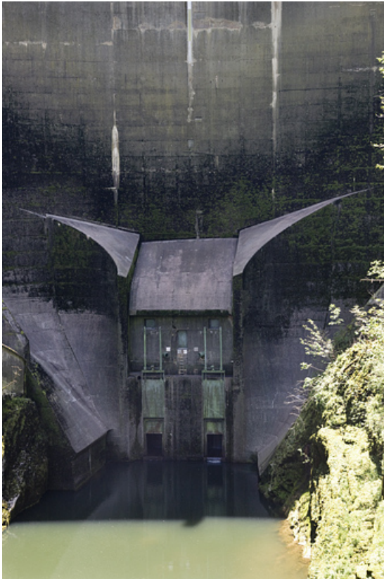
Barrage du Châtelot : vannes de fond.
