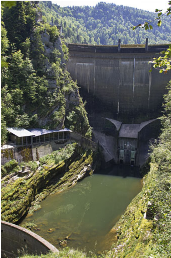
Barrage du Châtelot : le bassin d'amortissement.
