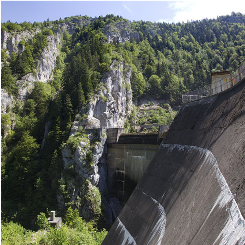
Barrage du Châtelot : ancrage rive droite.
