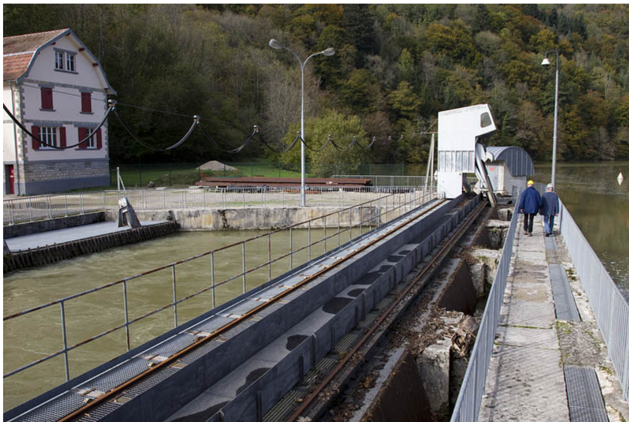
Prise d'eau : grilles de protection du bassin et passerelle.
