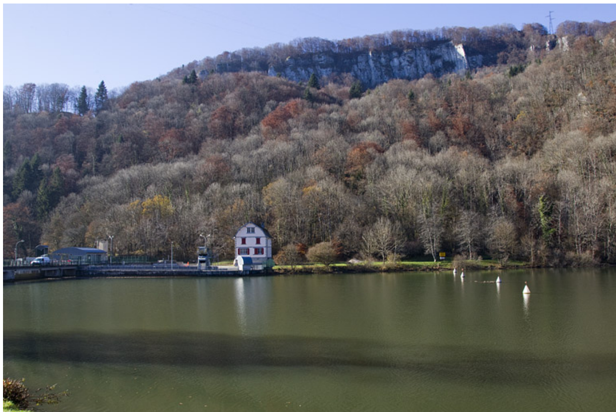
Bassin de retenue depuis la rive gauche, avec la prise d'eau et le logement du garde.
