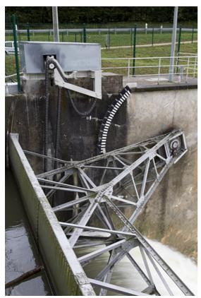
Barrage : système d'ouverture d'une vanne secteur (vanne évacuateur de crue).
