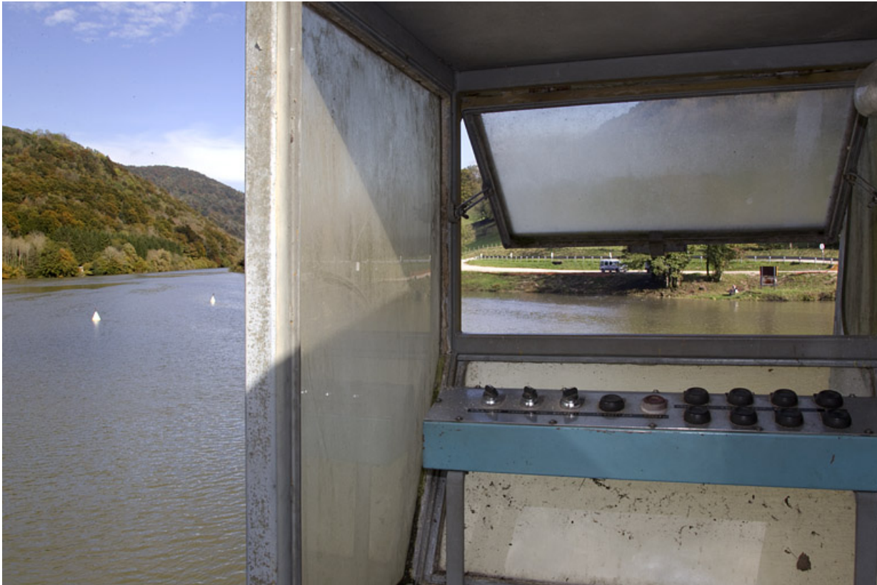
Prise d'eau : poste de commande du dégrilleur.
