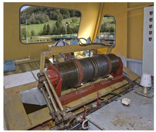
Prise d'eau : treuil actionnant le bras du dégrilleur.
