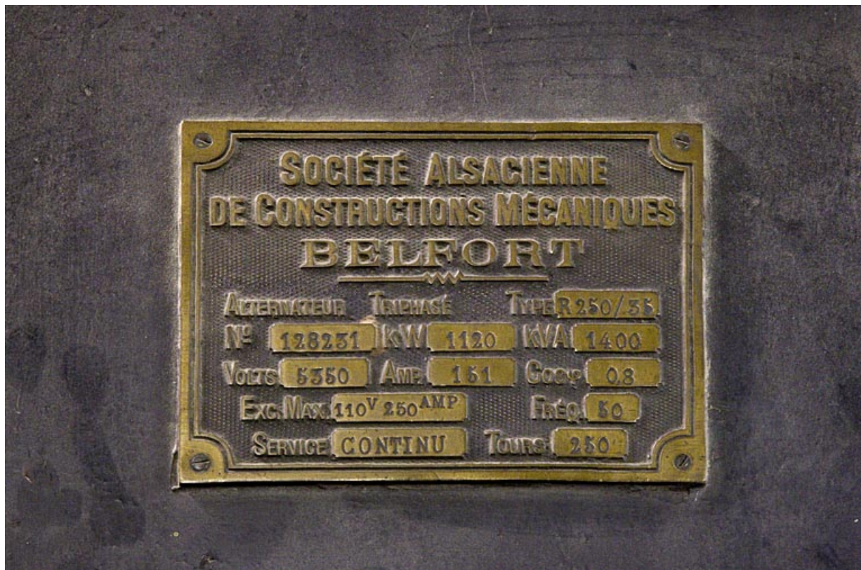
Centrale : plaque signalétique de l'alternateur.
