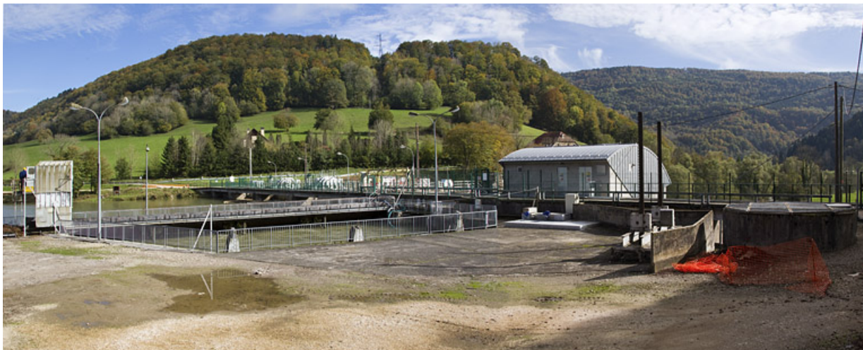
Vue d'ensemble depuis le nord-ouest (amont rive droite).
