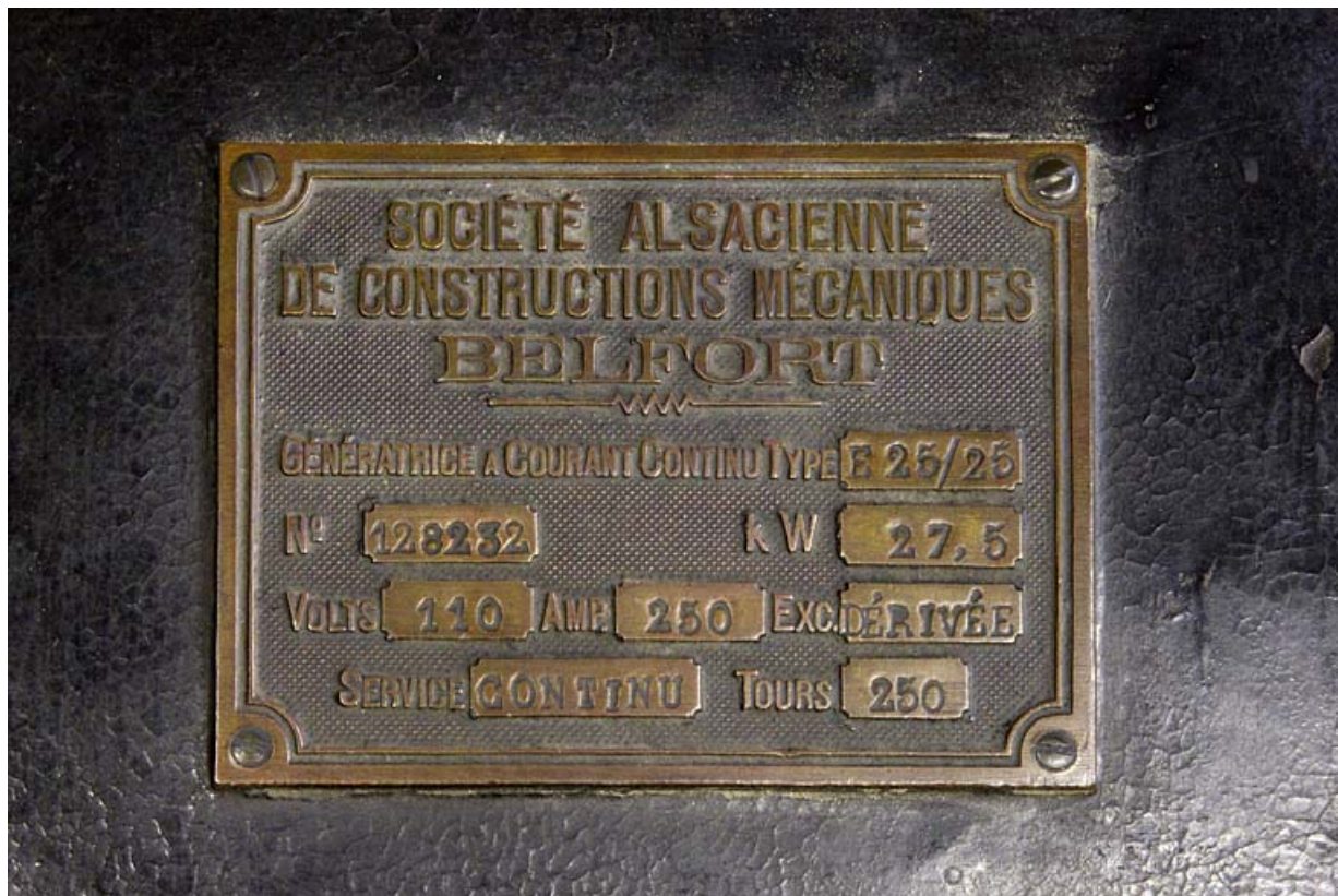
Centrale : plaque signalétique de l'excitatrice.
