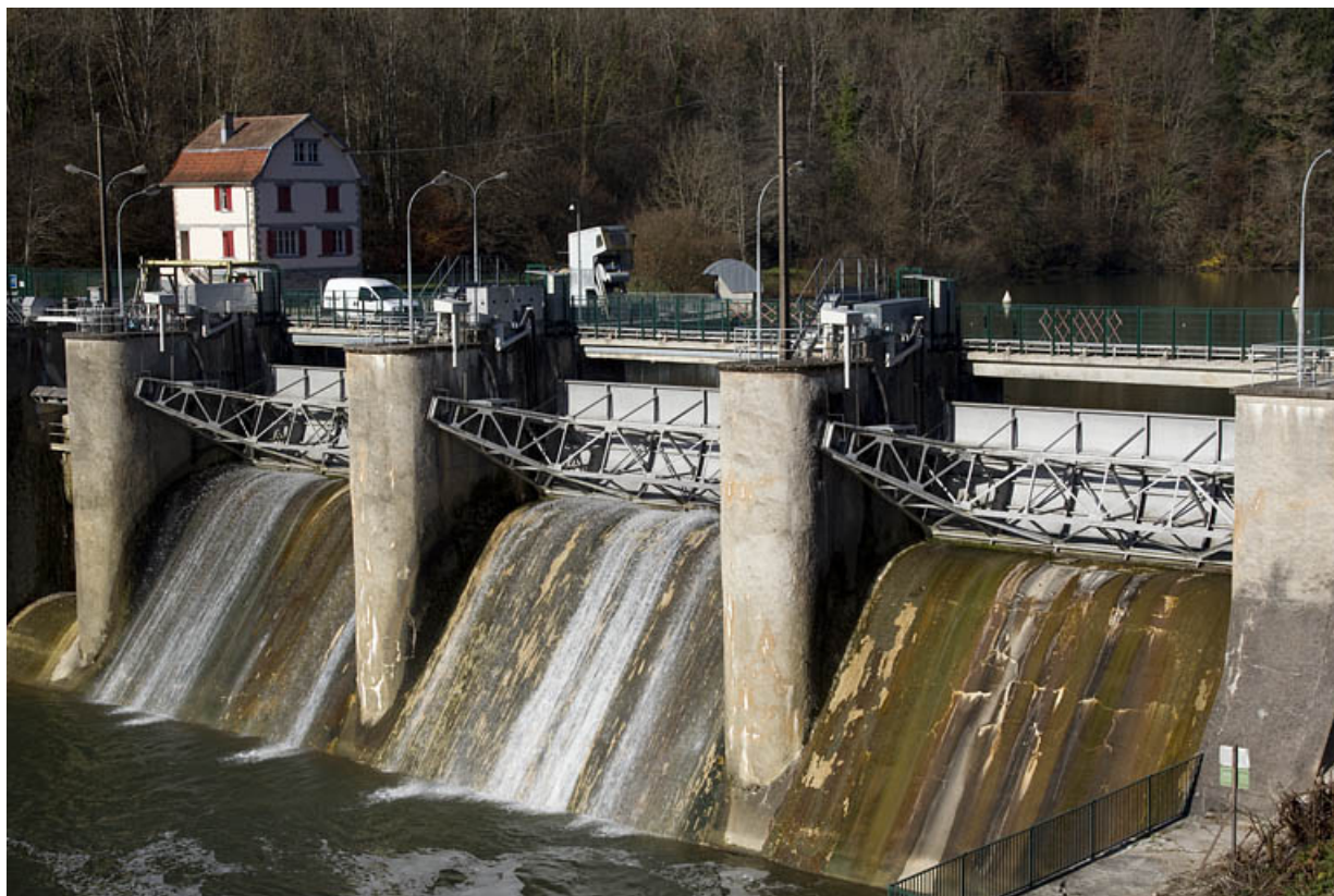
Barrage depuis la rive gauche en aval.
