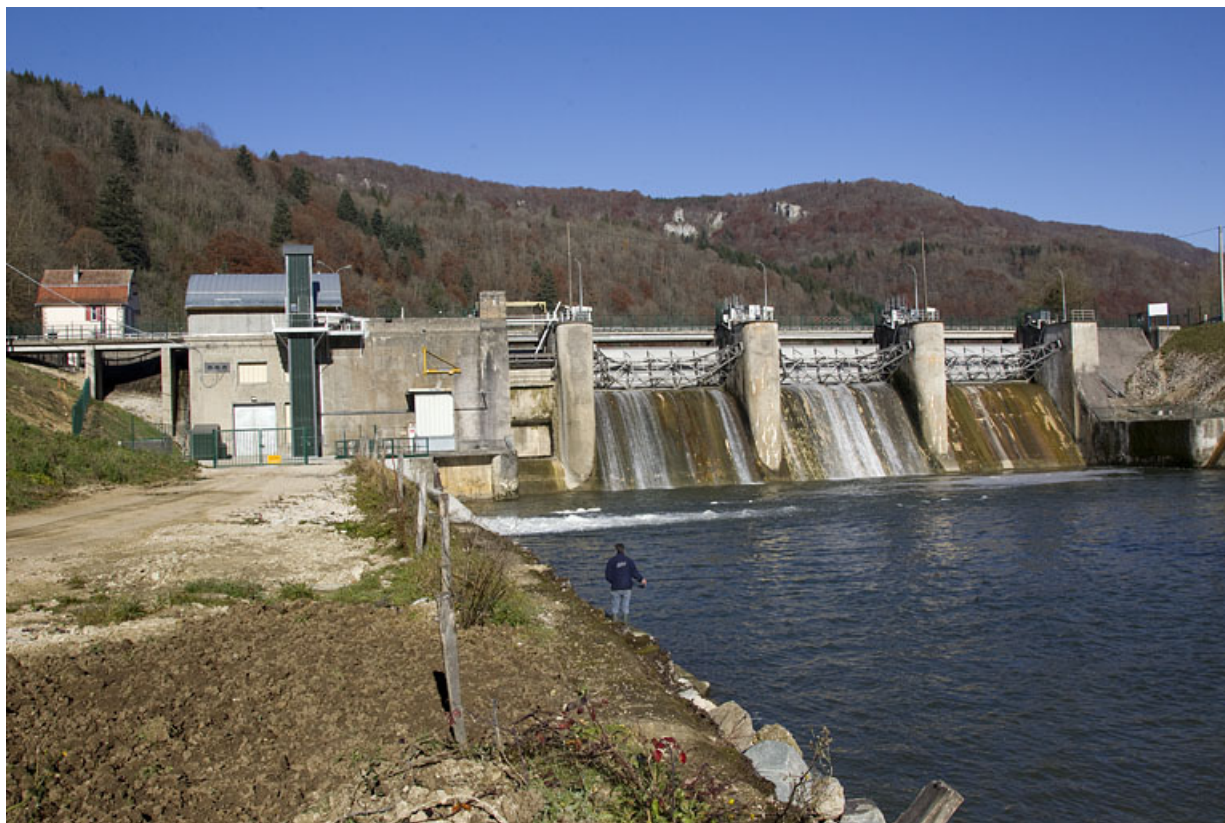
Vue d'ensemble depuis le sud (aval rive droite).
