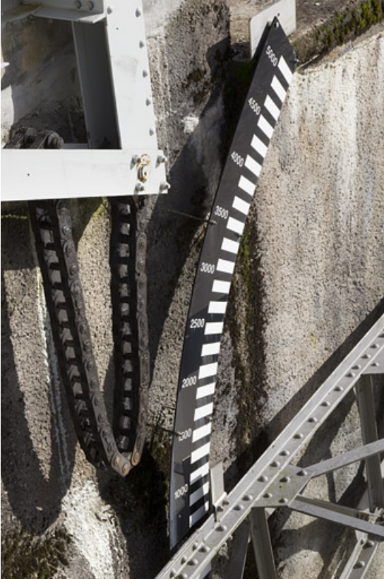
Barrage : repère mesurant l'ouverture d'une vanne secteur.
