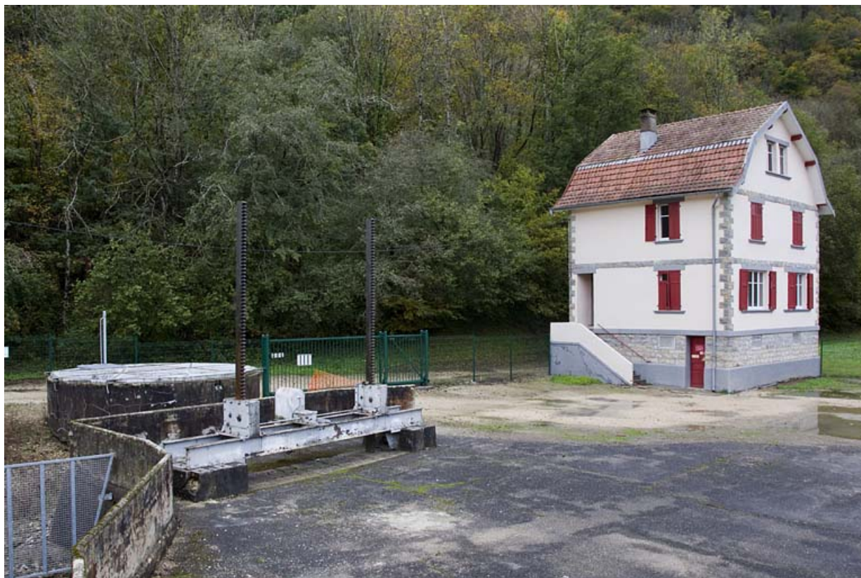
Prise d'eau (commande des vannes de protection) et logement du garde.
