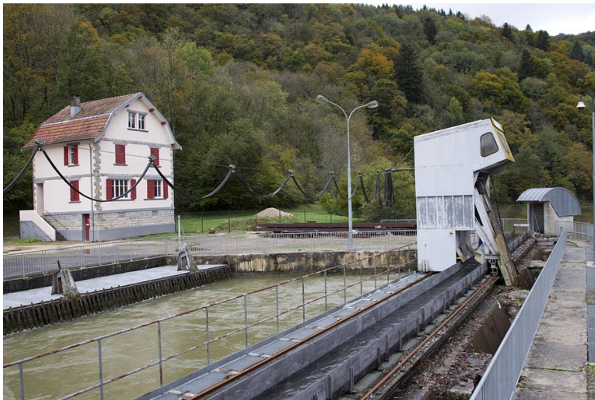
Prise d'eau : vue d'ensemble du dégrilleur.
