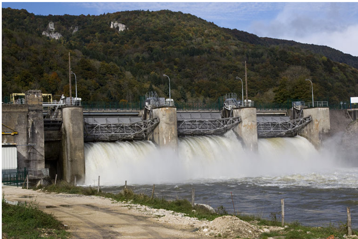
Barrage depuis la rive droite en aval, en période de crue. 25, Soulce-Cernay, lieudit : Gros Bois
