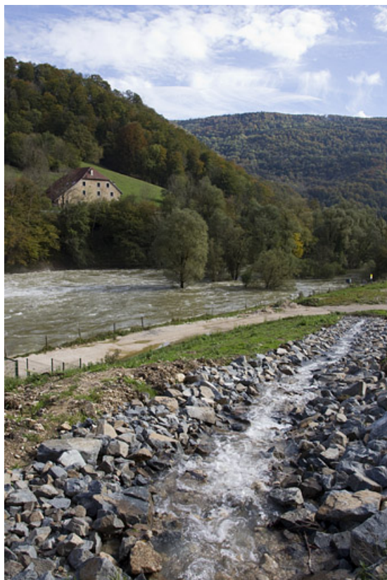
Aménagement pour la dérivation d'un ruisseau, sur la rive droite, en aval du barrage.
