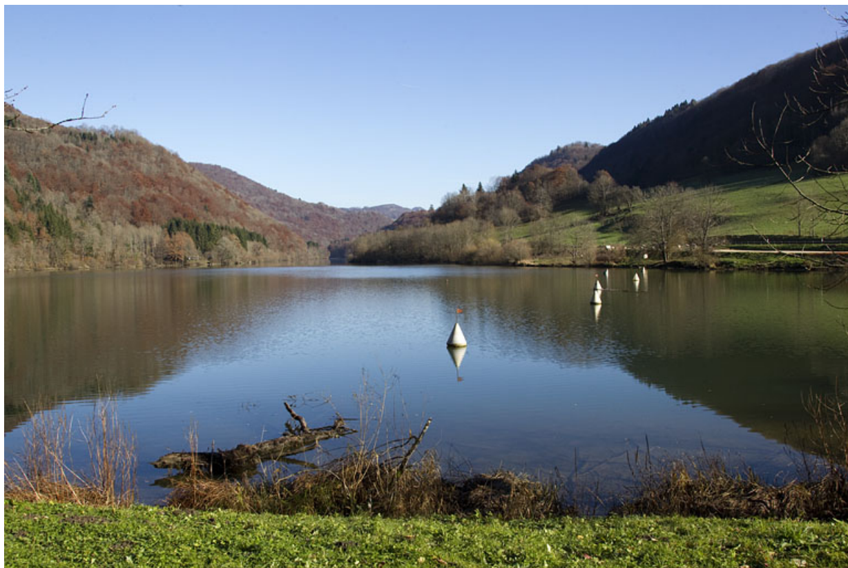
Bassin de retenue depuis la rive droite.
