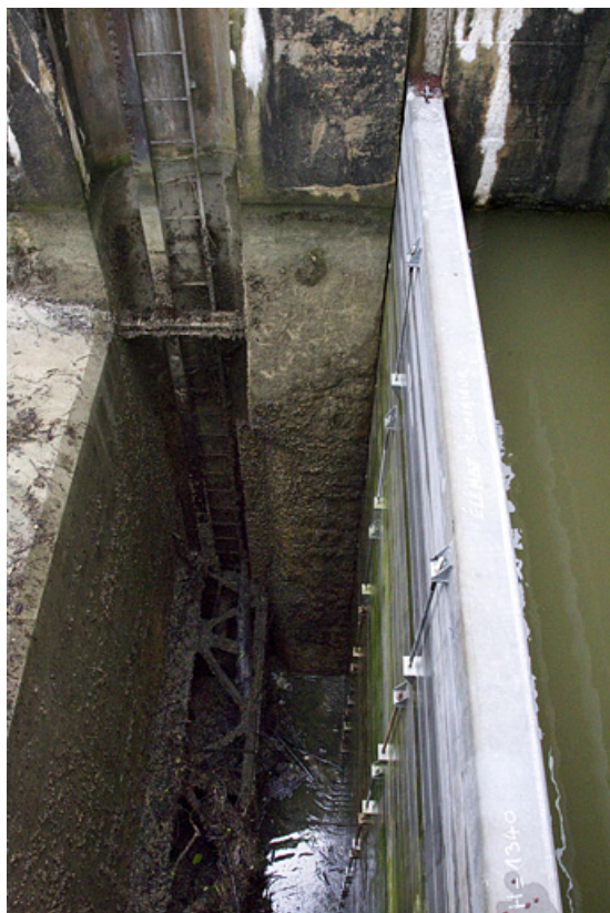
Barrage : atardeau protégeant la vanne clapet en réparation.
