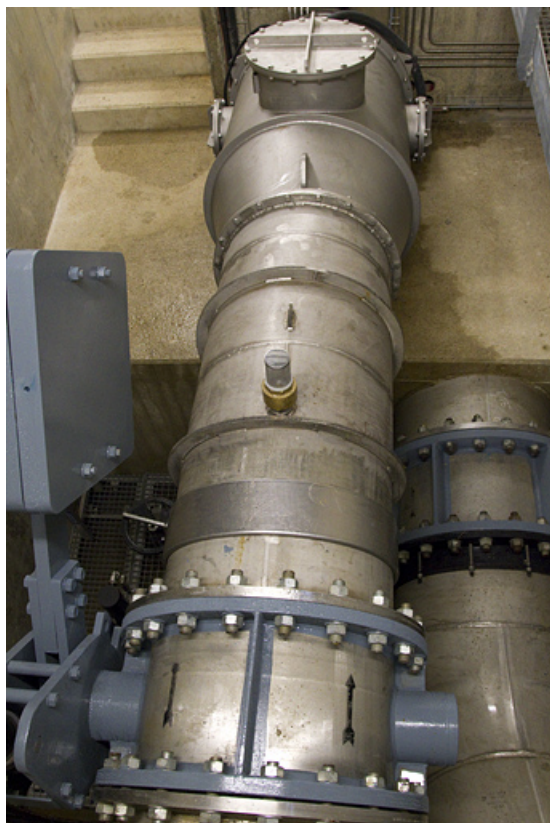
Centrale : nouveau groupe de restitution (vue plongeante). 25, Soulce-Cernay, lieudit : Gros Bois
