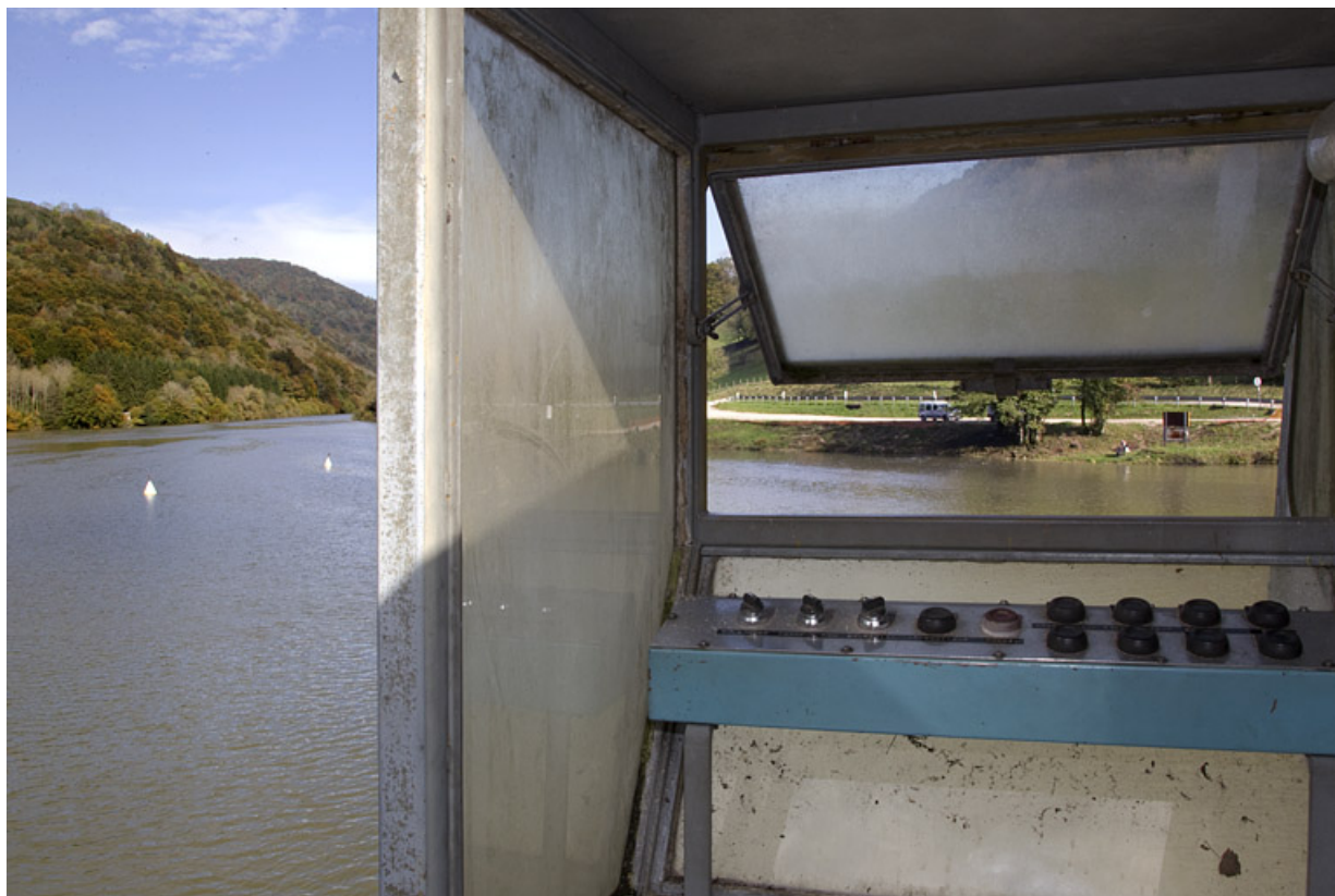
Prise d'eau : poste de commande du dégrilleur.
