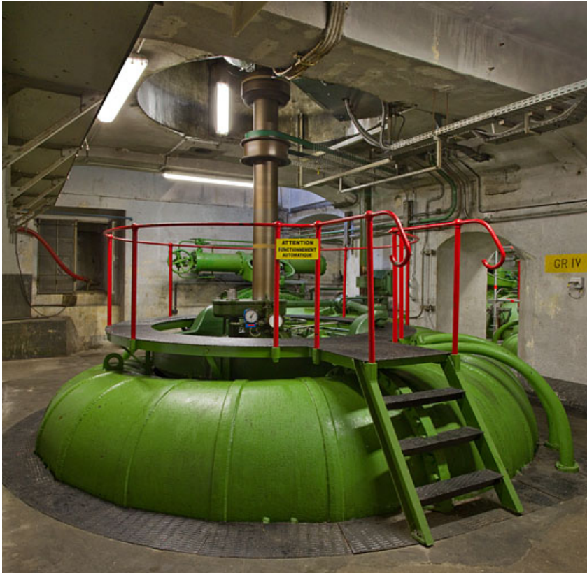
CenTrale : bête de la turbine du groupe n° 4 et axe de transmission, à l'étage de soubassement.
