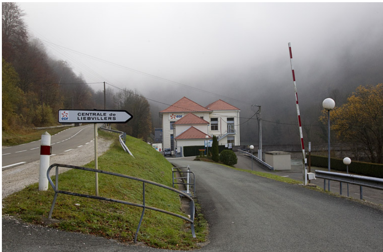
Vue d'ensemble depuis l'ouest (aval rive droite).
