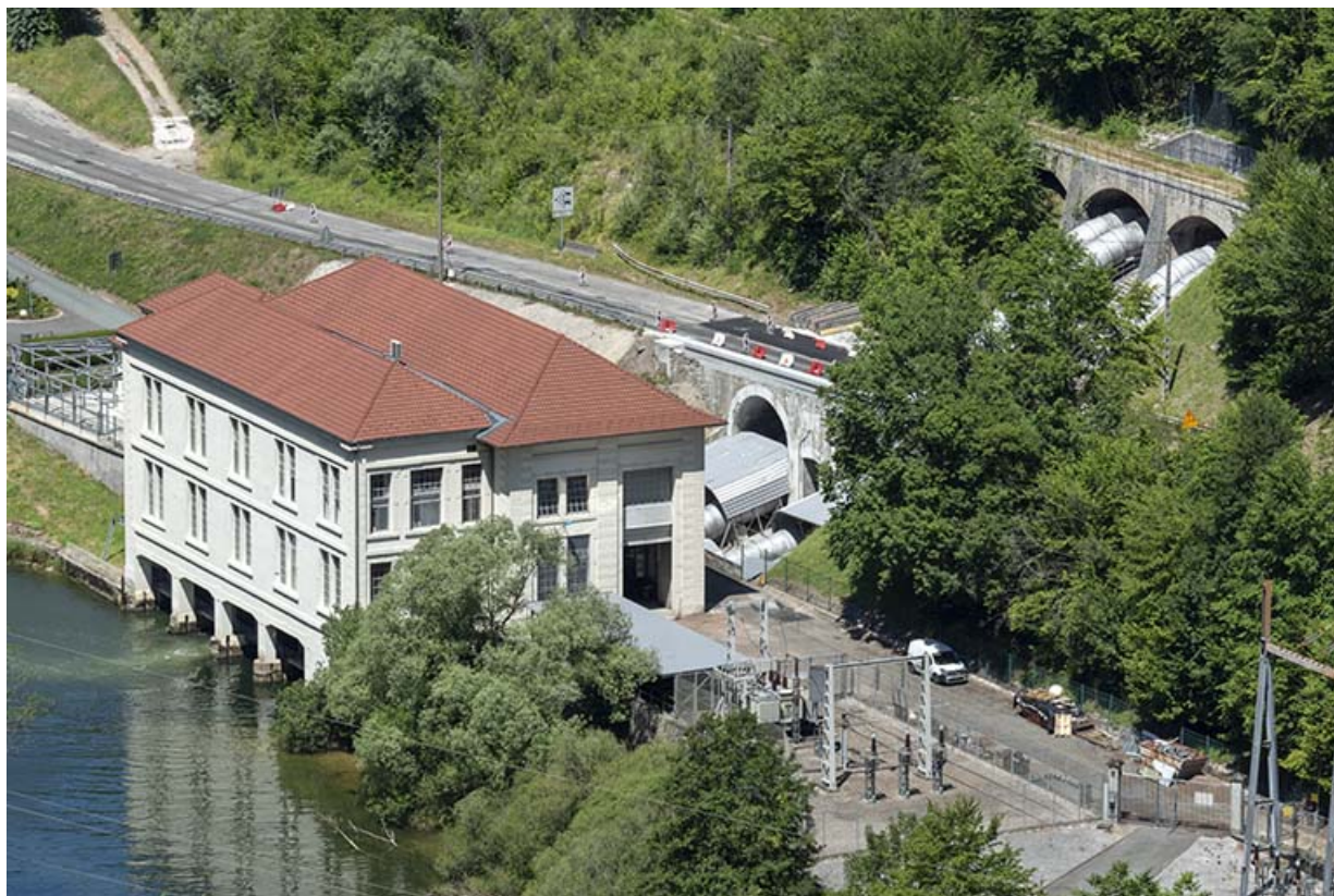
Vue d'ensemble plongeante resserrée, depuis le sud-est.
