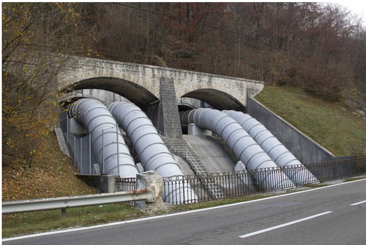
Conduites forcées, entre les ponts de l'ancienne voie ferrée et de la route départementale.
