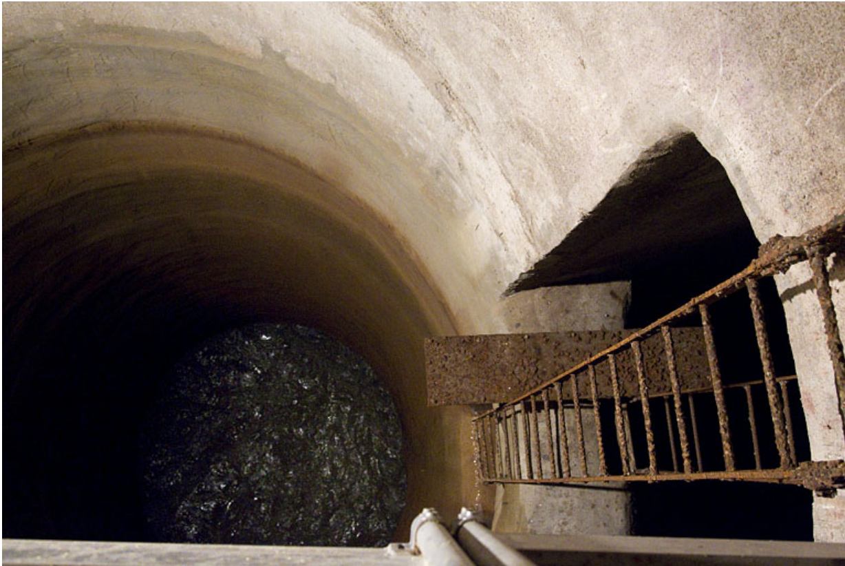
Tunnel d'amenée d'eau : cheminée d'équilibre.
