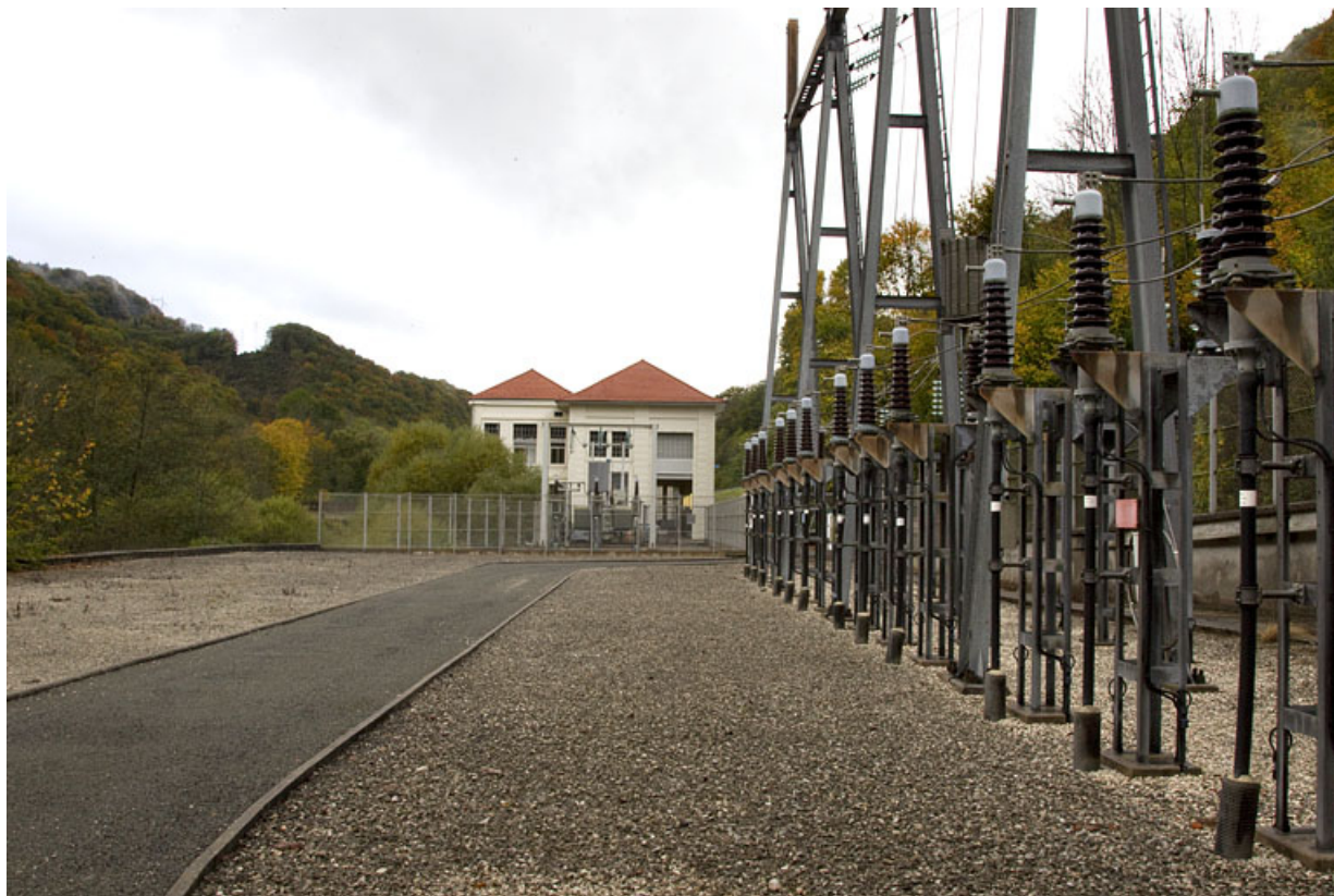
Vue d'ensemble depuis l'est (amont rive droite).
