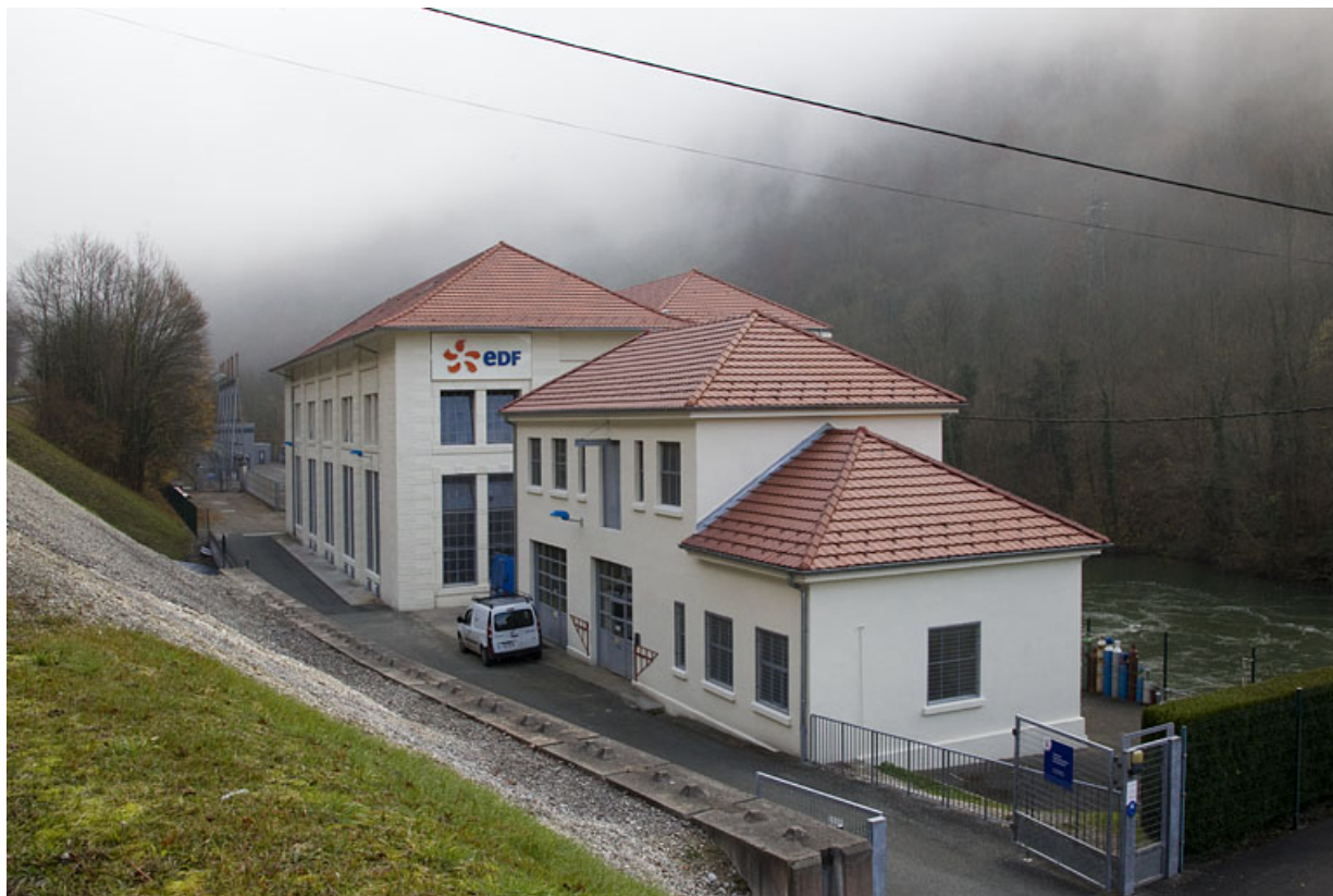
Atelier de réparation et centrale, de trois quarts droite.
