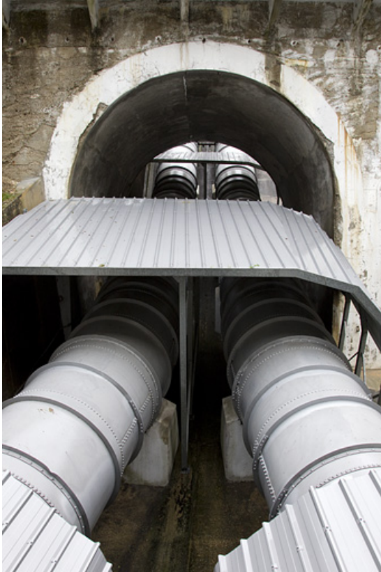
Conduites forcées à la sortie du pont sous la route départementale. 25, Liebvillers, lieudit : Moulin Artus
