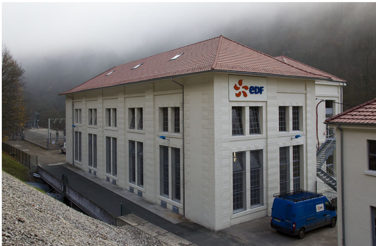
Centrale, de trois quarts droite. 25, Liebvillers, lieudit : Moulin Artus
