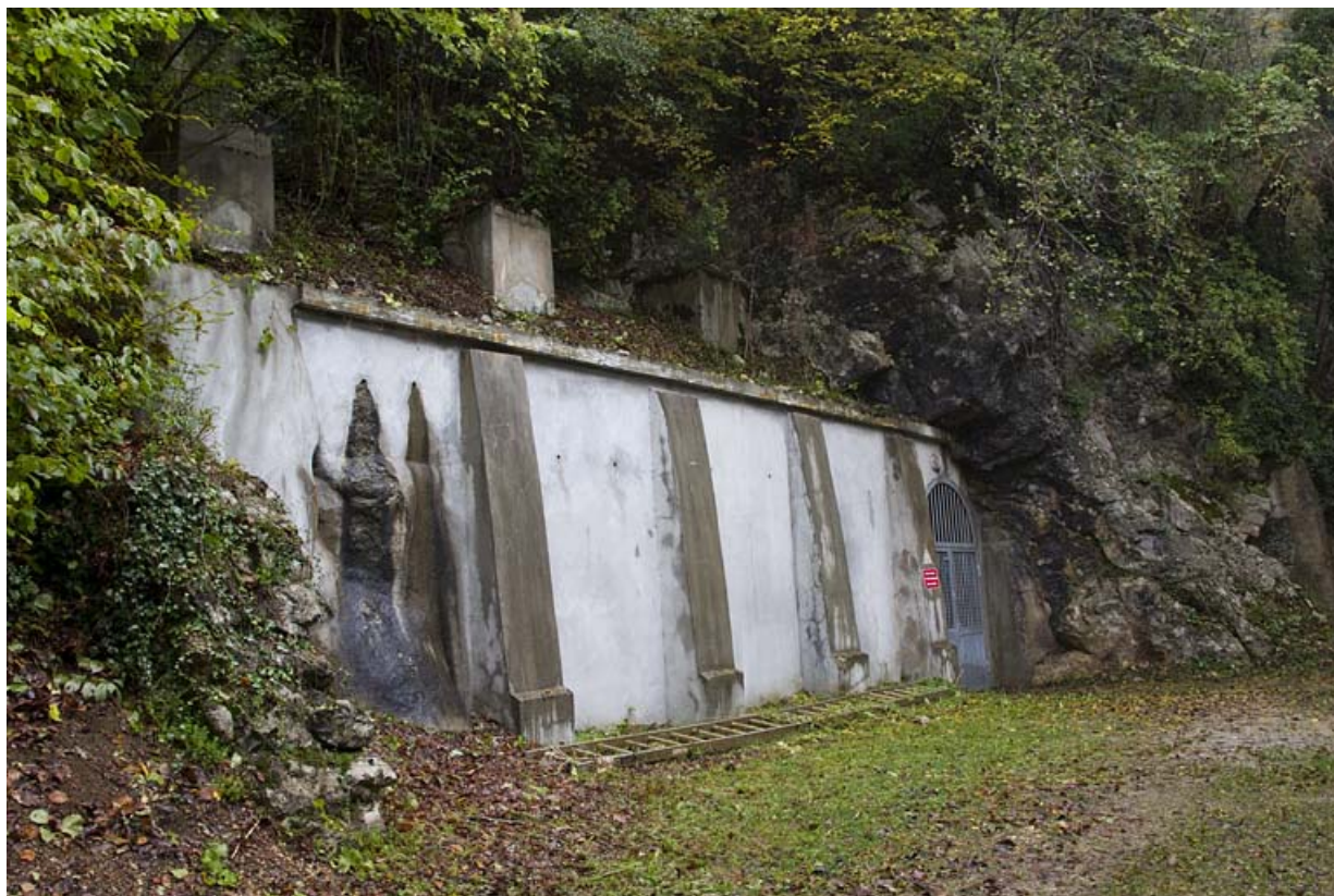
Tunnel d'amenée d'eau : tête aval.
