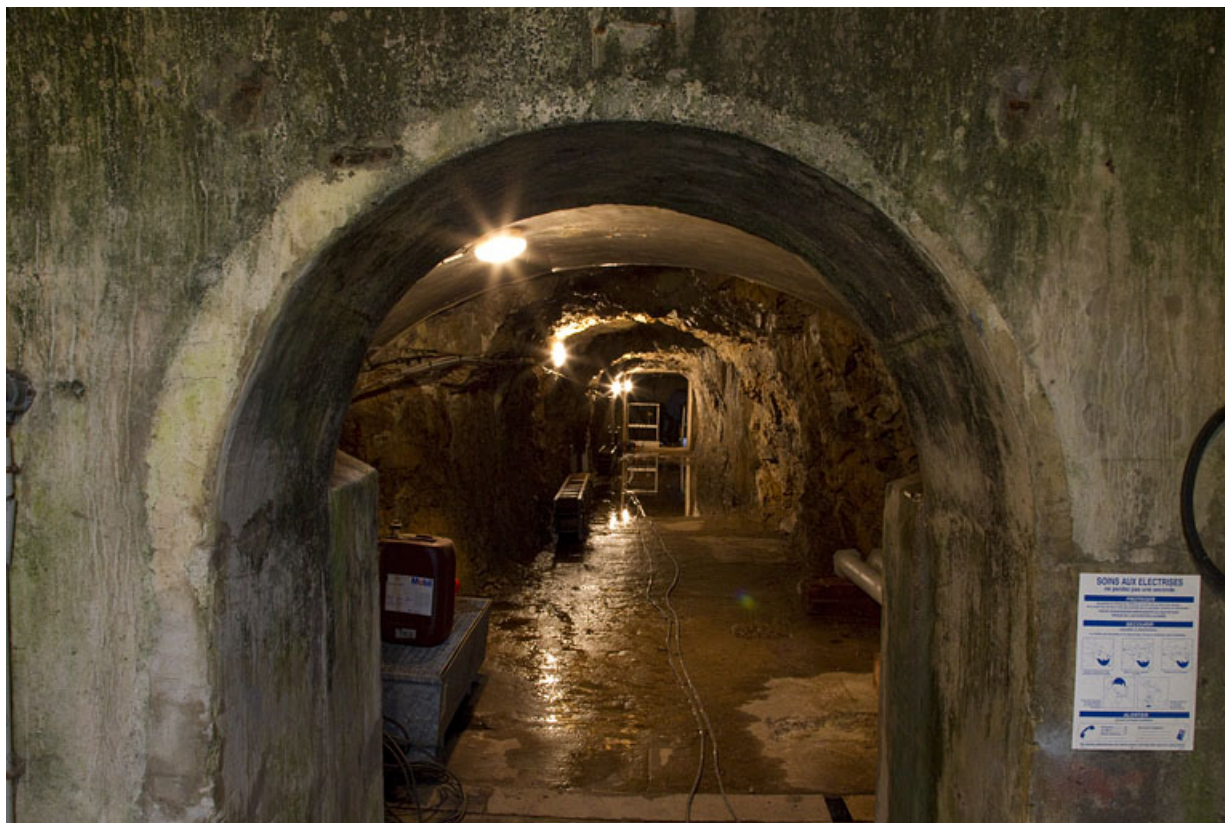
Tunnel d'amenée d'eau : galerie. 25, Liebvillers, lieudit : Moulin Artus
