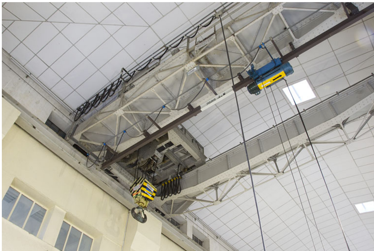
Centrale : face inférieure du pont roulant.
