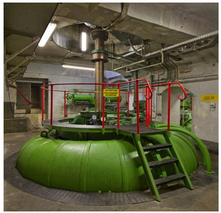
CenTrale : bâche de la turbine du groupe n° 4 et axe de transmission, à l'étage de soubassement.
