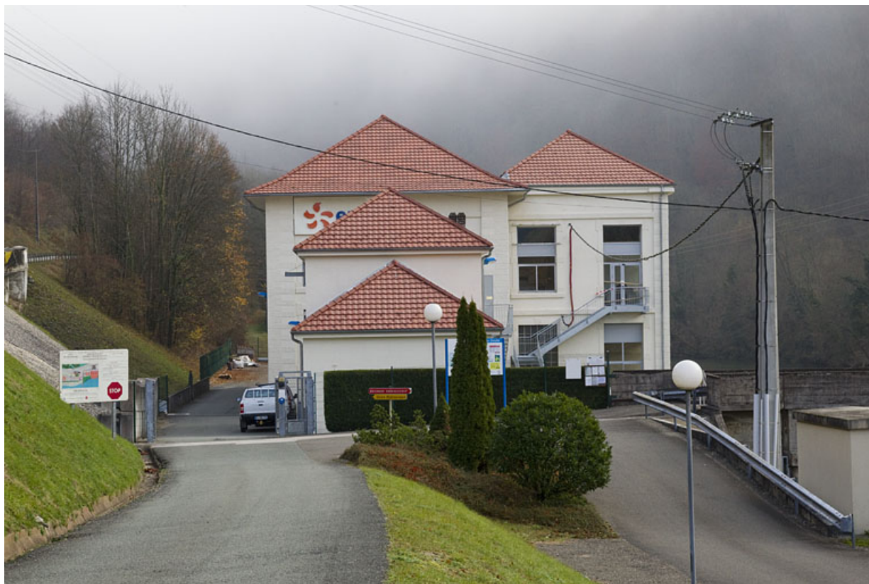
Atelier de réparation et centrale depuis l'ouest (aval rive droite).
