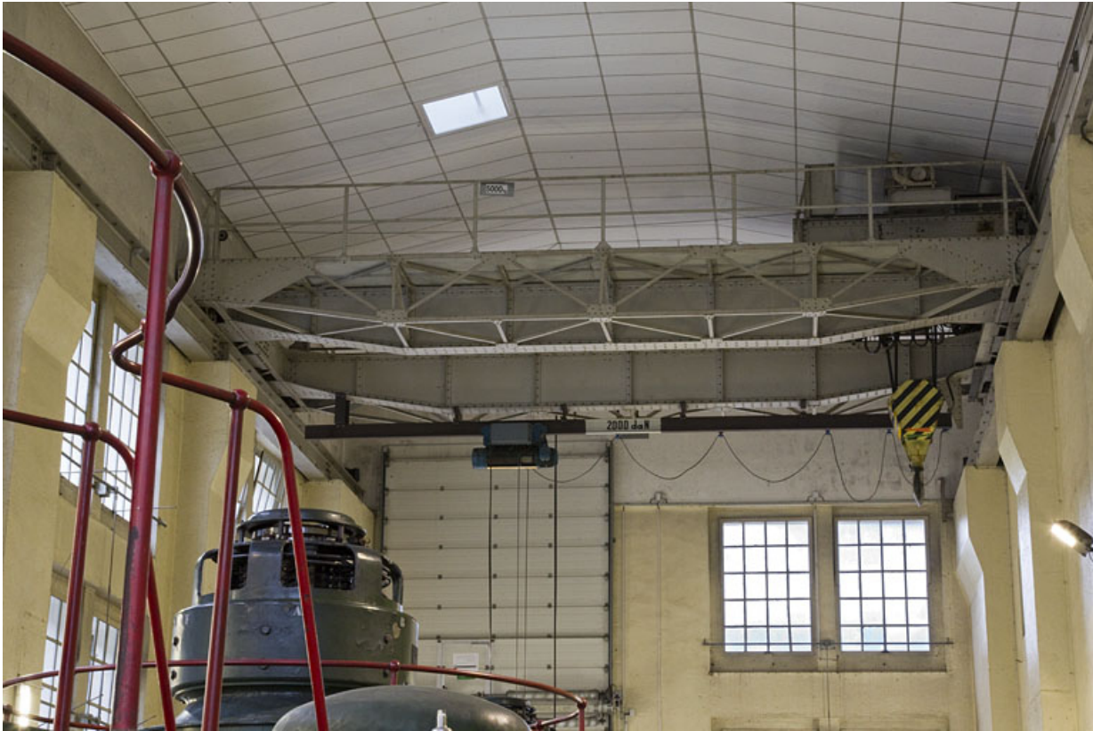
Centrale : pont roulant.
