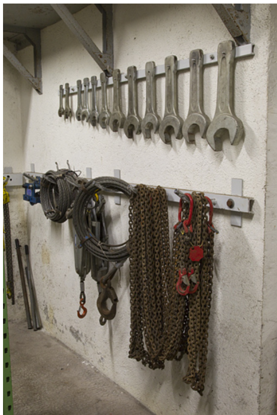
Centrale : ratelier de clefs à l'étage de soubassement. 25, Liebvillers, lieudit : Moulin Artus
