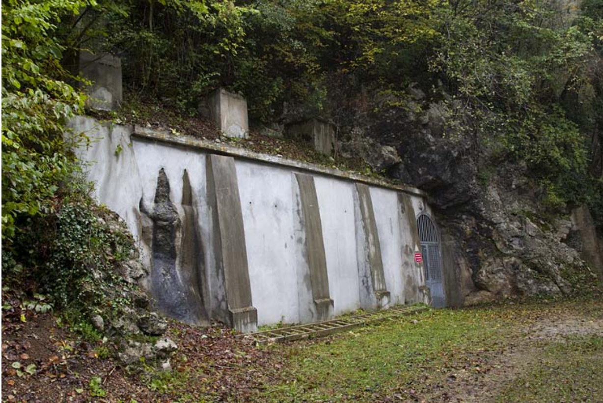
Tunnel d'amenée d'eau : tête aval.
