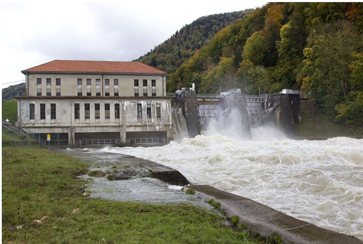
Vue d'ensemble depuis le nord-ouest, en période de crue.
