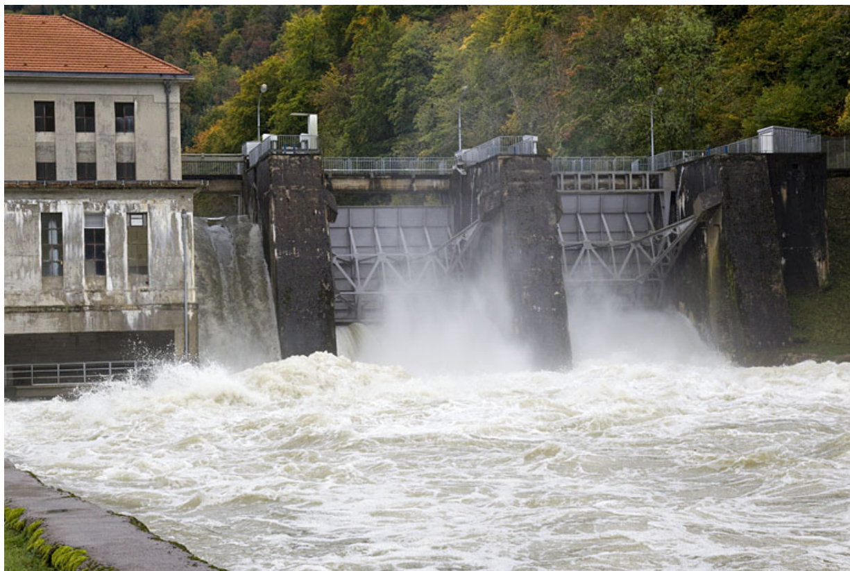
Le barrage vu de l'aval, en période de crue.
