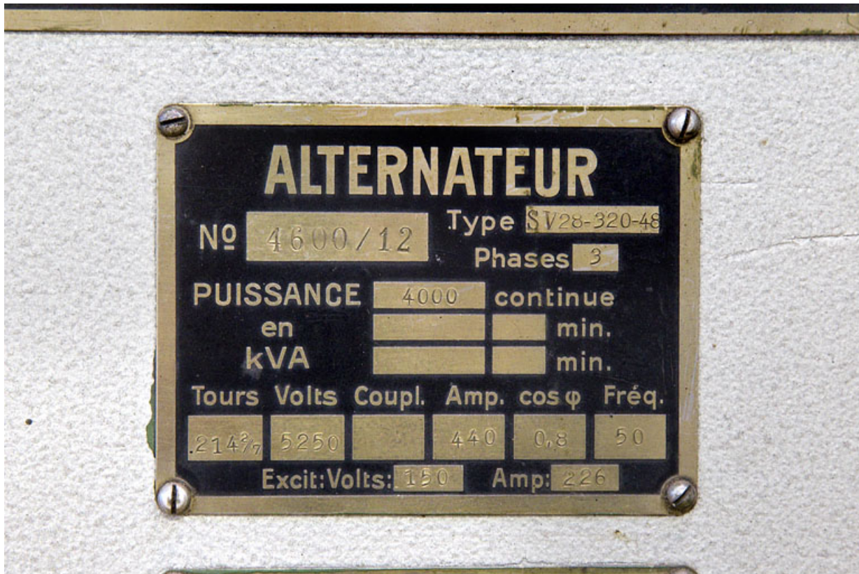
Groupe n° 1 : plaque signalétique de l'alternateur.
