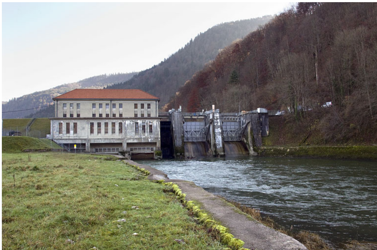
Vue d'ensemble depuis le nord-ouest (aval rive droite).
