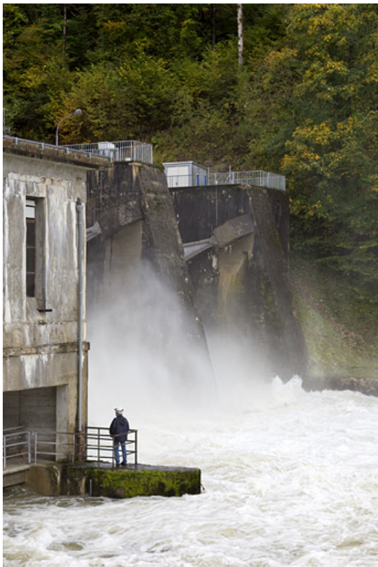
Agent EDF observant les remous à l'aval du barrage, en période de crue.
