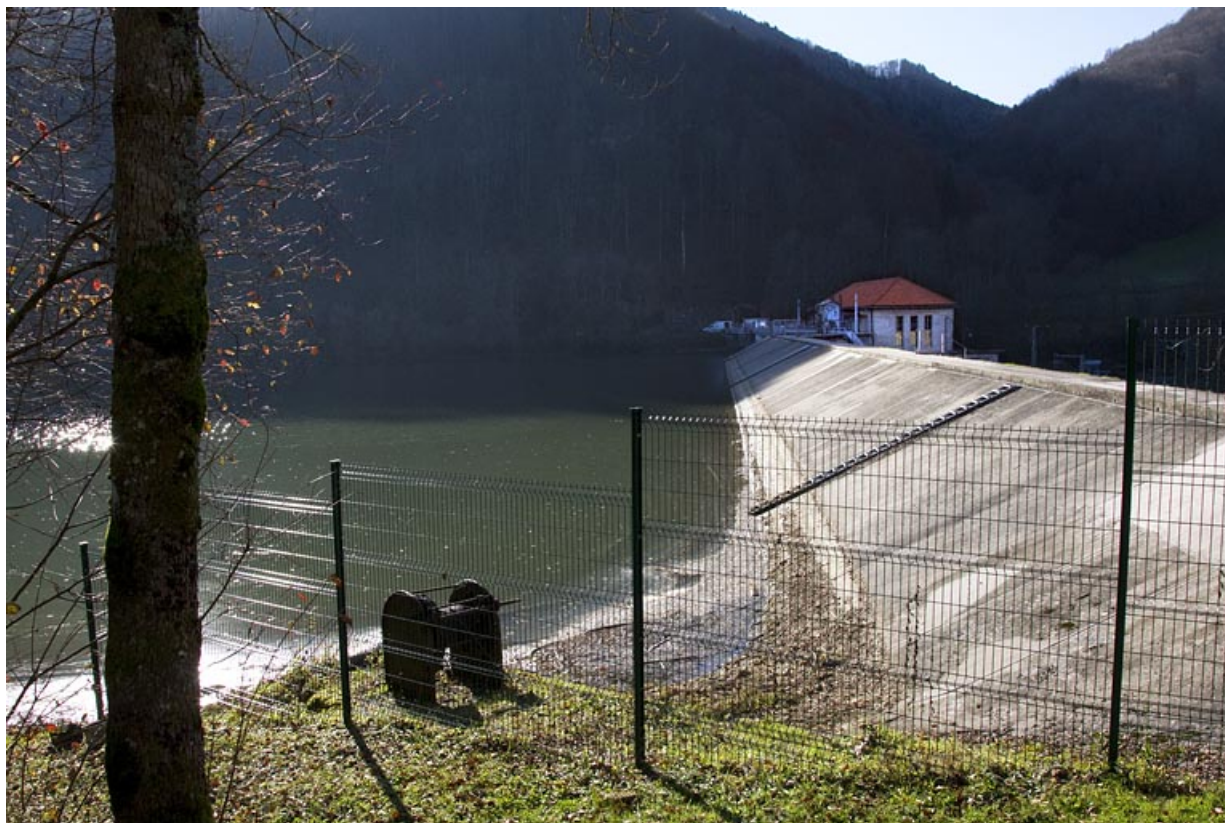
La digue depuis la rive droite.
