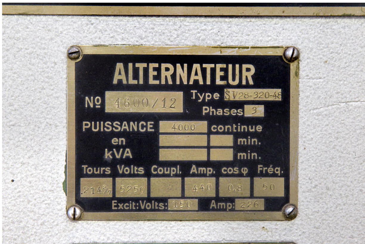
Groupe n° 1 : plaque signalétique de l'alternateur.
