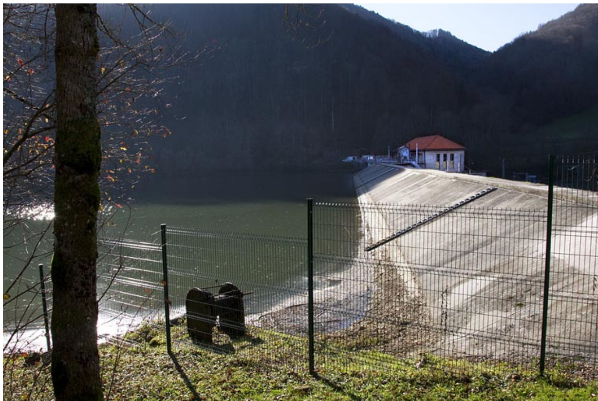
La digue depuis la rive droite.
