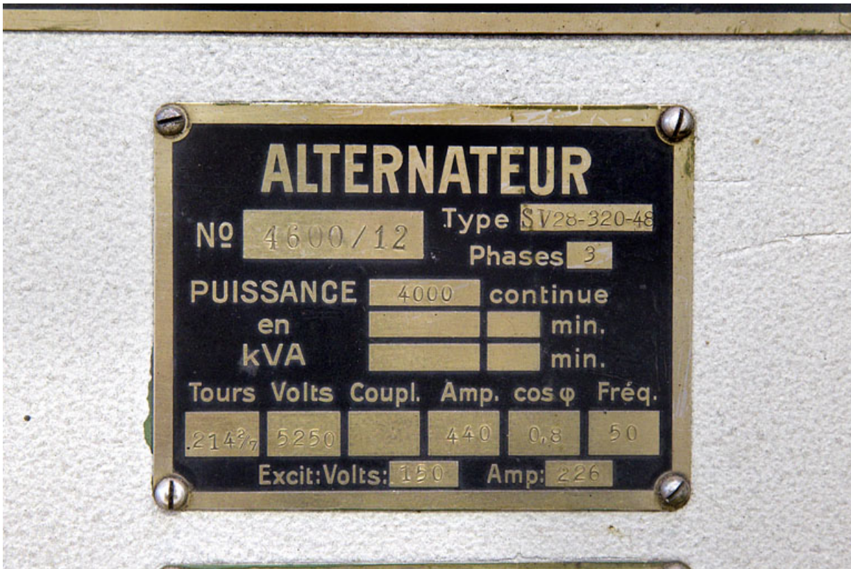
Groupe n° 1 : plaque signalétique de l'alternateur.
