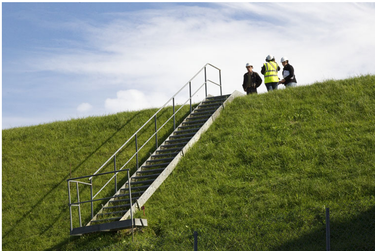
Digue : escalier menant à un puits piézométrique.
