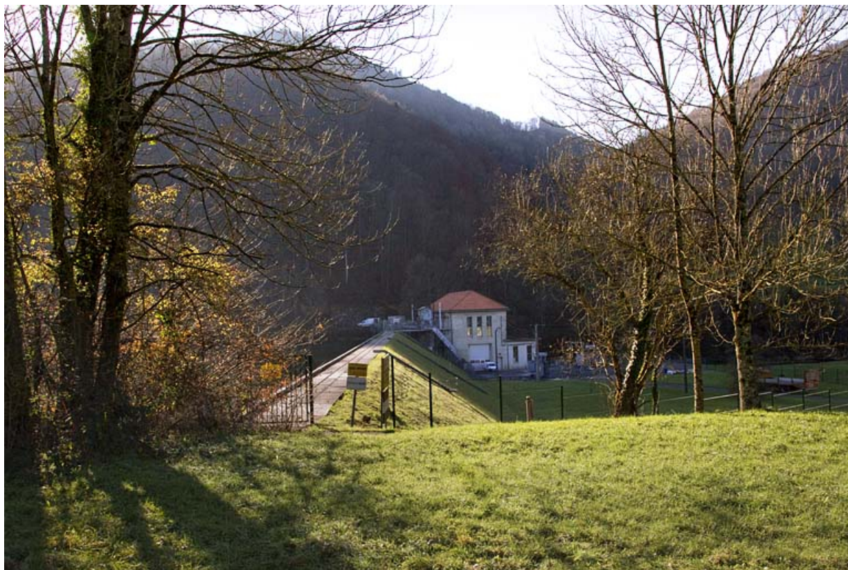
Vue d'ensemble depuis le nord-est (extrémité de la digue rive droite).
