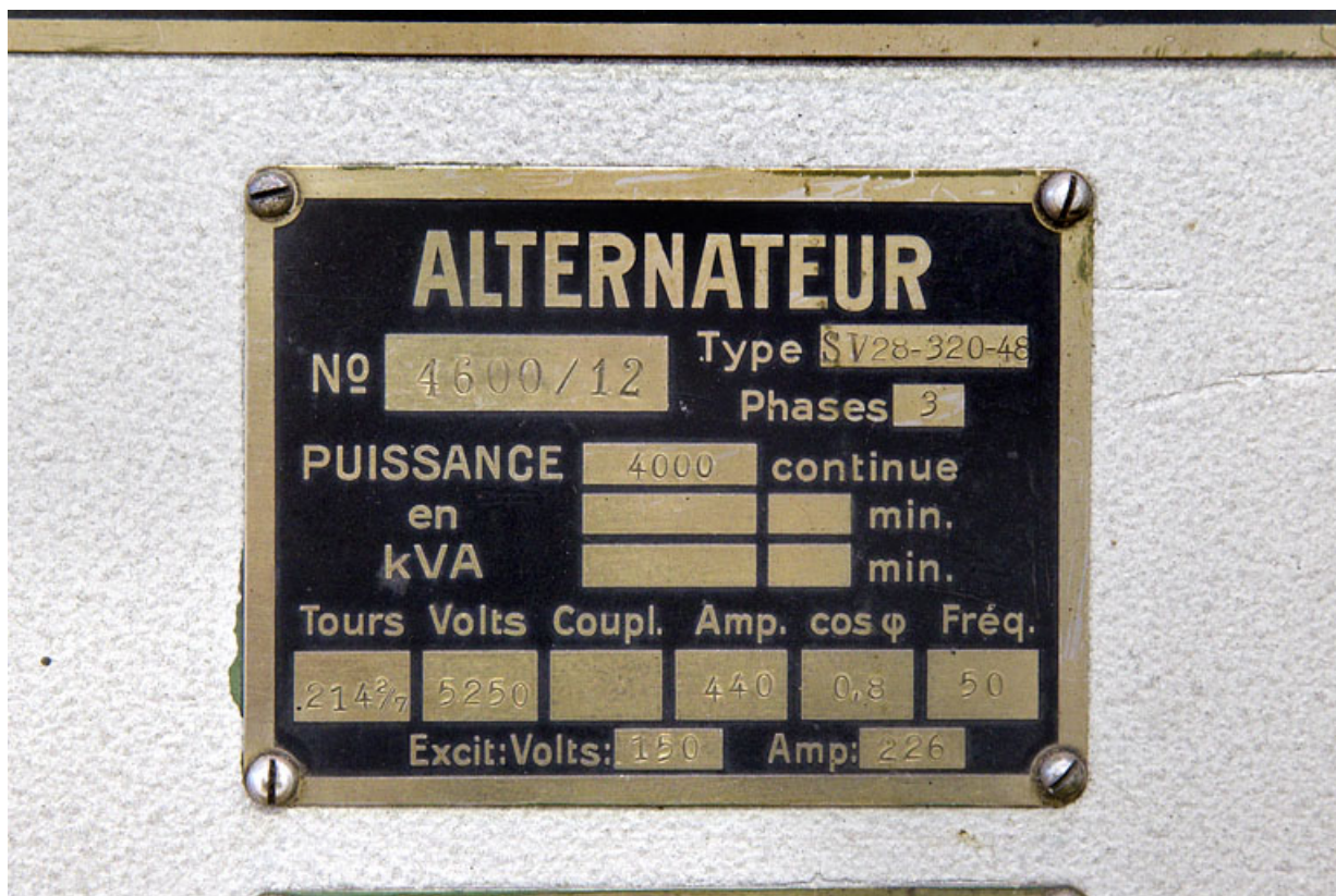
Groupe n° 1 : plaque signalétique de l'alternateur.
